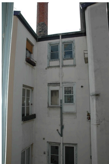
Elévations sur cour Phot. Véronique Belle IVR82_20086902083NUCA
