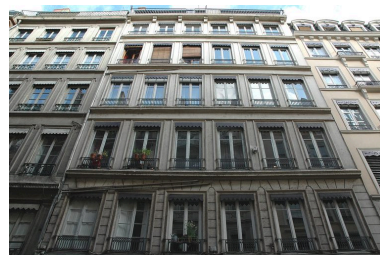
Elévation antérieure : les étages carrés Phot. Véronique Belle IVR82_20086902901NUCA
