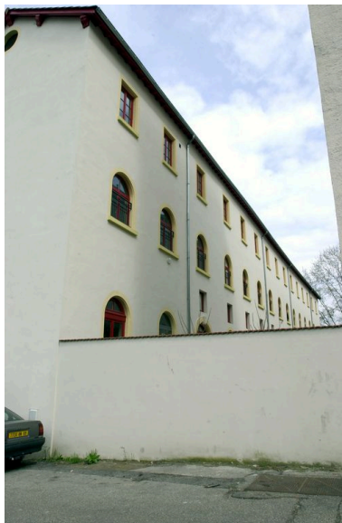
Ancienne aile du couvent- usine actuellement logements Phot. Bernard Ducouret IVR82_20046902115NUCA
