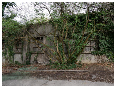
Anciens ateliers de la distillerie des Trappistines Phot. Nadine Halitim-Dubois IVR84_20246900656NUCA
