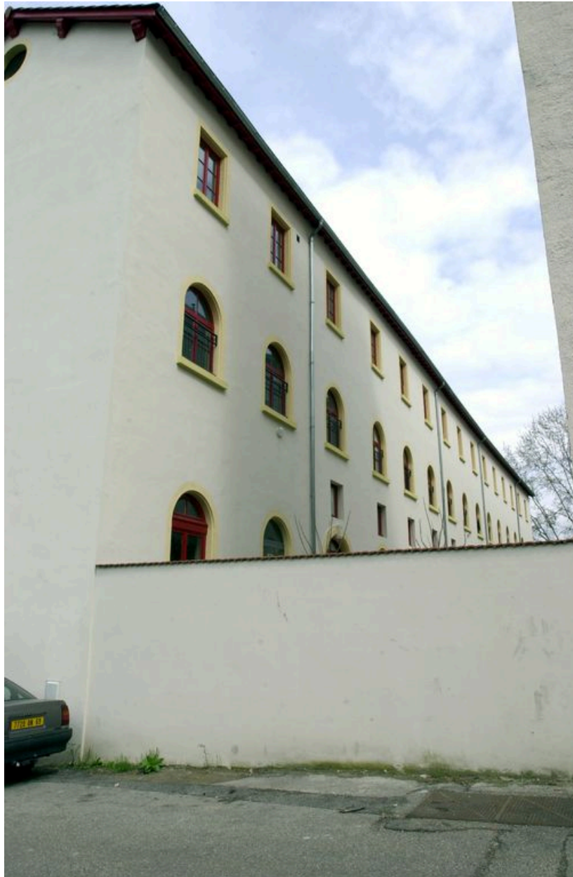
Ancienne aile du couvent-usine actuellement logements
