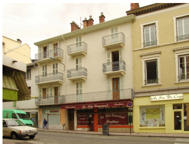
Façade sur la rue de Chambéry Phot. François Fouger IVR82_20067300757NUCA
