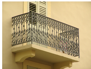
Détail d'un balcon Phot. François Fouger IVR82_20067300754NUCA
