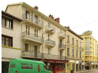
Vue d'ensemble Phot. François Fouger IVR82_20067300753NUCA
