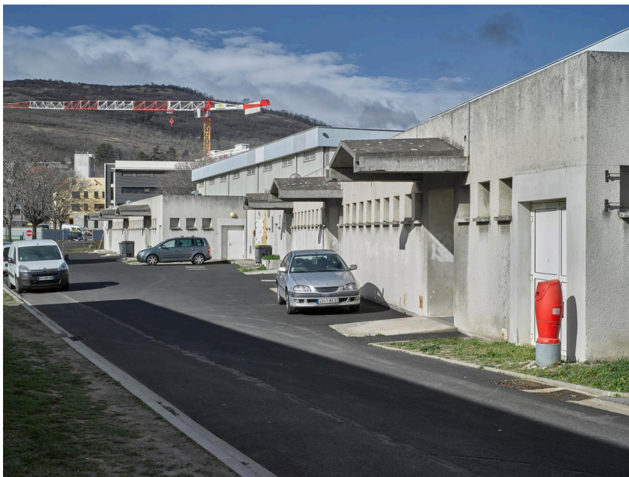
Les deux gymnases : façades sud.
