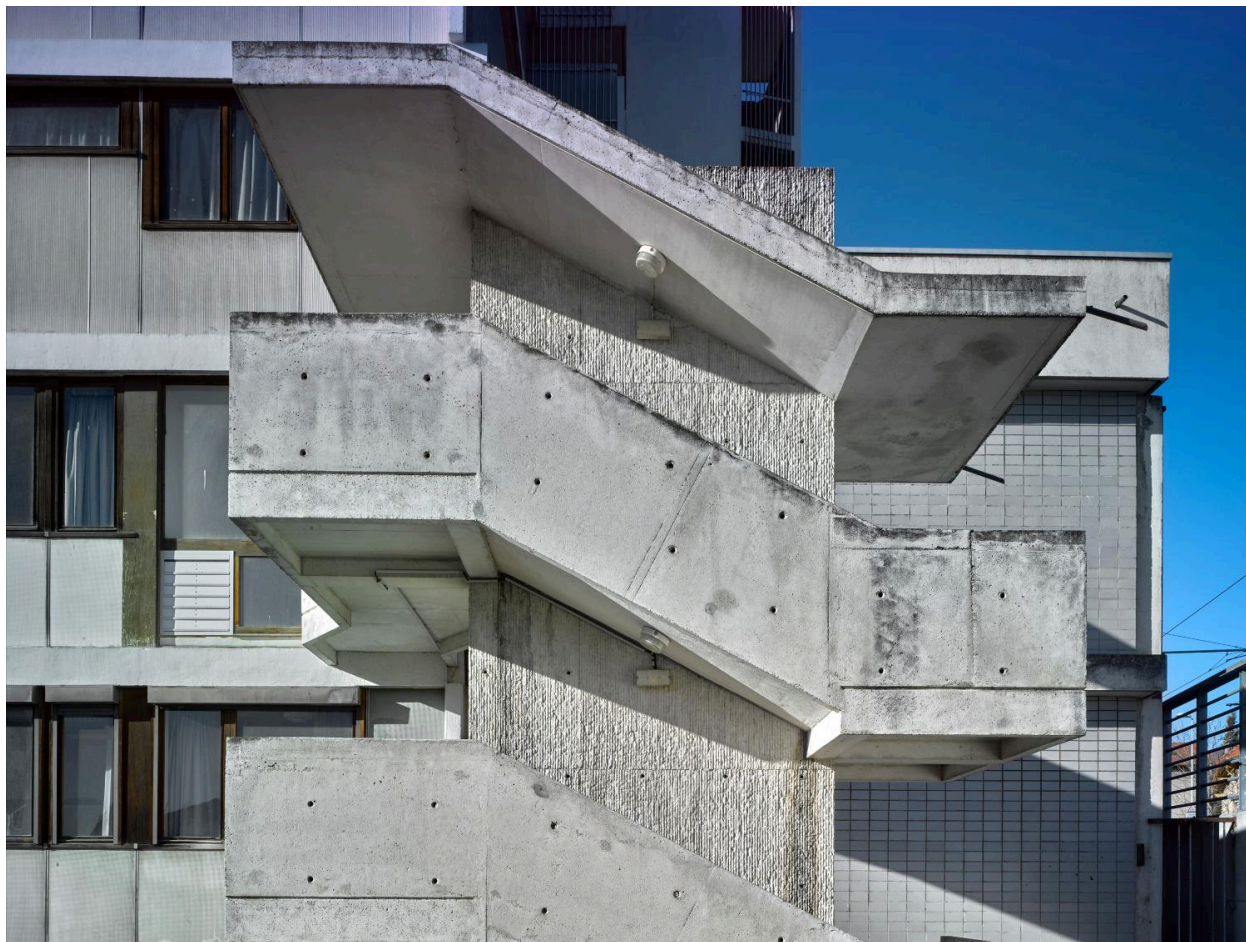
Escalier extérieur, situé au nord du bâtiment E. Détail sur le jeu de lignes.
