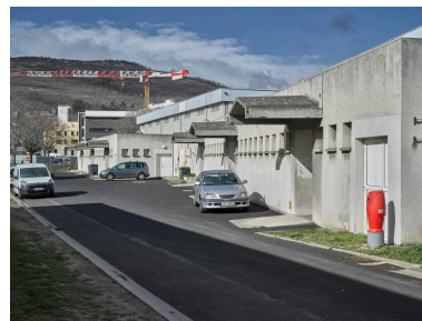
Les deux gymnases : façades sud. Phot. Christian Parisey IVR84_20206300579NUC4A
