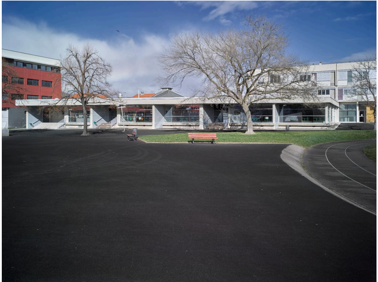
Vue du bâtiment C (réfectoire).
