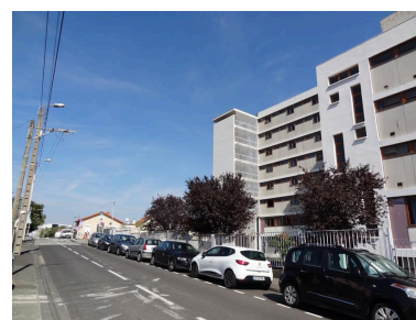
Depuis la rue des Planchettes, vue sur la tour d'escalier dont l'élévation sud est ouverte Phot. Bénédicte Renaud-Morand IVR84_20216300048NUCA
