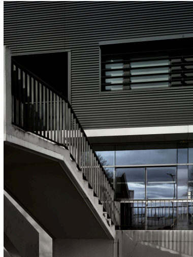
Détail de l'escalier tournant extérieur du bâtiment B. Point de vue du photographe. Phot. Christian Parisey IVR84_20206300577NUC4A
