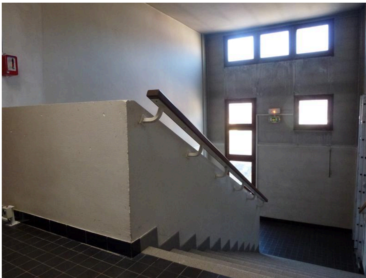
Bâtiment D, cage d'escalier. (Photo chercheur.)
