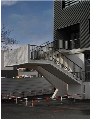
Escalier extérieur au sud du bâtiment B. Phot. Christian Parisey IVR84_20206300578NUC4A
