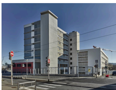
Vue depuis le carrefour formé par les rues du Docteur-Bousquet et des Planchettes. Bâtiments D et E. Et au premier plan, la tour d'escalier qui n'apparaissait pas sur le plan d'exécution de 1961 mais avait été construite avant 1967 (voir plan des gymnases daté de 1967). Phot. Christian Parisey IVR84_20206300013NUCA
