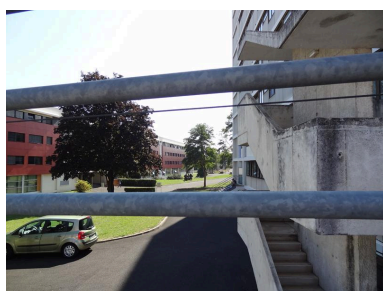
Depuis la rue du Docteur-Bousquet : au 1er plan, escalier extérieur du bâtiment D ; au centre, oeuvre du 1 er artistique ; à l'arrière-plan, bâtiment des classes et du CDI, dont l'isolation par l'extérieur a abouti au refaçadage couleur rouille Phot. Bénédicte Renaud-Morand IVR84_20216300049NUCA
