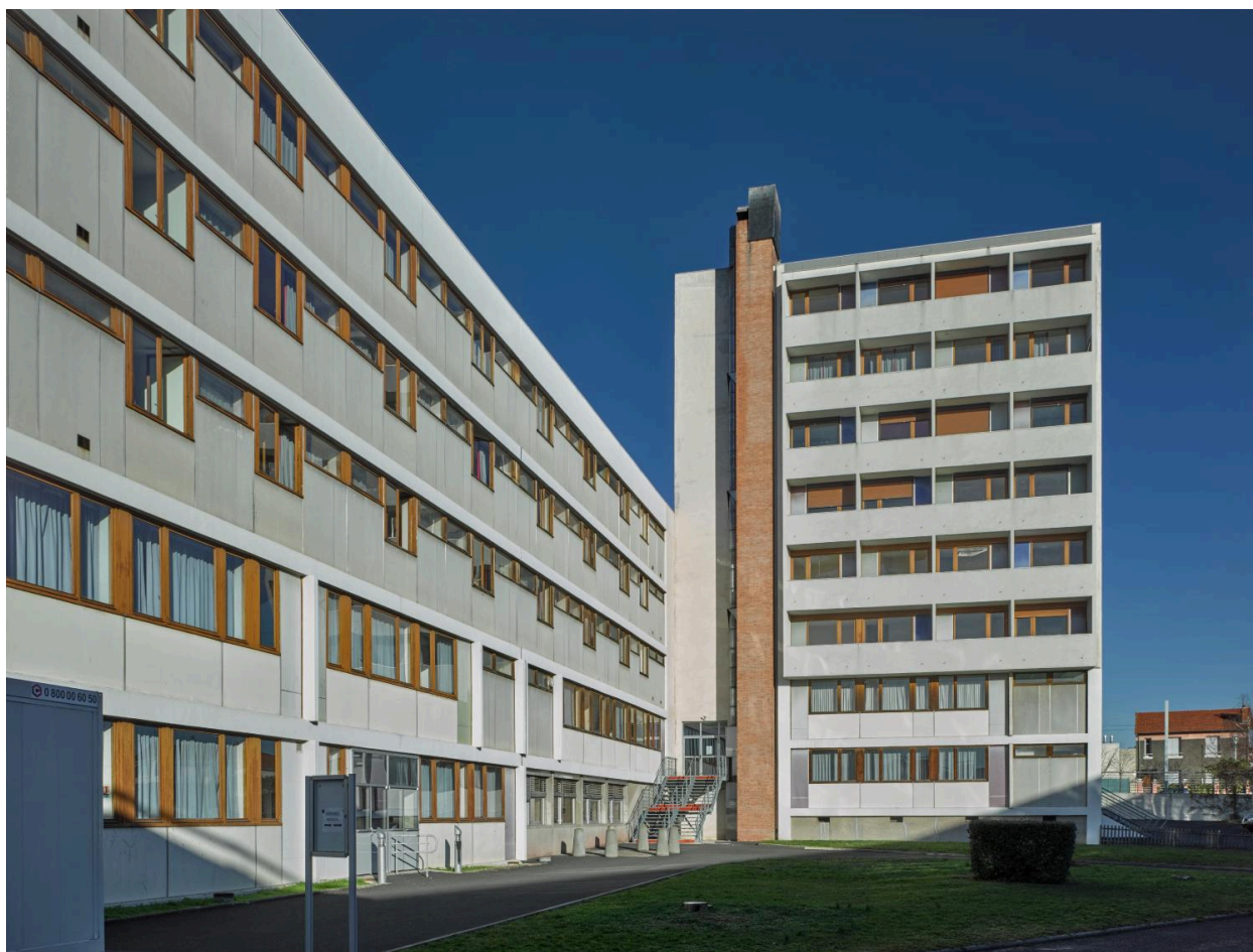
Vue sur les bâtiments D et E depuis le sud.
