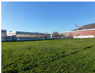
Depuis la terrain de sport, au fond, le bâtiment B, à gauche, les élévations arrière des deux gymnases Phot. Bénédicte Renaud-Morand IVR84_20216300052NUCA
