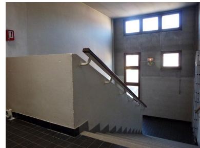
Bâtiment D, cage d'escalier. (Photo chercheure.) Phot. Bénédicte Renaud-Morand IVR84_20216300053NUCA
