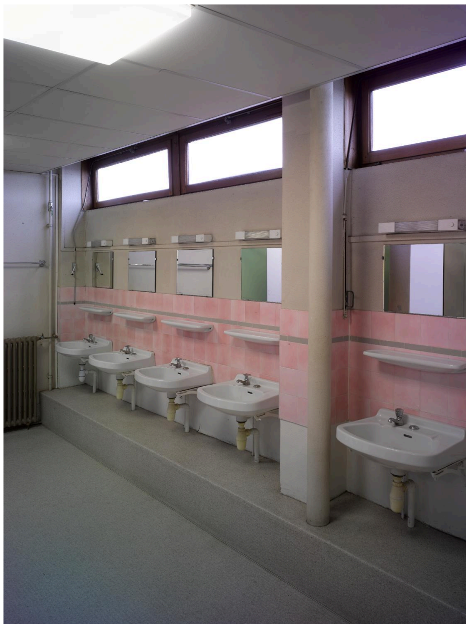
Bâtiment D, 7e étage. Paroi est : lavabos.
