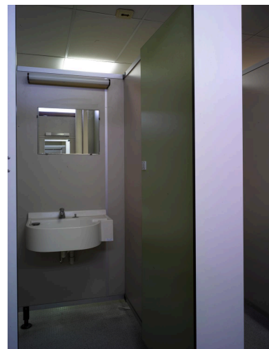
Bâtiment D (voué à la démolition), 7e étage. Sanitaires : cabine (sur pieds) avec lavabo en matière plastique. Phot. Christian Parisey IVR84_20206300575NUC4A
