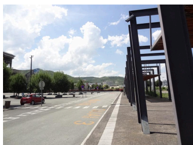
Vue vers le lycée depuis le parc de stationnement "Les pistes" : au fond, de biais, le bâtiment D du lycée, haut de sept étages, joue un rôle de repère. Il devrait être reconstruit mais plus bas Phot. Bénédicte Renaud-Morand IVR84_20216300060NUCA
