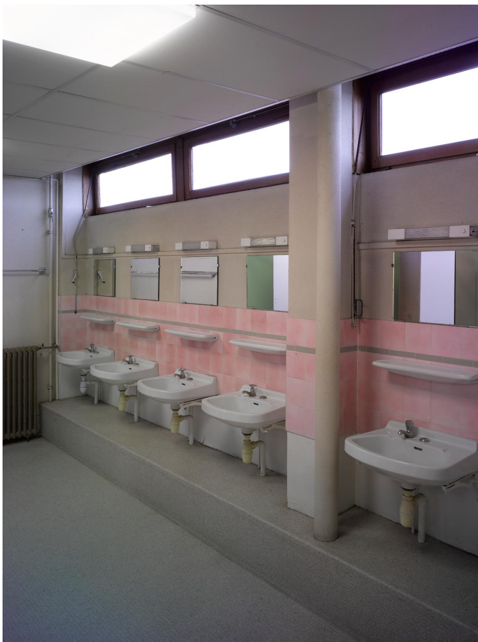
Bâtiment D, 7e étage. Paroi est : lavabos.
