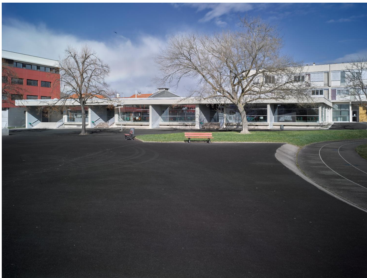
Vue du bâtiment C (réfectoire).
