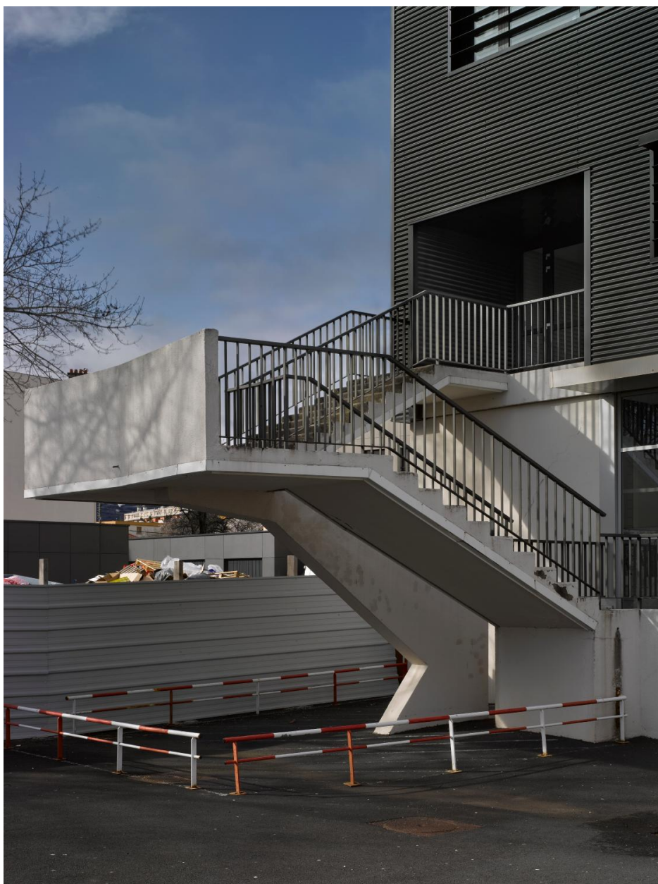
Escalier extérieur au sud du bâtiment B.
