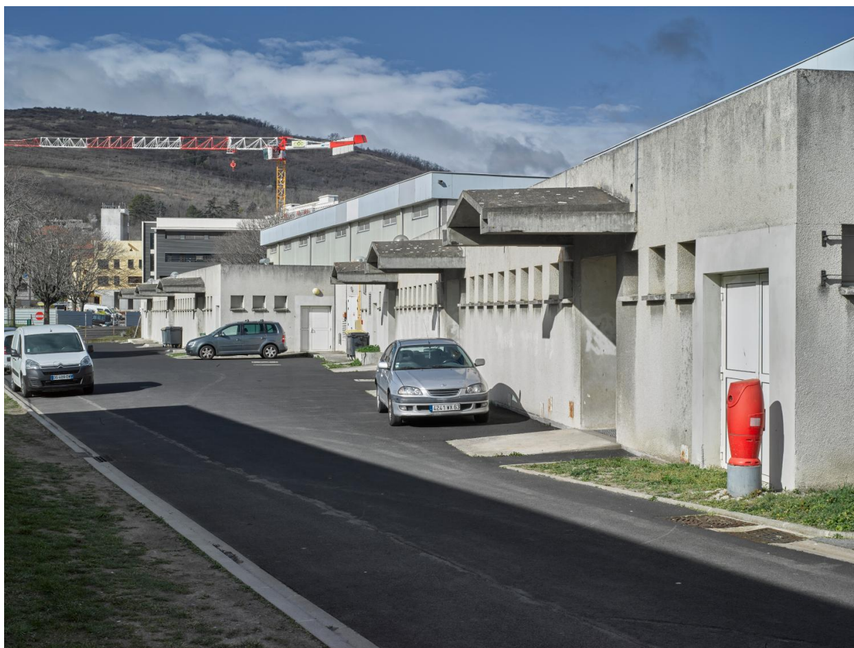
Les deux gymnases : façades sud.
