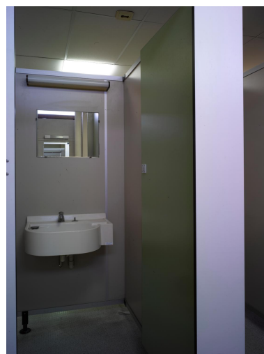
Bâtiment D (voué à la démolition), 7 e étage. Sanitaires : cabine (sur pieds) avec lavabo en matière plastique. Phot. Christian Parisey IVR84_20206300575NUC4A
