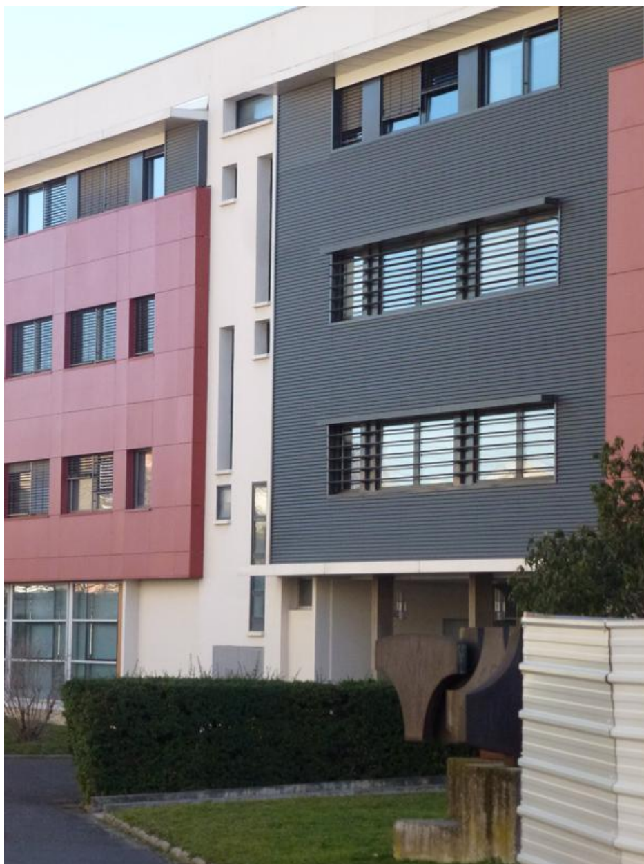
Détail du bâtiment B (classes et CDI) montrant la surépaisseur du refaçadage par rapport à la travée d'origine (travée d'éclairage d'un l'escalier). (Photo chercheure.)
