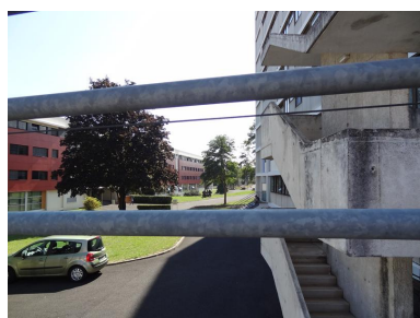
Depuis l'extérieur de l'établissement, rue du Docteur-Bousquet : au premier plan, escalier extérieur du bâtiment D ; au centre, oeuvre du 1% artistique ; à l'arrière-plan, bâtiment des classes et du CDI, dont l'isolation par l'extérieur a abouti au refaçadage couleur rouille. (Photo chercheure.)
