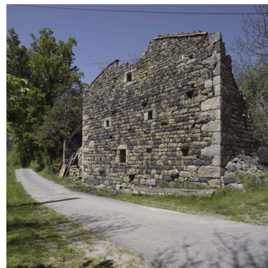
Bâtiments agricoles en ruine : mur pignon avec remplois (1986 AL 220). Phot. Eric Dessert IVR82_20084201250NUCA
