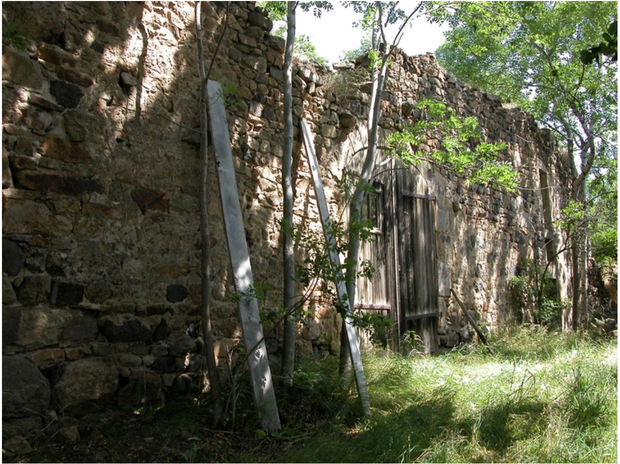
Bâtiments agricoles en ruine : grange (1986 AL 220).
