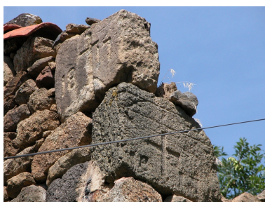
Détail des moellons d'angle datés (1986 AL 220). Phot. Caroline Guibaud IVR82_20124201097NUCA
