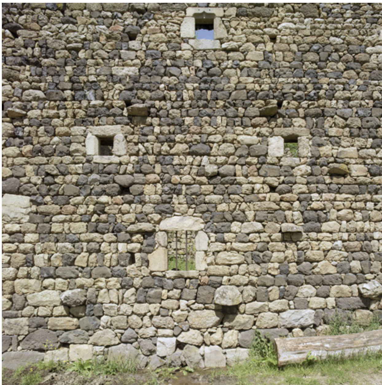
Bâtiments agricoles en ruine : mur pignon avec remplois, détail des matériaux (1986 AL 220).
