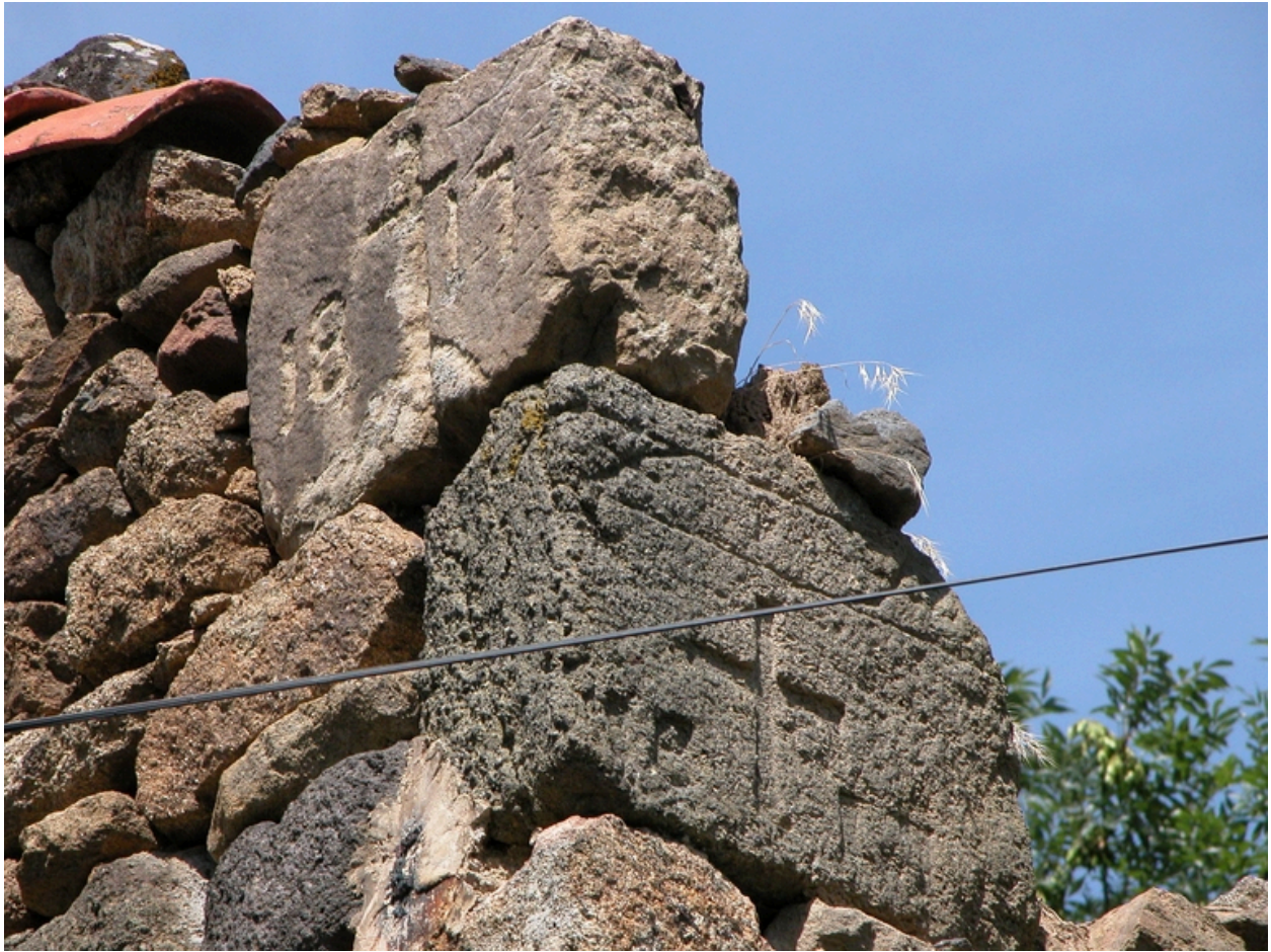
Détail des moellons d'angle datés (1986 AL 220).
