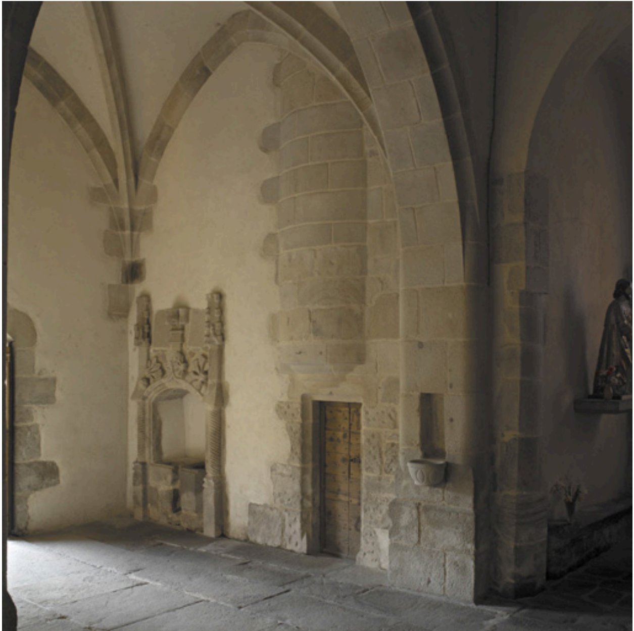
Vue du mur nord de la travée sous le clocher : porte et escalier du clocher, fonts baptismaux.
