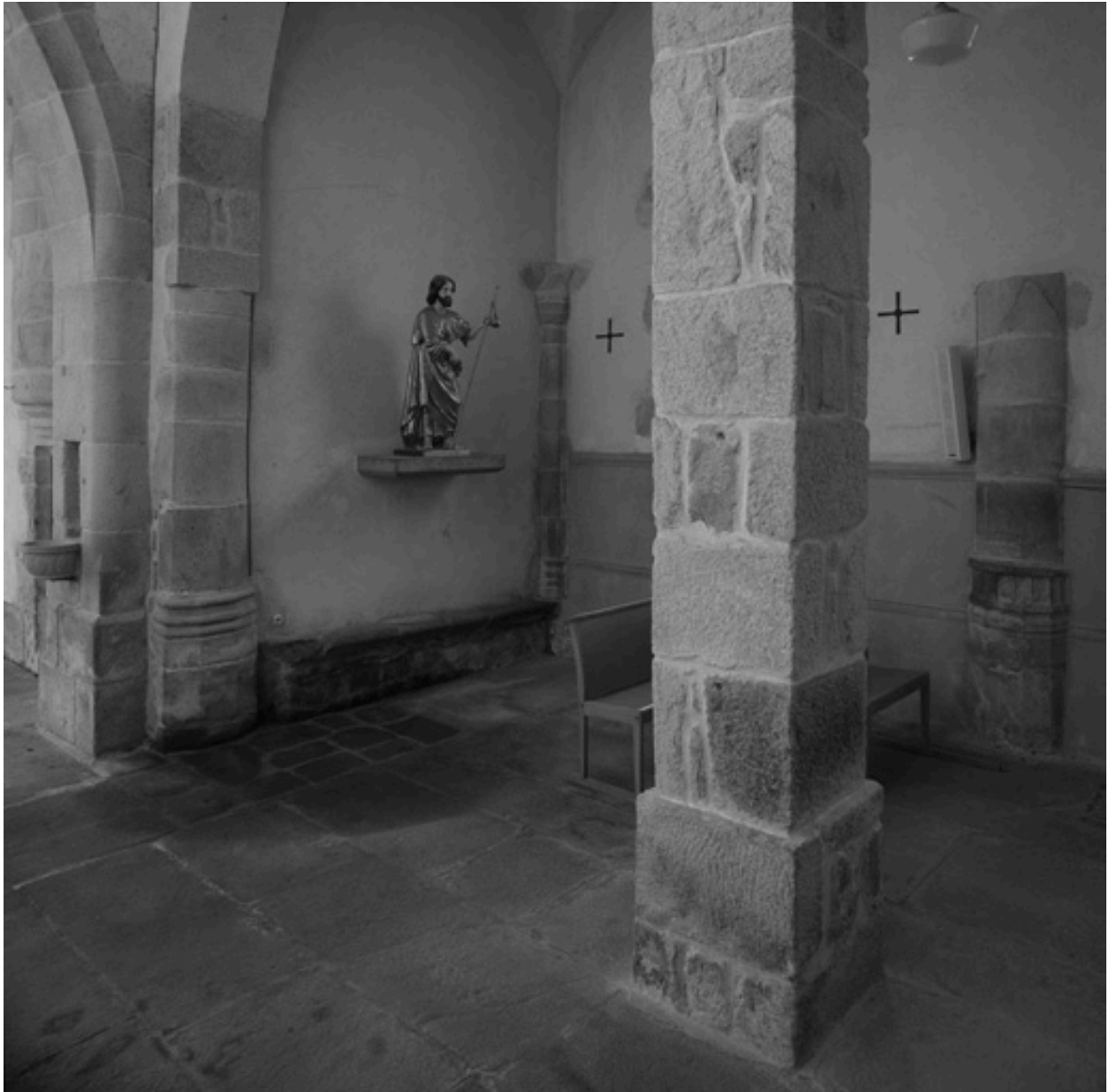
Vue rapprochée de la première travée du collatéral nord, depuis le sud-est : vestiges de l'ancienne église.
