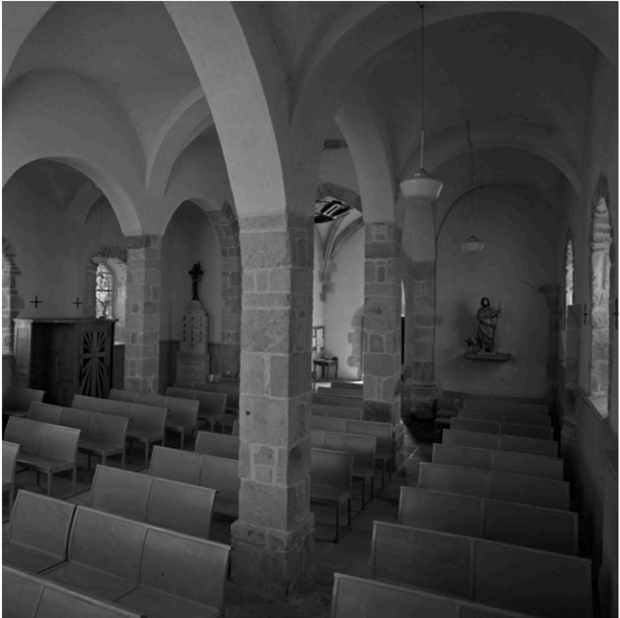
Vue d'ensemble intérieure de trois-quarts depuis le nord-est.
