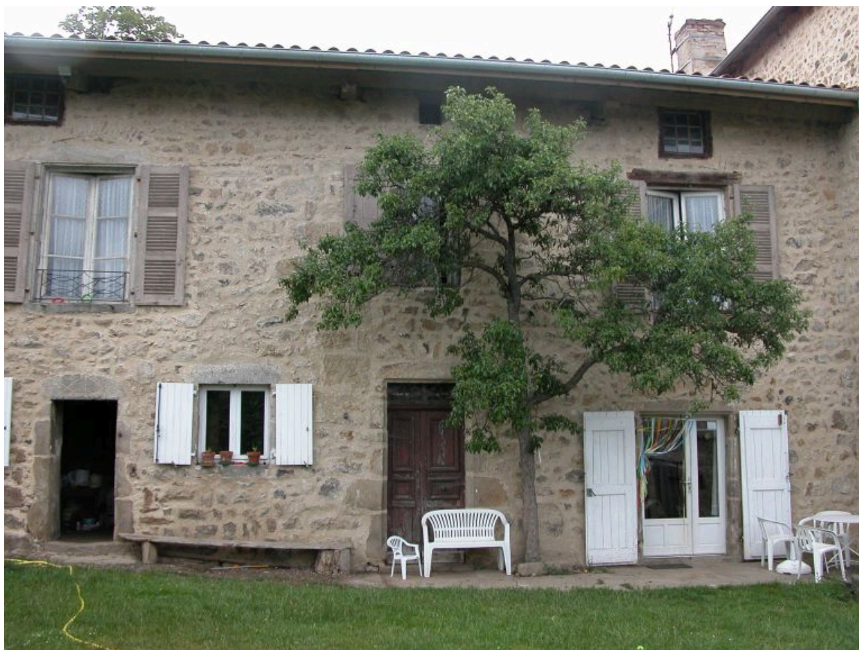
Vue d'ensemble de la partie droite du corps de bâtiment ouest de la ferme, logis.
