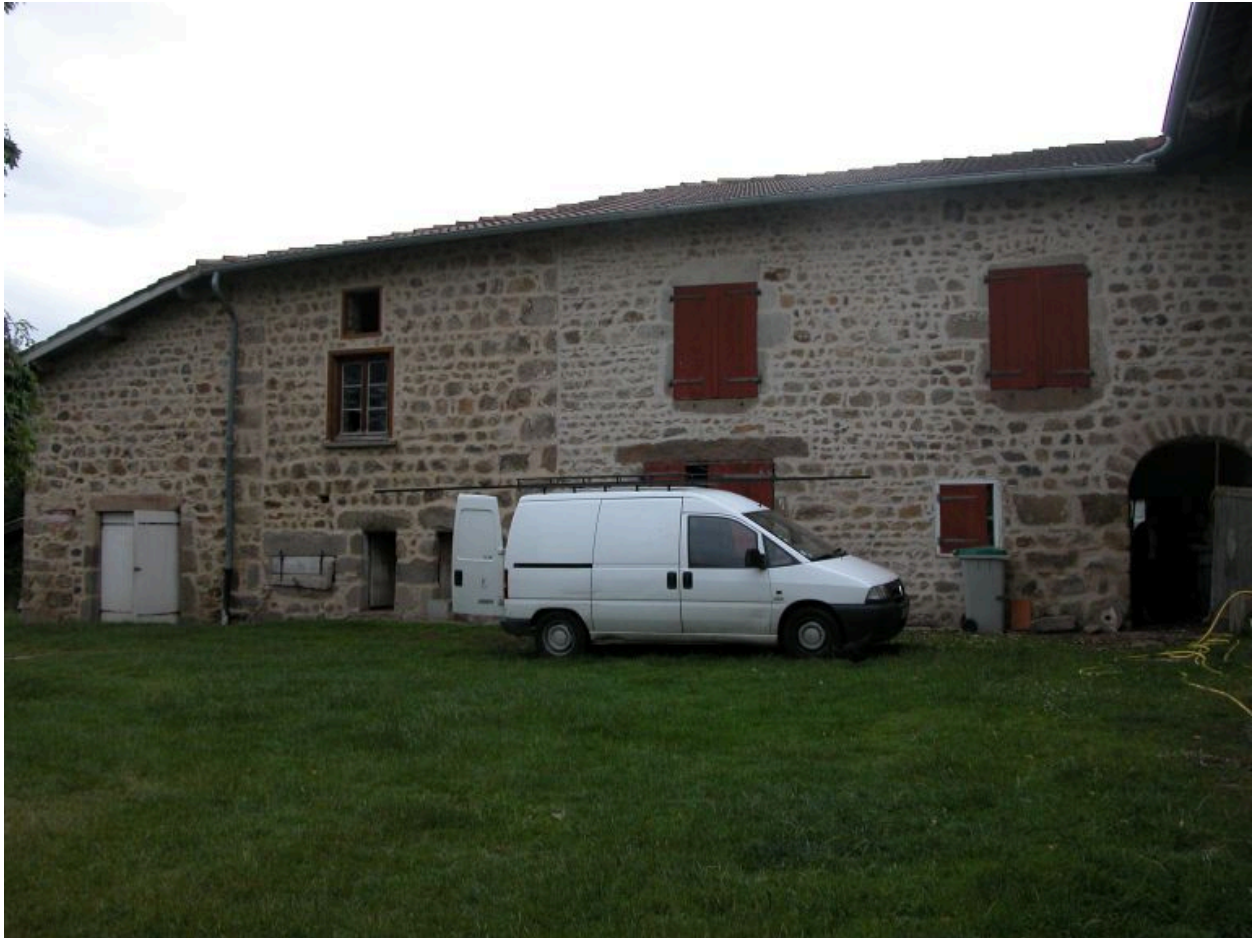
Vue d'ensemble du corps de bâtiment sud de la ferme.
