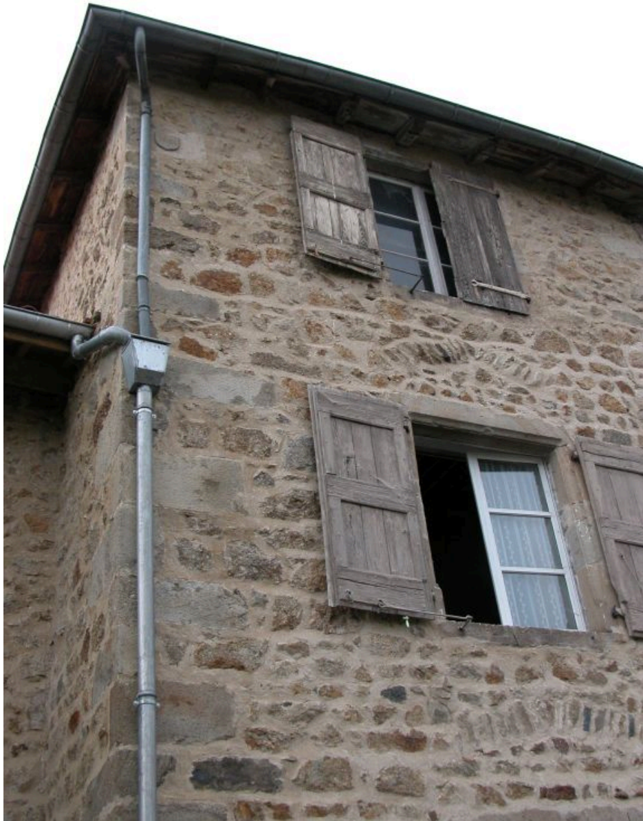
Détail de la partie haute de la tour avec chapelle.
