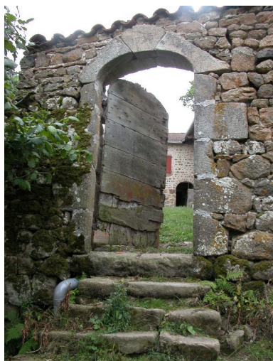
Vue d'ensemble du portail nord de la cour, depuis l'extérieur. Phot. Thierry Monnet IVR82_20124200511NUCA
