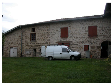
Vue d'ensemble du corps de bâtiment sud de la ferme. Phot. Thierry Monnet IVR82_20124200502NUCA
