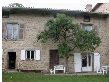
Vue d'ensemble de la partie droite du corps de bâtiment ouest de la ferme, logis. Phot. Thierry Monnet IVR82_20124200505NUCA
