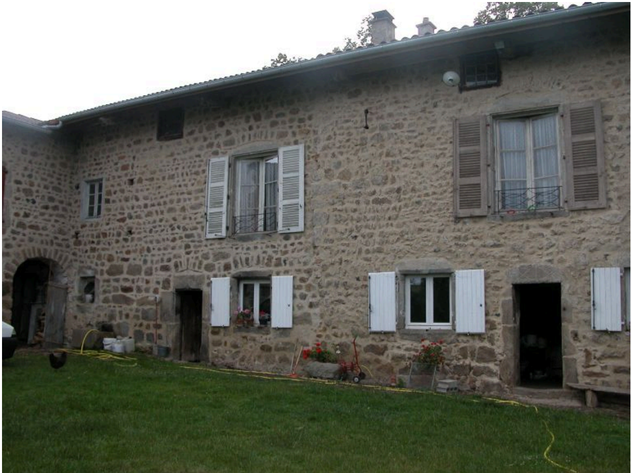
Vue d'ensemble de la partie gauche du corps de bâtiment ouest de la ferme.
