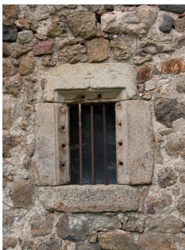
Détail d'une baie en remploi située sur la façade arrière du corps de bâtiment sud de la ferme. Phot. Thierry Monnet IVR82_20124200503NUCA
