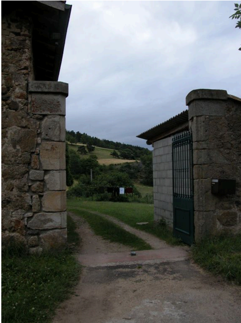
Vue d'ensemble du portail sud de la cour.
