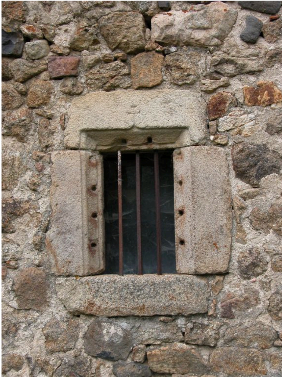
Détail d'une baie en remploi située sur la façade arrière du corps de bâtiment sud de la ferme.
