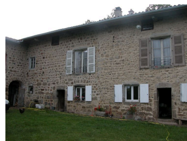
Vue d'ensemble de la partie gauche du corps de bâtiment ouest de la ferme. Phot. Thierry Monnet IVR82_20124200504NUCA
