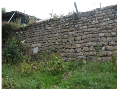
Vue partielle du mur de soutènement de la cour. Phot. Thierry Monnet IVR82_20124200512NUCA
