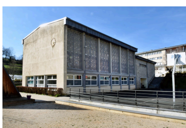
Le gymnase, depuis le sud Phot. Catherine Guégan IVR84_20241500053NUCA
