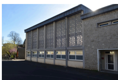
Le gymnase, depuis le nord Phot. Catherine Guégan IVR84_20241500052NUCA
