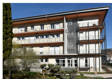
Bâtiment de l'administration, depuis l'ouest Phot. Catherine Guégan IVR84_20241500056NUCA
