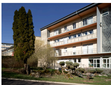
Bâtiment de l'administration, depuis le sud-ouest Phot. Christian Parisey IVR84_20241500108NUCA
