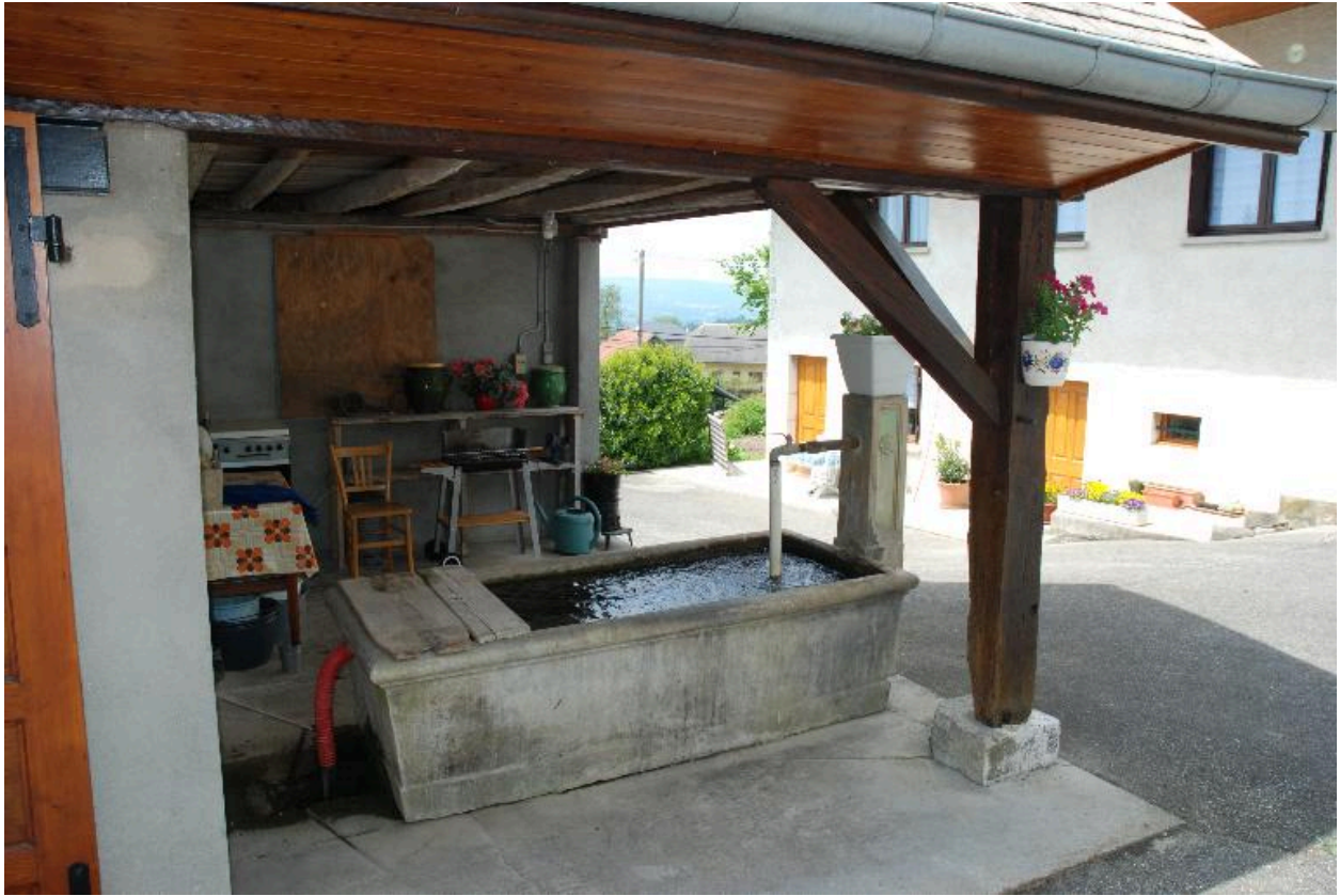
Vue de la fontaine-abreuvoir.
