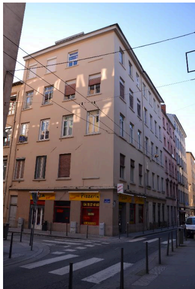
Vue d'ensemble Phot. Noémie Caillat IVR82_20156900205NUCA
