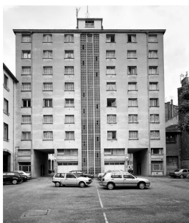
Bâtiment moderne construit au milieu de la cour : élévation nord Phot. Jean-Marie Refflé IVR82_20016901093P
