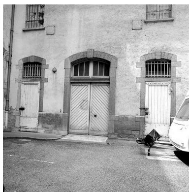
Dépendances situées à l'ouest : détail des portes Phot. Jean-Marie Refflé IVR82_20016901087X
