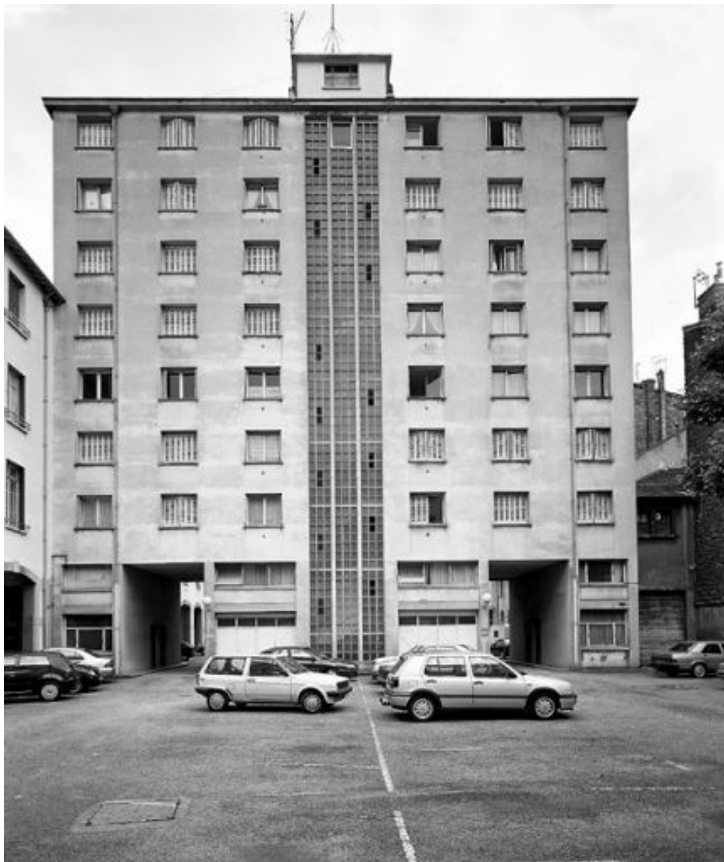
Bâtiment moderne construit au milieu de la cour : élévation nord
