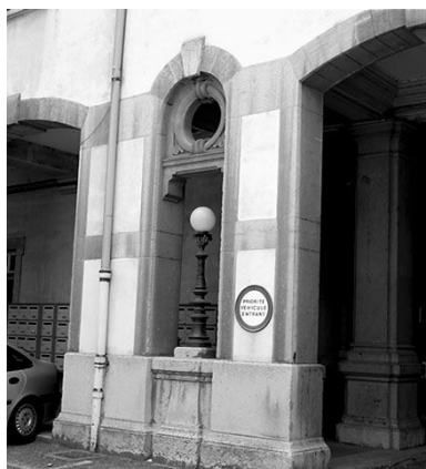
Passage d'entrée : détail d'une niche et de son lampadaire Phot. Jean-Marie Refflé IVR82_20016901084X
