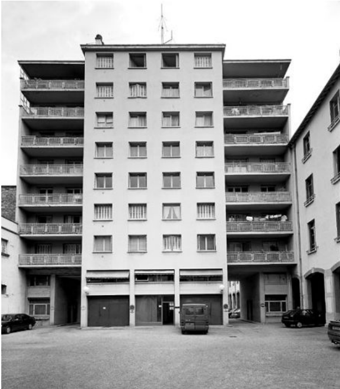
Bâtiment moderne construit au milieu de la cour : élévation antérieure, sud
