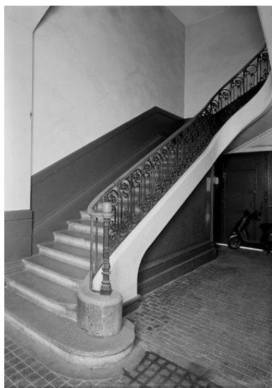
Départ et première volée de l'escalier accessible depuis le portique ou depuis la rue Smith Phot. Jean-Marie Refflé IVR82_20016901090P
