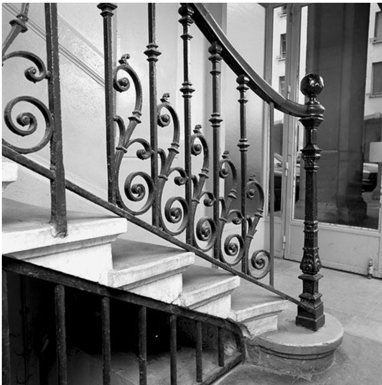
Départ d'escalier et vue partielle de la descente de cave, situés à l'angle des ailes sud et ouest
