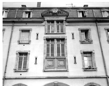
Travées centrales de l'élévation est, rue Smith Phot. Jean-Marie Refflé IVR82_20016901077P
