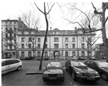
Élévation antérieure, cours Suchet Phot. Eric Dessert IVR82_20026900324V
