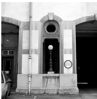
Passage d'entrée : détail d'une niche et de son lampadaire, vue de face Phot. Jean-Marie Refflé IVR82_20016901085X
