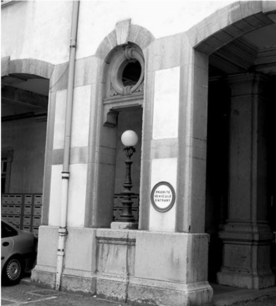
Passage d'entrée : détail d'une niche et de son lampadaire
