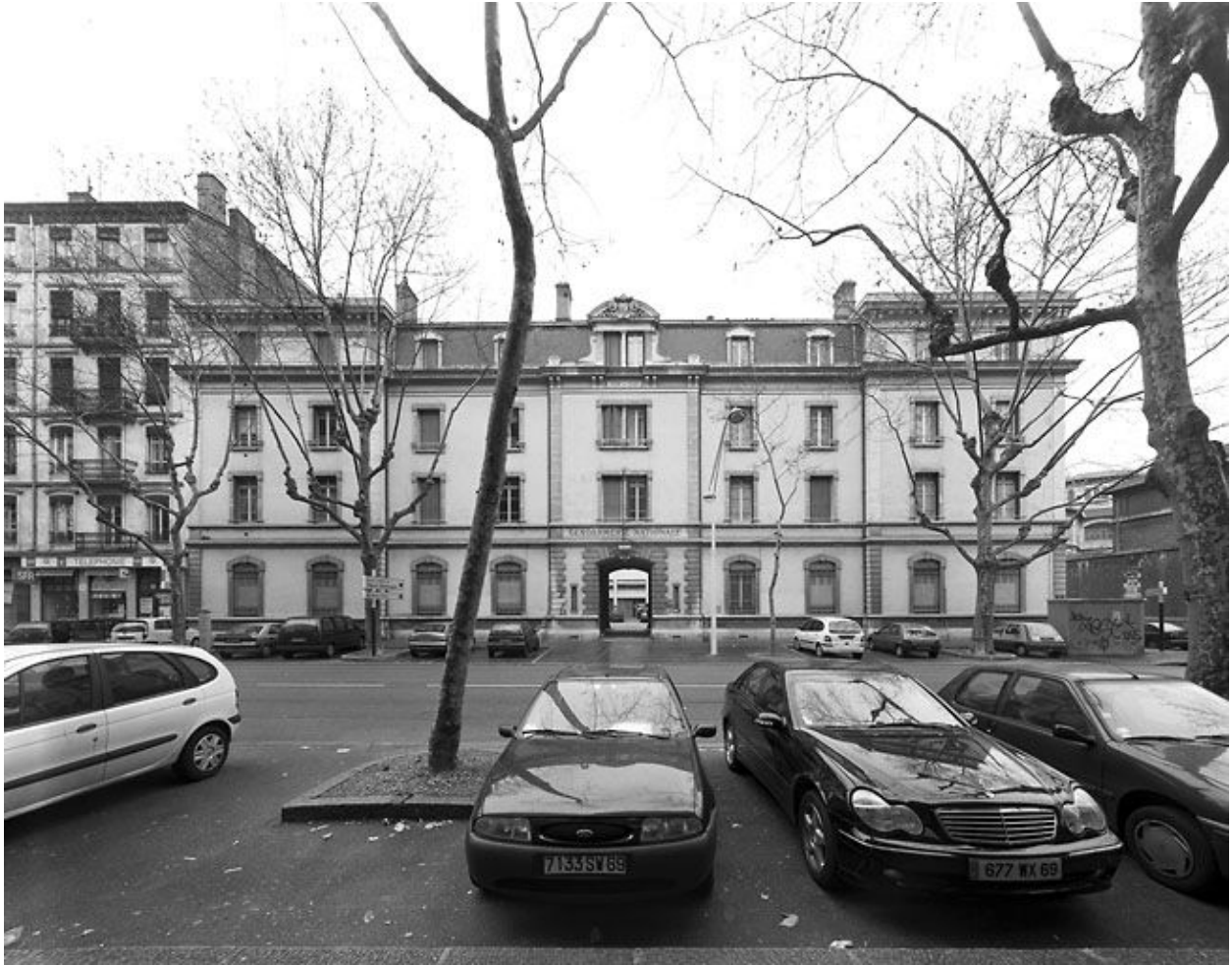
Elévation antérieure, cours Suchet
