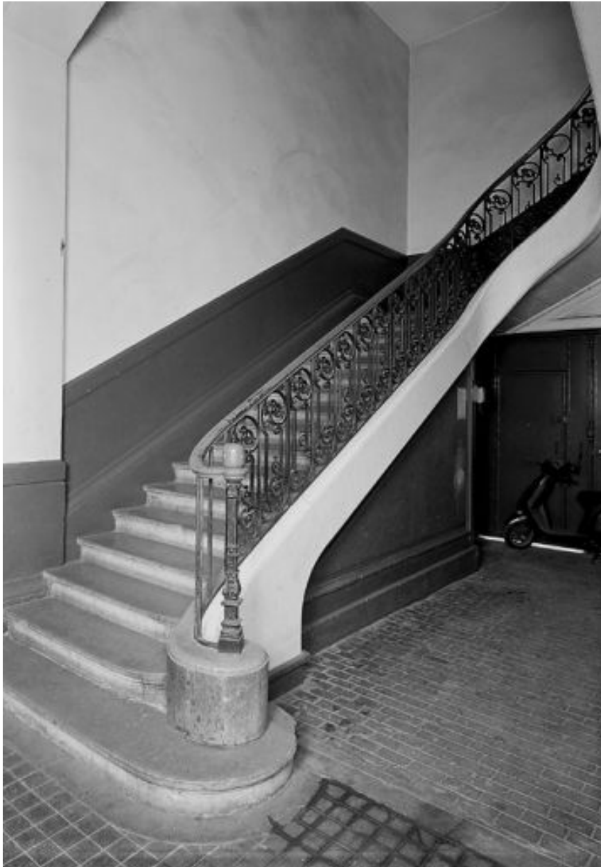
Départ et première volée de l'escalier accessible depuis le portique ou depuis la rue Smith
