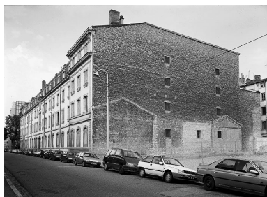
Élévation rue Smith et murepignon côté rue Dugas-Montbel Phot. Jean-Marie Refflé IVR82_20016901075P
