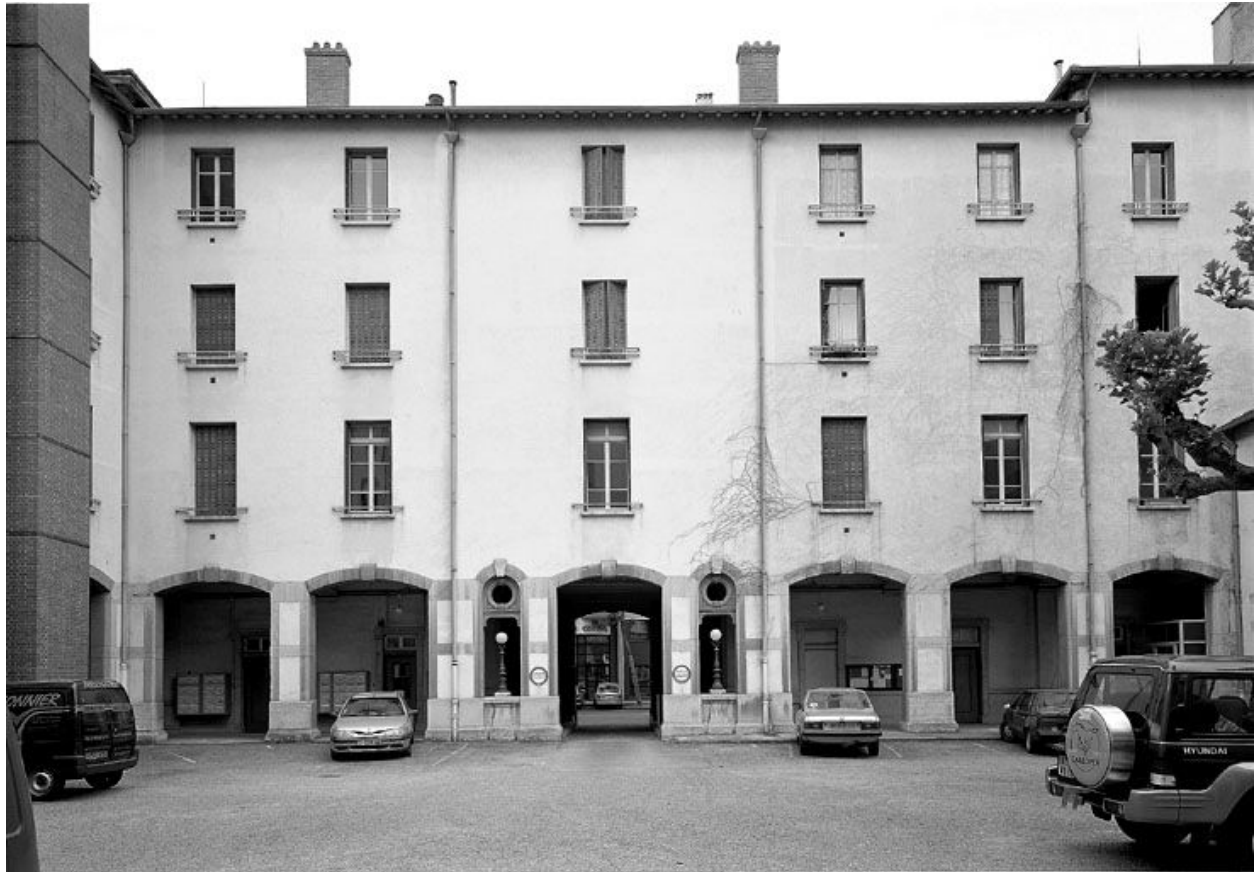
Elévation postérieure de l'aile centrale située sur le cours Suchet
