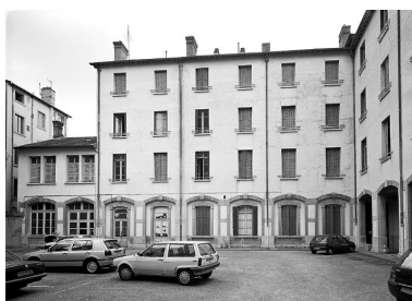
Bâtiments ouvrant sur le côté nord de la cour. A gauche, la buanderie et le séchoir occupés aujourd'hui par l'atelier menuiserie Phot. Jean-Marie Refflé IVR82_20016901088P
