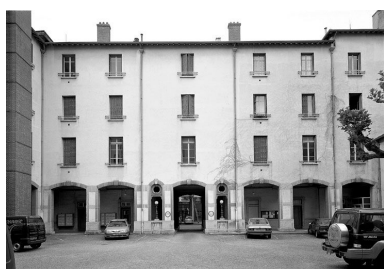
Elévation postérieure de l'aile centrale située sur le cours Suchet Phot. Jean-Marie Refflé IVR82_20016901081P
