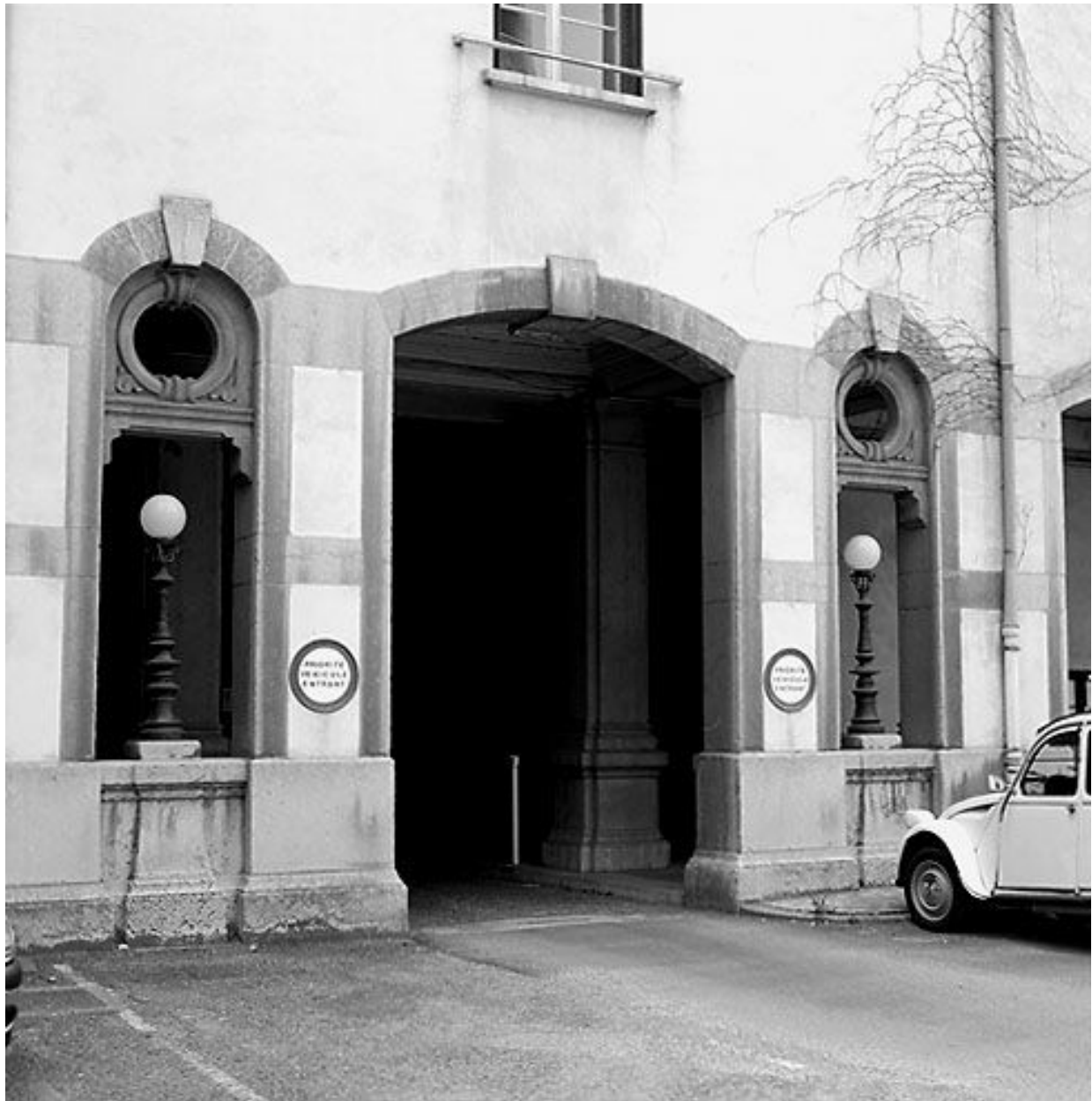
Le passage d'entrée vu depuis la cour
