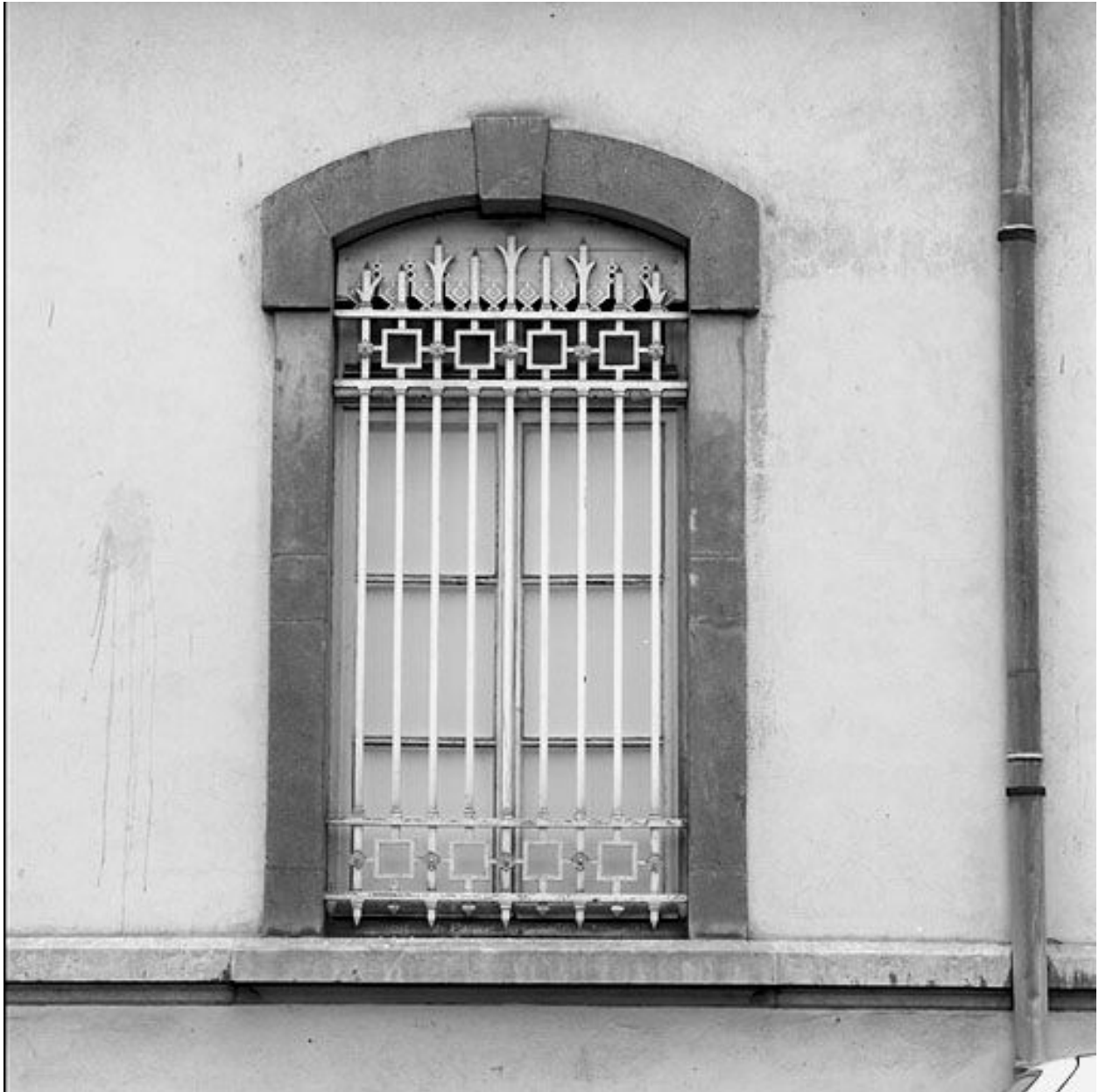
Détail d'une fenêtre protégée de barreaux, rue Smith
