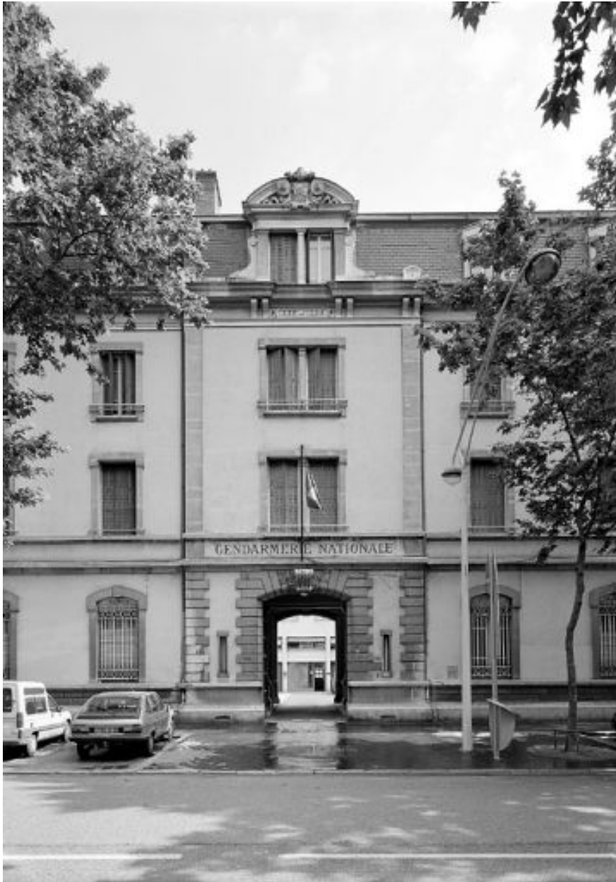
Travée centrale de l'élévation antérieure, cours Suchet
