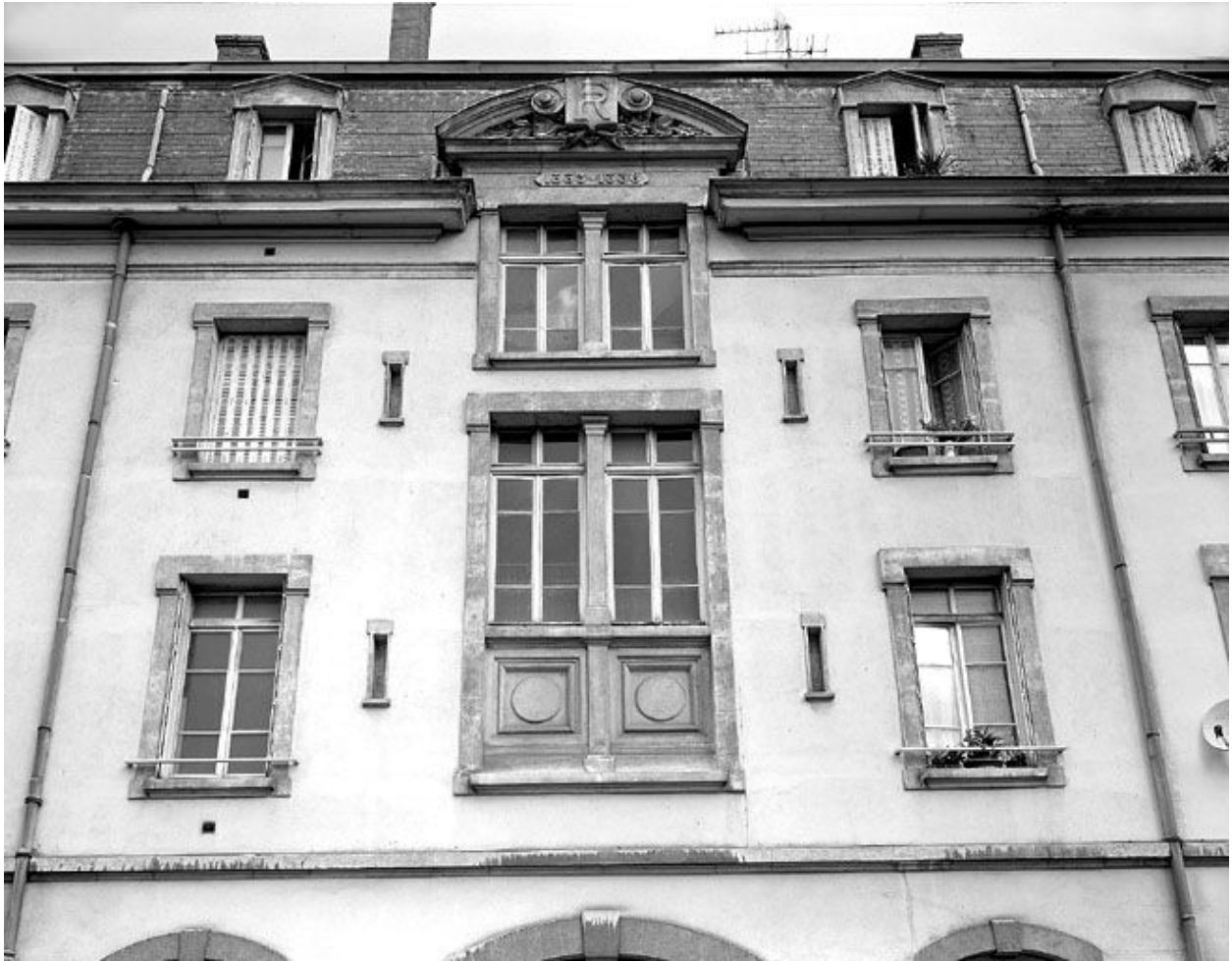
Travées centrales de l'élévation est, rue Smith
