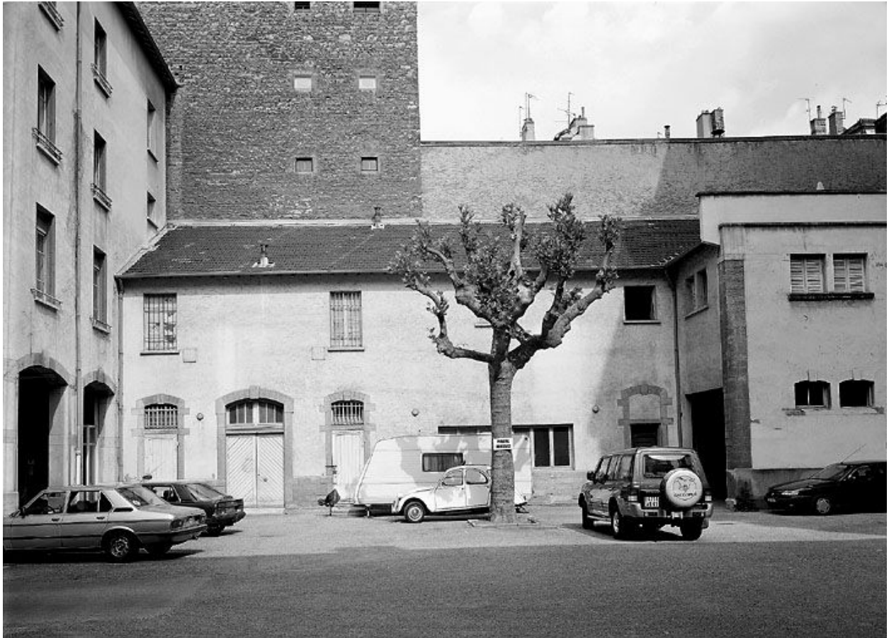
Dépendances, anciennement violons, resserres, et peut-être fenil et sellerie, côté ouest de la cour
