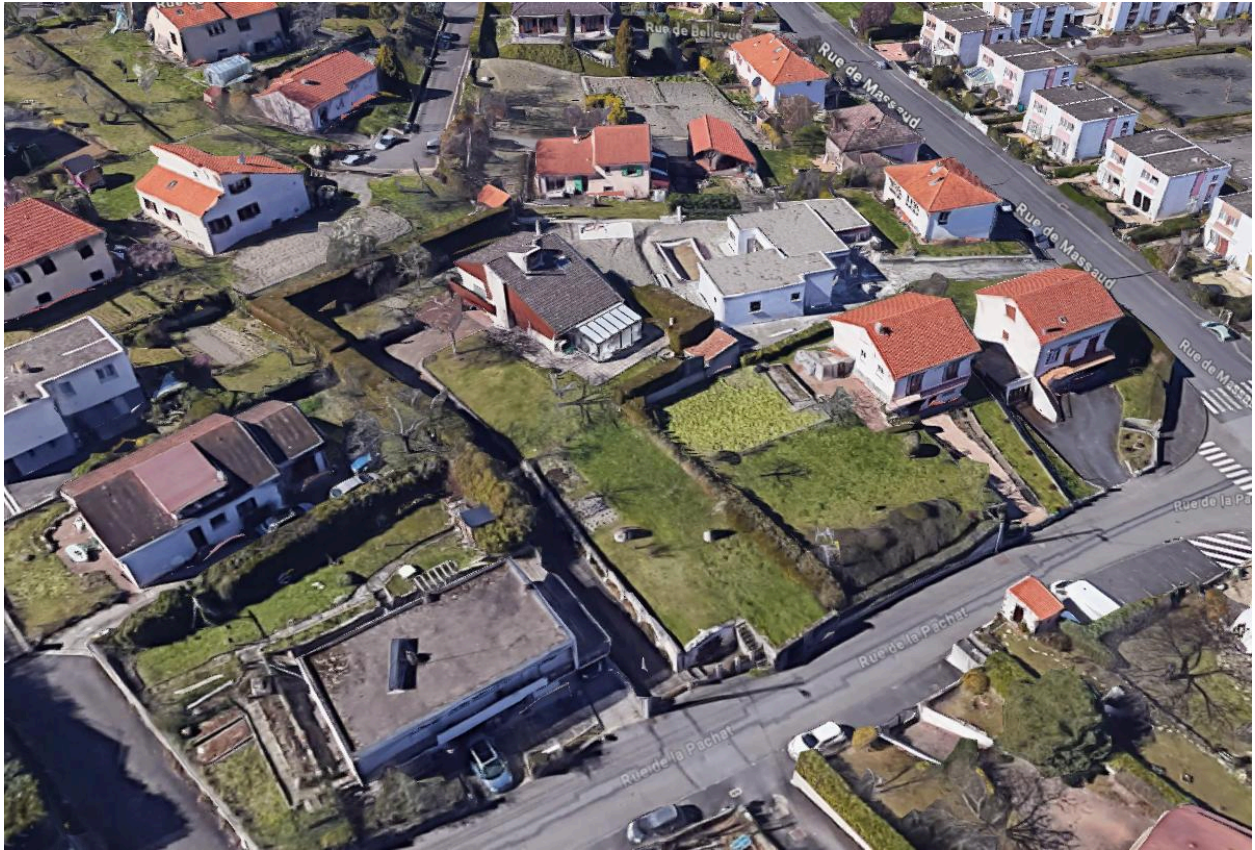
Cébazat, la maison L., vue aérienne depuis le sud-est.
