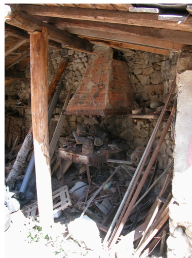
Vue intérieure de la forge. Phot. Thierry Monnet IVR82_20124201063NUCA
