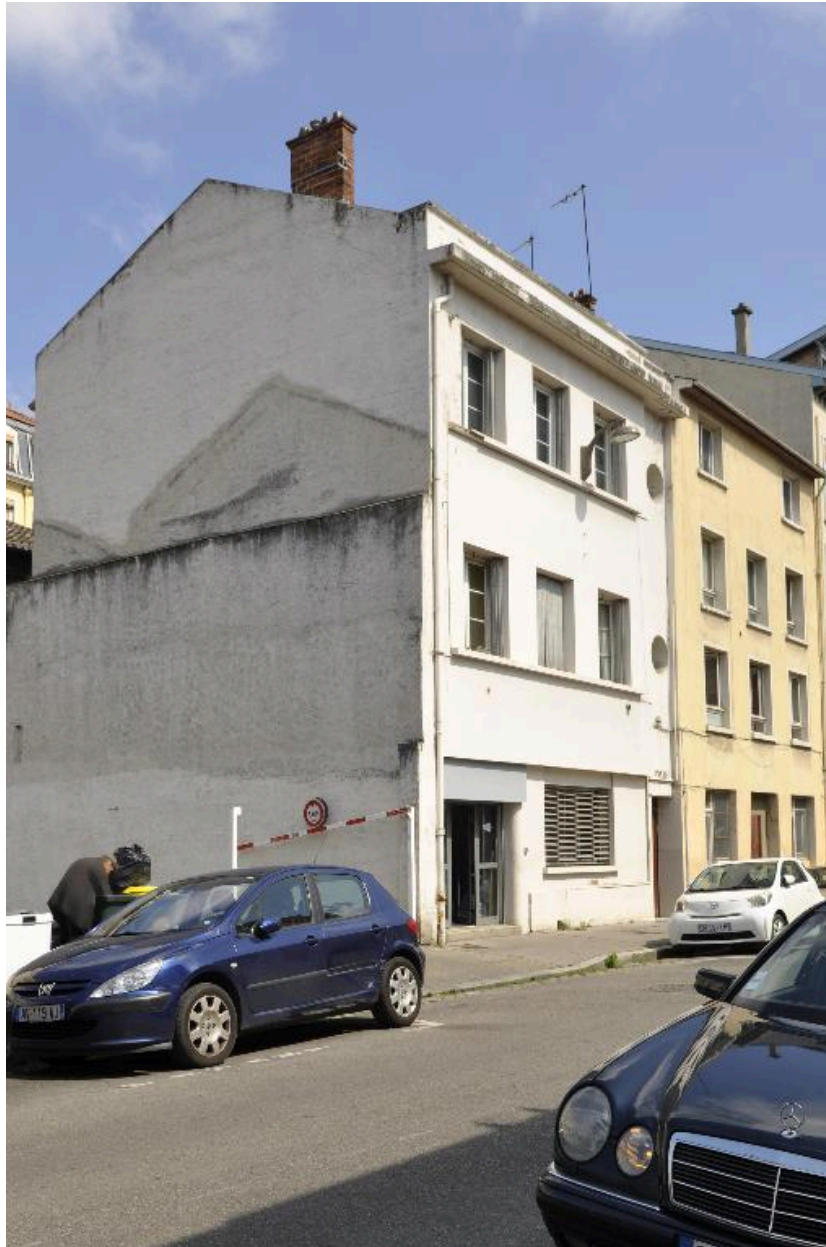
Vue d'ensemble des deux immeubles reliés par l'escalier commun
