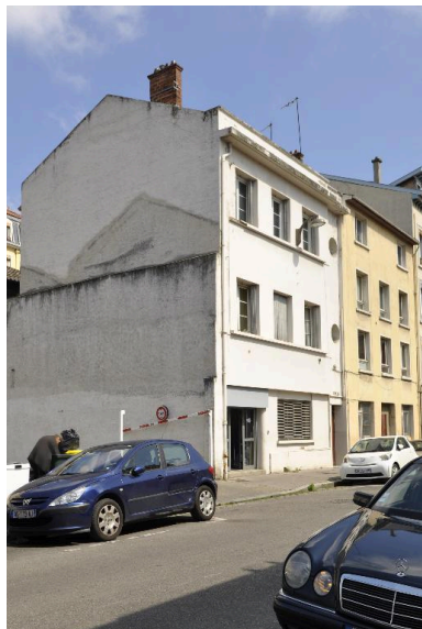
Vue d'ensemble des deux immeubles reliés par l'escalier commun Phot. Catherine Guégan IVR84_20166900698NUCA
