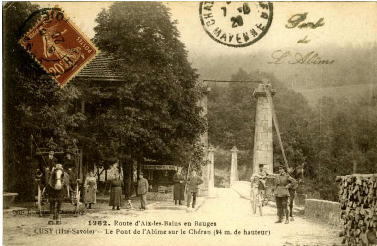
1262. Route d'Aix-les-Bains en Bauges / CUSY (Hte-Savoie) – Le Pont de l'Abîme sur le Chéran (94 m. de hauteur) [tampon 1920]
