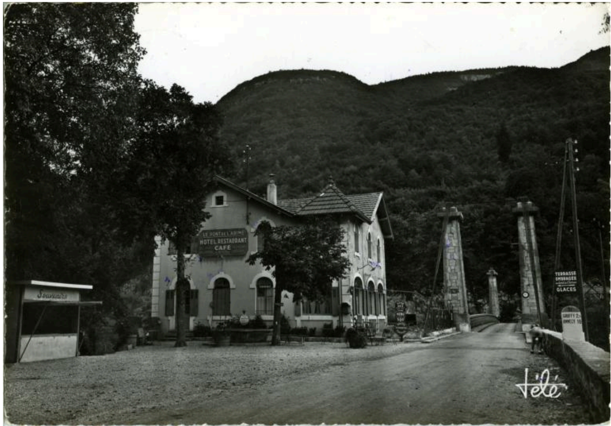
180 – Le Pont de l'Abîme à Cusy / Hôtel-Restaurant Demeure [tampon 1958]
