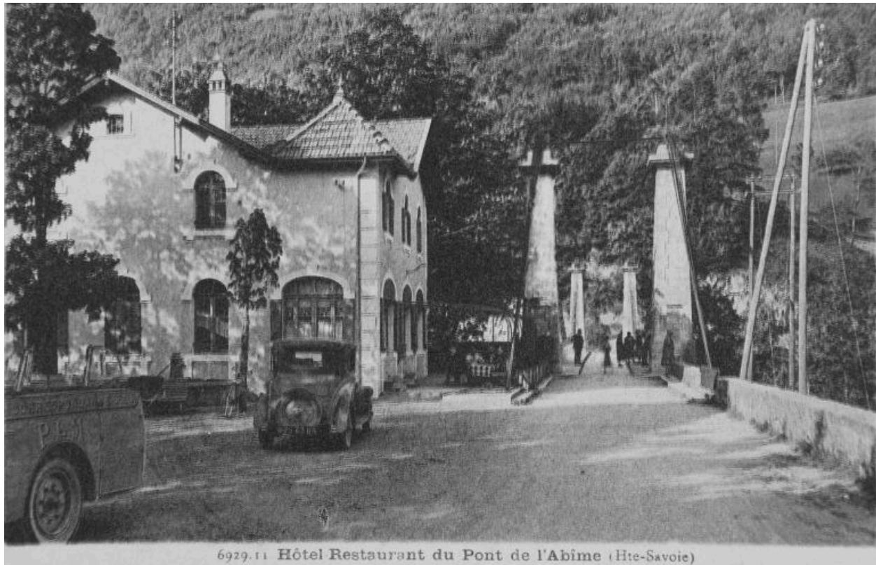
6929. 11 – Hôtel Restaurant du Pont de l'Abîme (Hte-Savoie) [milieu 20e siècle]
