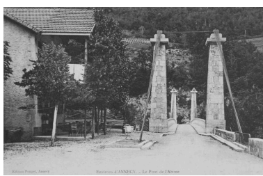
Environs d'ANNECY. – Le Pont de l'Abîme [1913] Phot. Eric (reproduction) Dessert IVR84_20167400905NUCB
