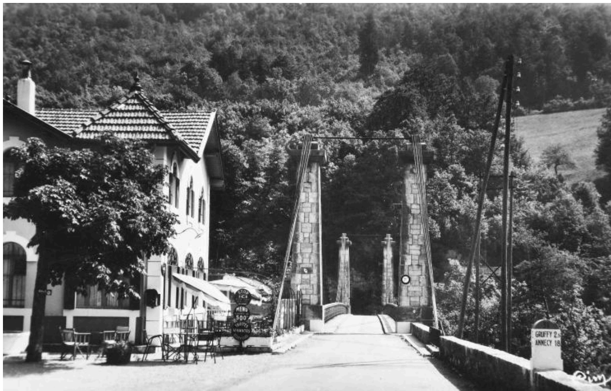
1 – Le Pont de l'Abîme (haut. 95 m.) [1962]
