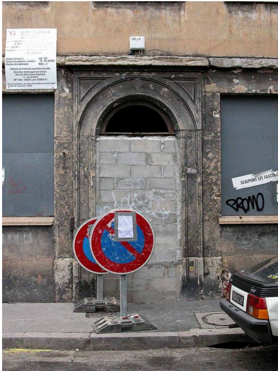
Détail de la porte d'entrée
