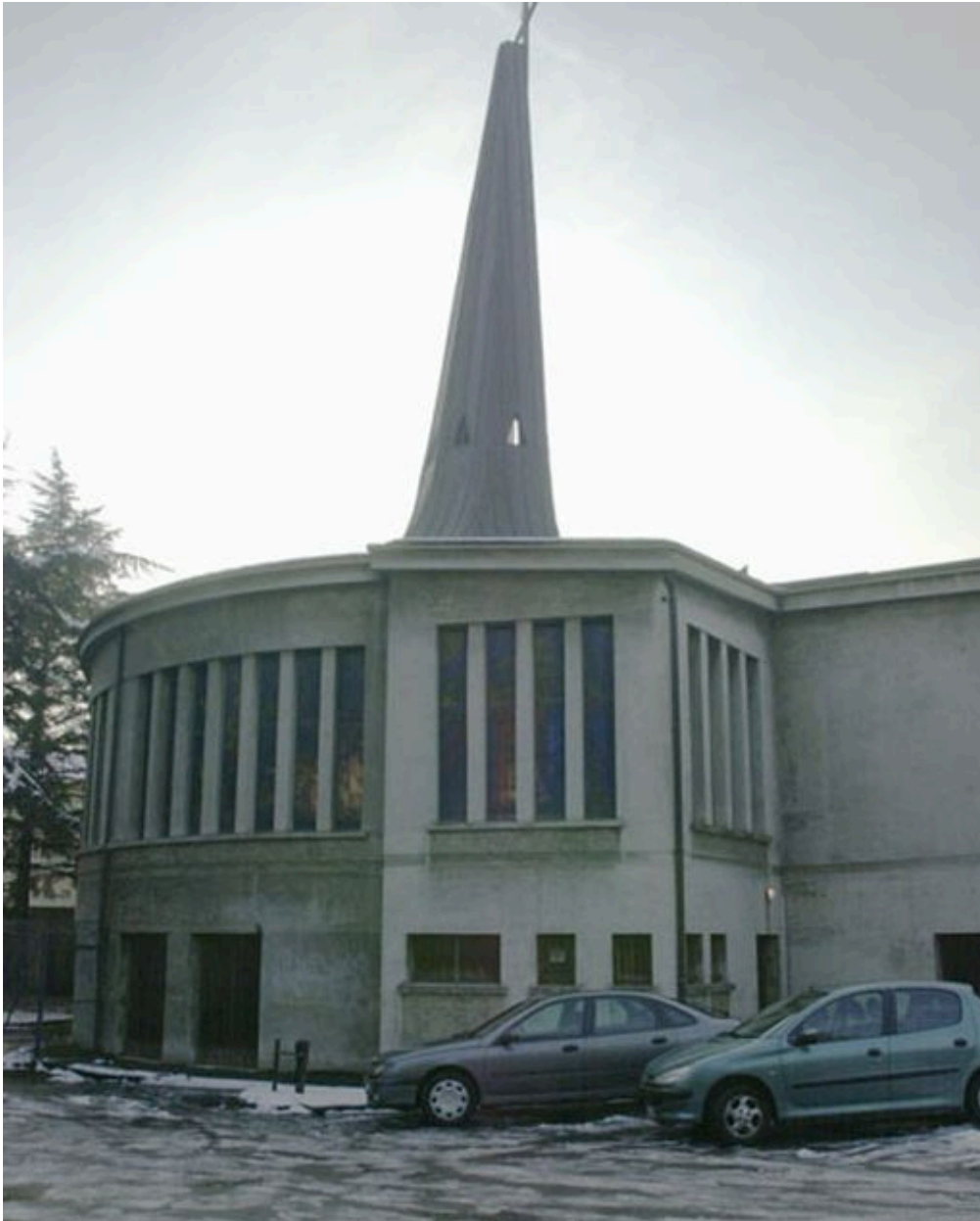
Vue générale du chevet depuis le nord
