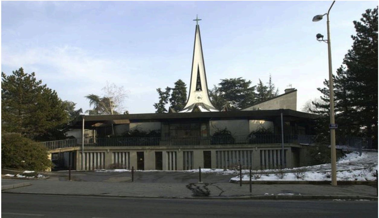
Vue générale rapprochée depuis l'ouest
