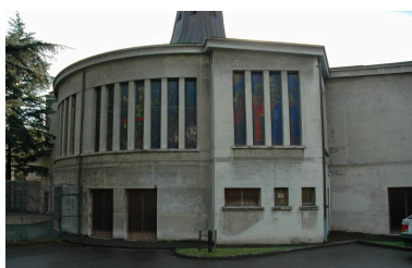
Vue du chevet depuis le nord-est Phot. Maryannick Chalabi IVR82_20066900730NUCA
