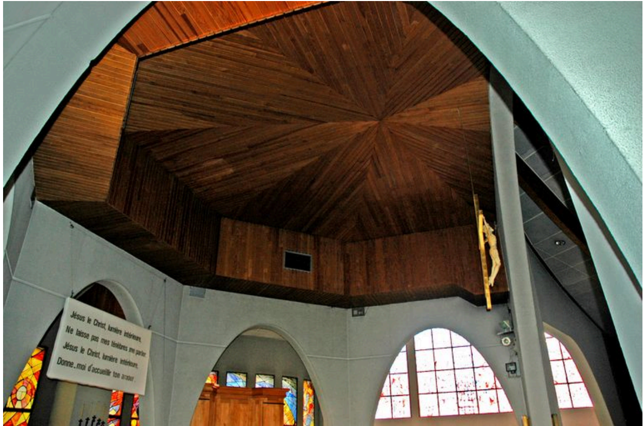
Le couvrement du chœur depuis le nord
