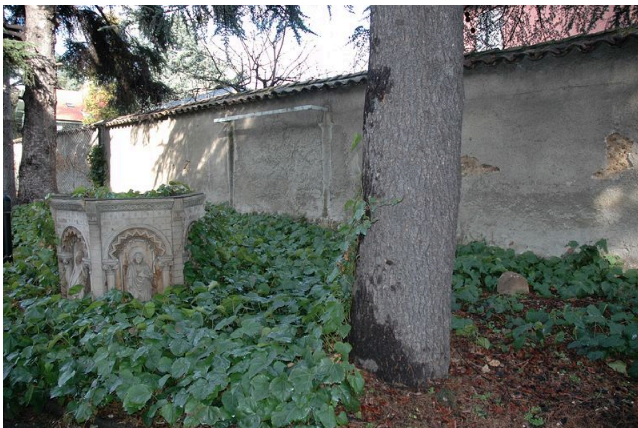
Mur de clôture du jardin du presbytère et vue des anciens fonts baptismaux
