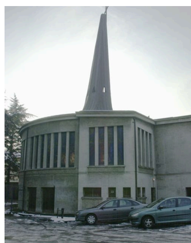
Vue générale du chevet depuis le nord Phot. Maryannick Chalabi IVR82_20066900610NUCA
