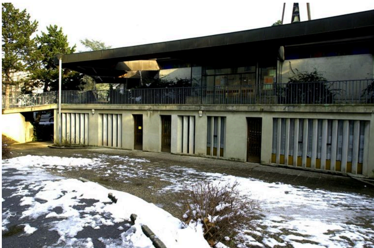
Le parvis et l'entrée des salles en rez-de-chaussée
