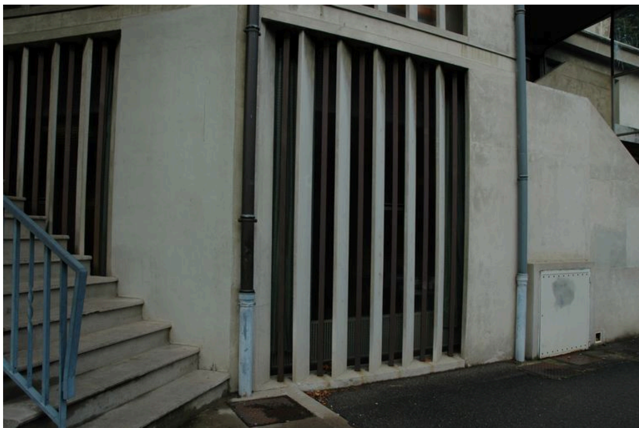
Détail des baies à claire voie de l'accueil et départ de l'escalier ouest de la coursière
