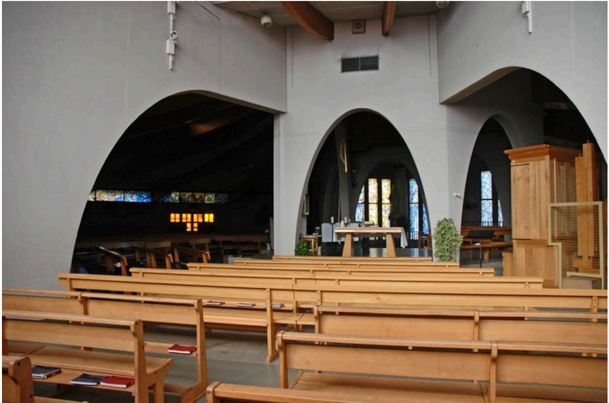
Vue du chœur depuis la chapelle
