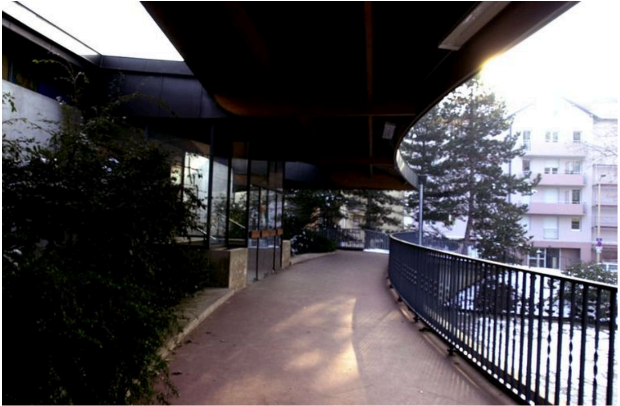
Vue de la coursière d'accès à l'église, depuis le nord
