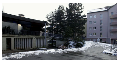
Vue du parvis et de la rampe d'accès à l'église depuis la rue Champvert depuis le nord-ouest Phot. Maryannick Chalabi IVR82_20066900606NUCA
