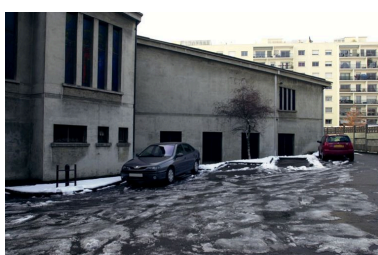
Elévation de la partie nord-est Phot. Maryannick Chalabi IVR82_20066900612NUCA
