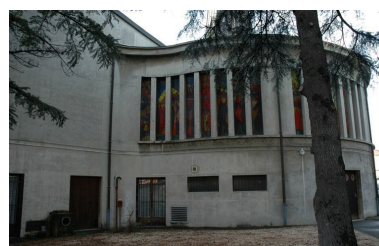
Vue générale du chevet de l'église depuis le jardin du presbytère Phot. Maryannick Chalabi IVR82_20066900728NUCA
