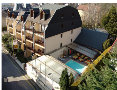
Vue prise de l'est Phot. François Fouger IVR82_20097300471NUCA
