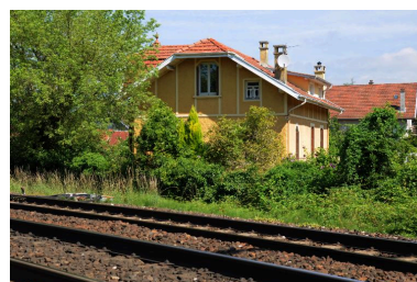
Façades latérale et postérieure Phot. Denys Harreau IVR82_20147301023NUCA
