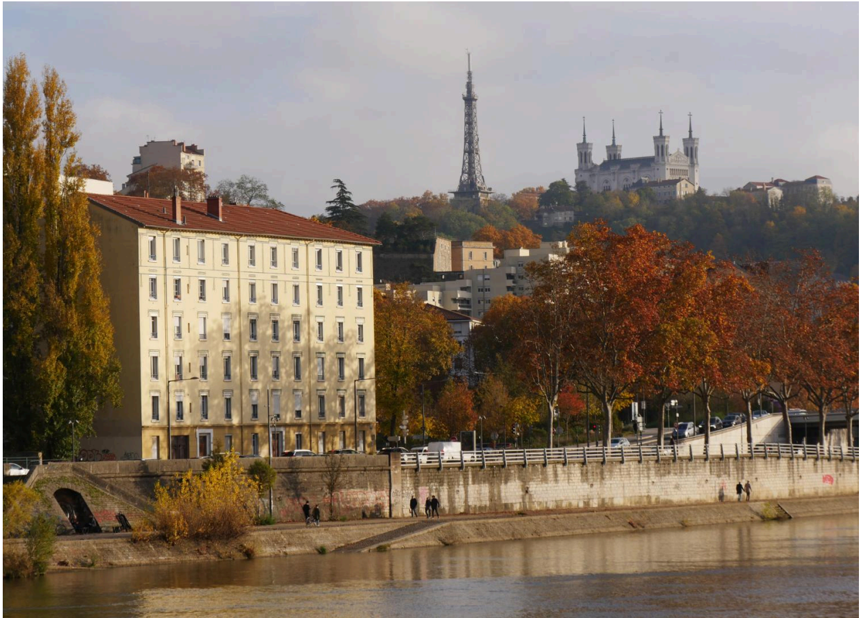
Vue d'ensemble nord-ouest
