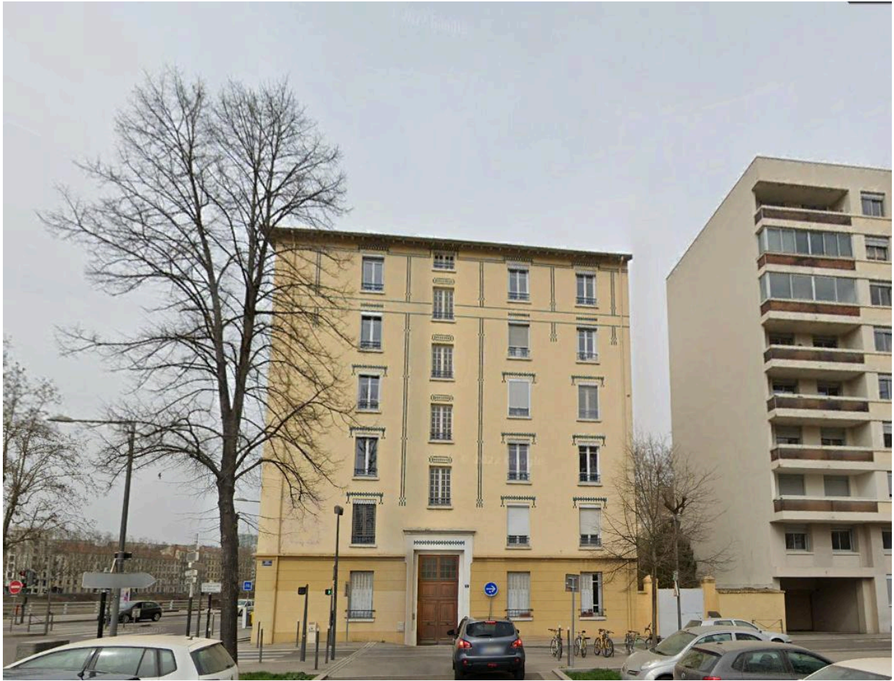
Vue façade sud rue des Entrepôts
