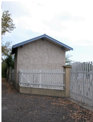
Vue générale Phot. Thierry Monnet IVR82_20134200261NUCA
