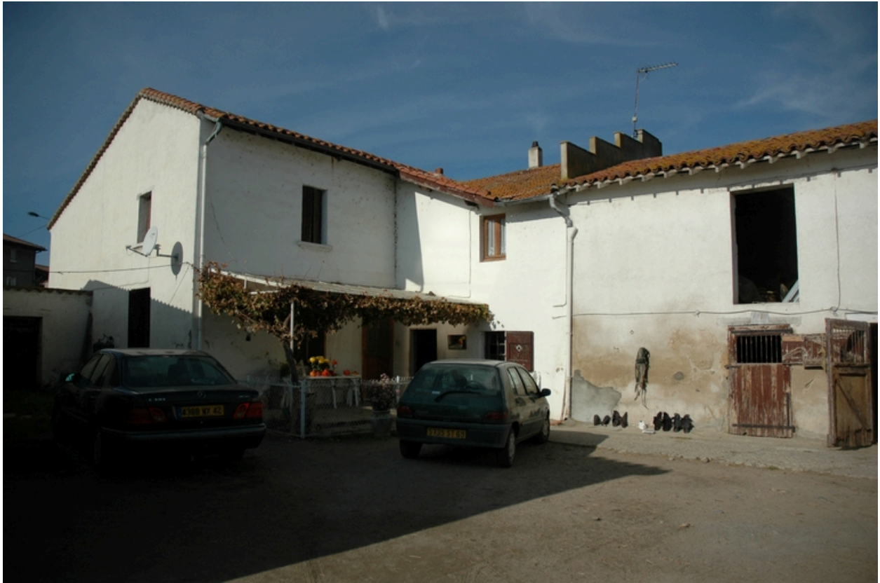
Vue de l'habitation nord-ouest depuis la cour.
