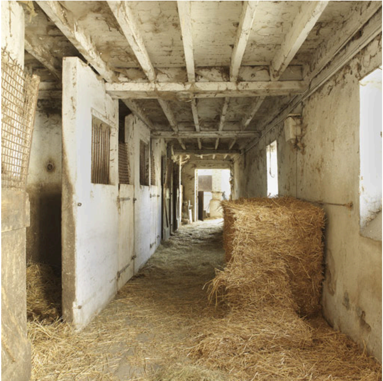
Vue intérieure de l'étable à chevaux nord.
