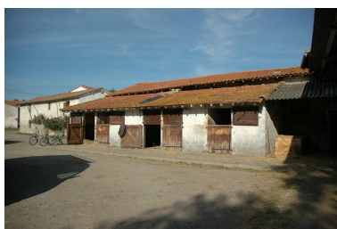
Vue de l'extension du bâtiment sud-est, depuis le sud. Phot. Thierry Monnet IVR82_20134204329NUCA
