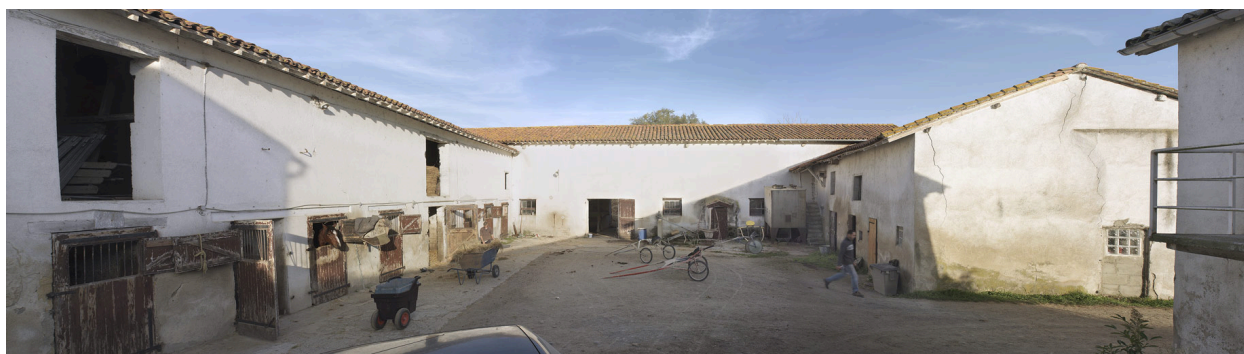
Vue générale de la cour depuis l'ouest.
