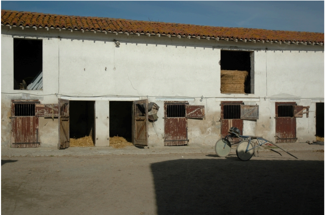
Vue de l'étable nord, depuis la cour.
