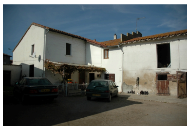
Vue de l'habitation nord-ouest depuis la cour. Phot. Thierry Monnet IVR82_20134204333NUCA
