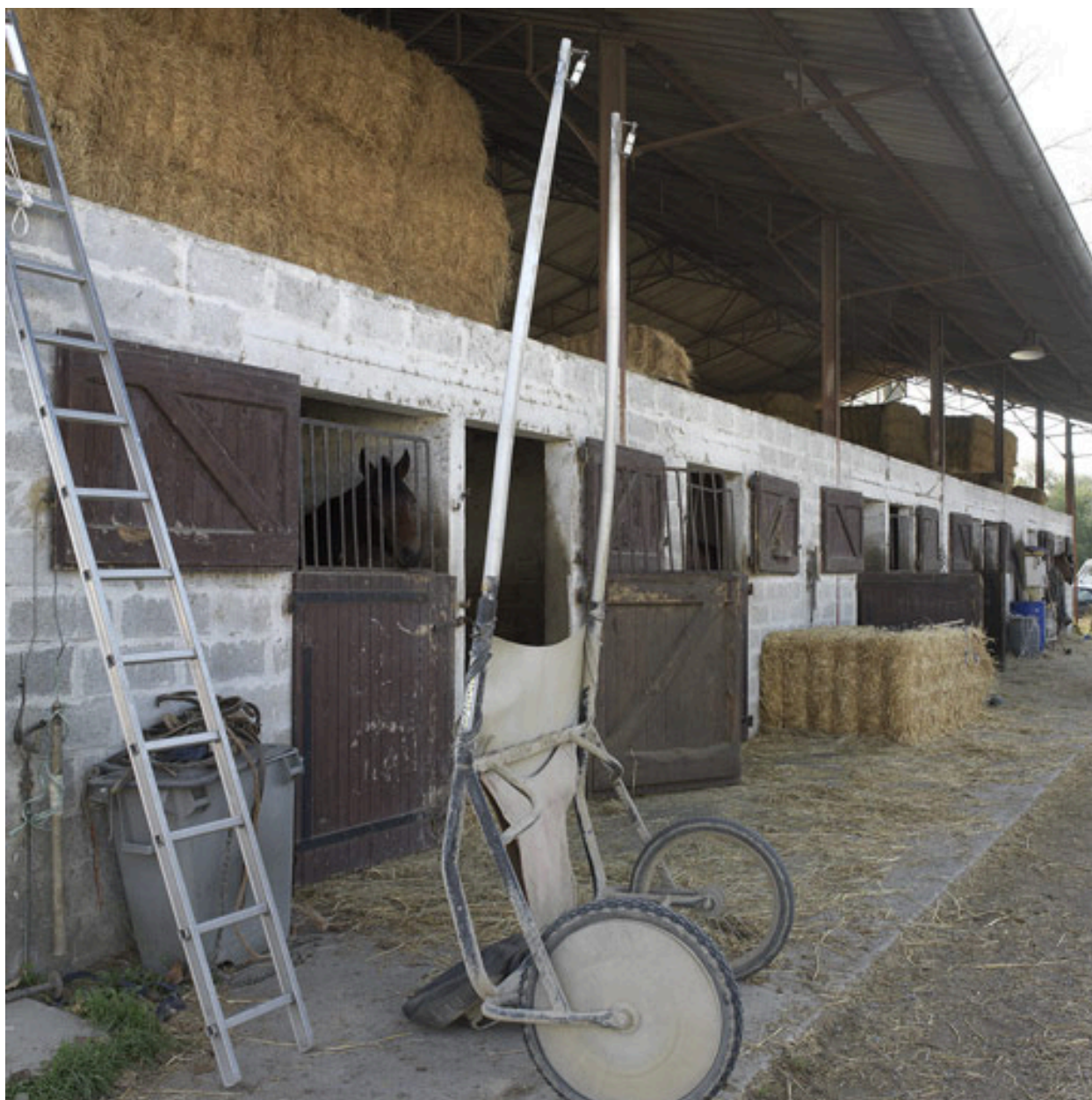
Vue de l'étable à chevaux édiflée au sud.
