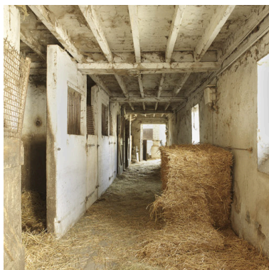
Vue intérieure de l'étable à chevaux nord. Phot. Didier Gourbin IVR82_20064202433NUCA
