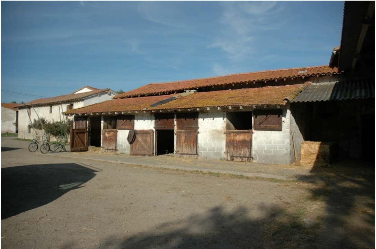
Vue de l'extension du bâtiment sud-est, depuis le sud.
