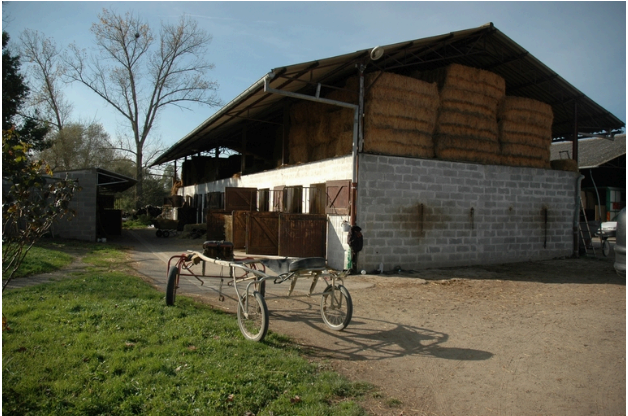
Vue de l'étable à chevaux édiflée au sud.
