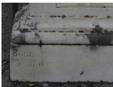
Quelques tombes portent la signature du marbrier lyonnais Bouchaudy Phot. Véronique Belle IVR84_20216900451NUCA
