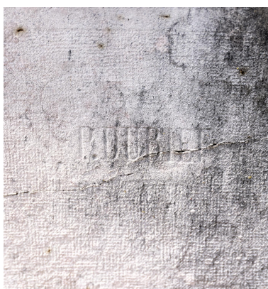
De nombreux tombeaux portent la signature du marbrier-sculpteur Pétrus Dubief Phot. Franck Trabouillet IVR84_20226900780NUCA
