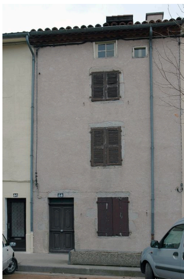
Élévation sur le boulevard, vue générale. Phot. Simone Hartmann-Nussbaum IVR82_20114201232NUCA
