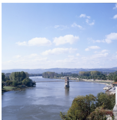
Vue prise depuis l'aval de la Saône Phot. Jean-Marie Refflé IVR82_19900100337XA
