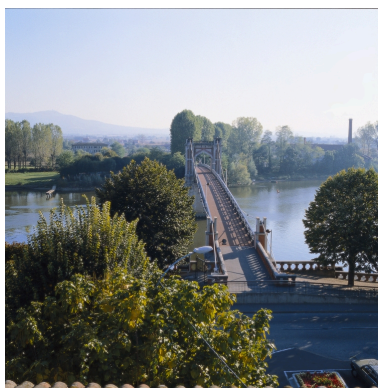
Vue axiale, depuis la rive gauche Phot. Jean-Marie Refflé IVR82_19900100334XA
