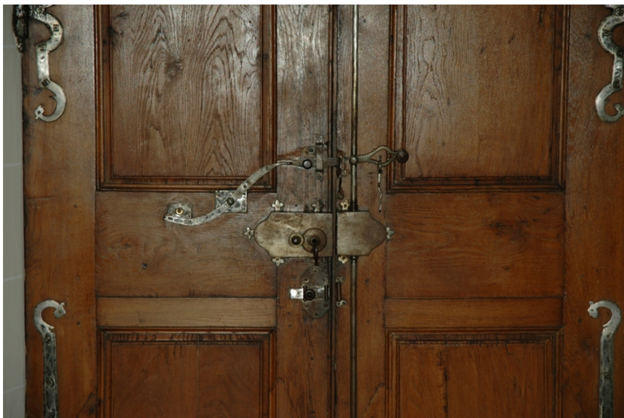
Détail des vantaux de la porte, côté intérieur : système de fermeture.
