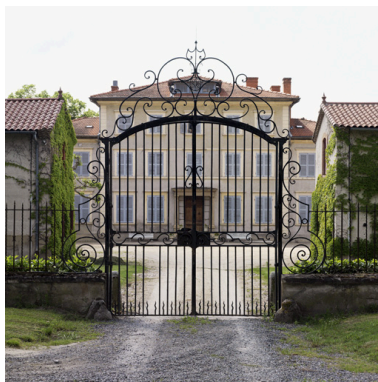
Vue du portail de la cour. Phot. Didier Gourbin IVR82_20074201203NUCA
