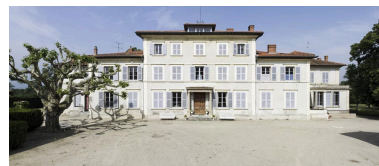
Vue d'ensemble de la façade sur cour, depuis l'est. Phot. Didier Gourbin IVR82_20074201214NUCAQ
