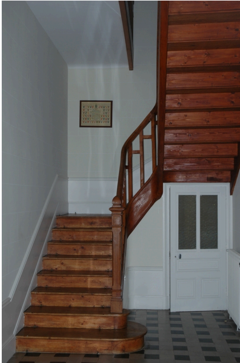
Vue intérieure de l'escalier de l'un des pavillons du second agrandissement.
