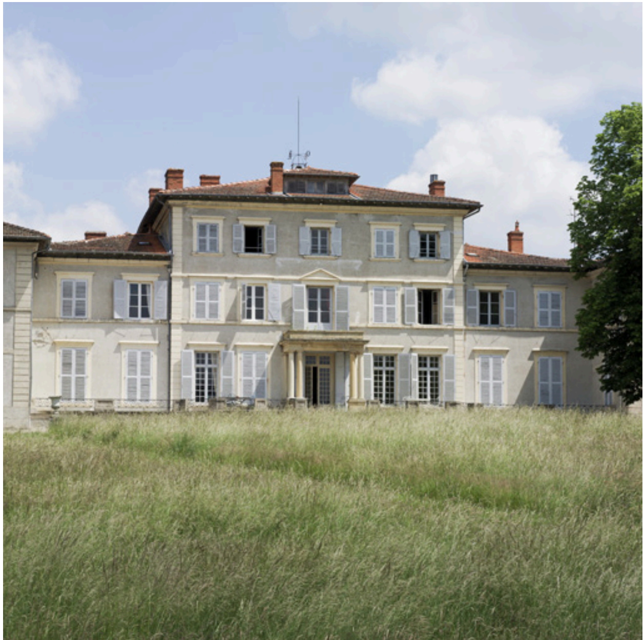
Vue de la façade sur jardin, depuis l'ouest.
