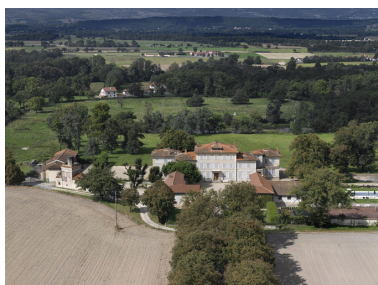
Vue aérienne, depuis le sud-est. Phot. Didier Gourbin IVR82_20074200737NUCA
