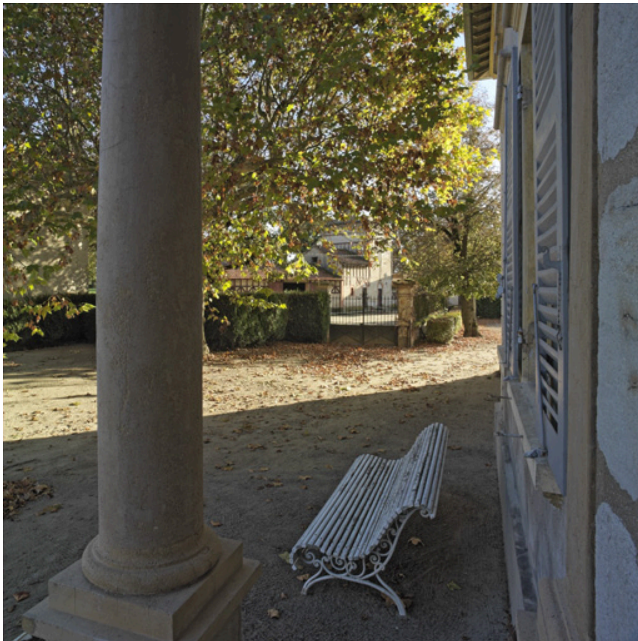
Détail du portique d'entrée de la façade sur cour.
