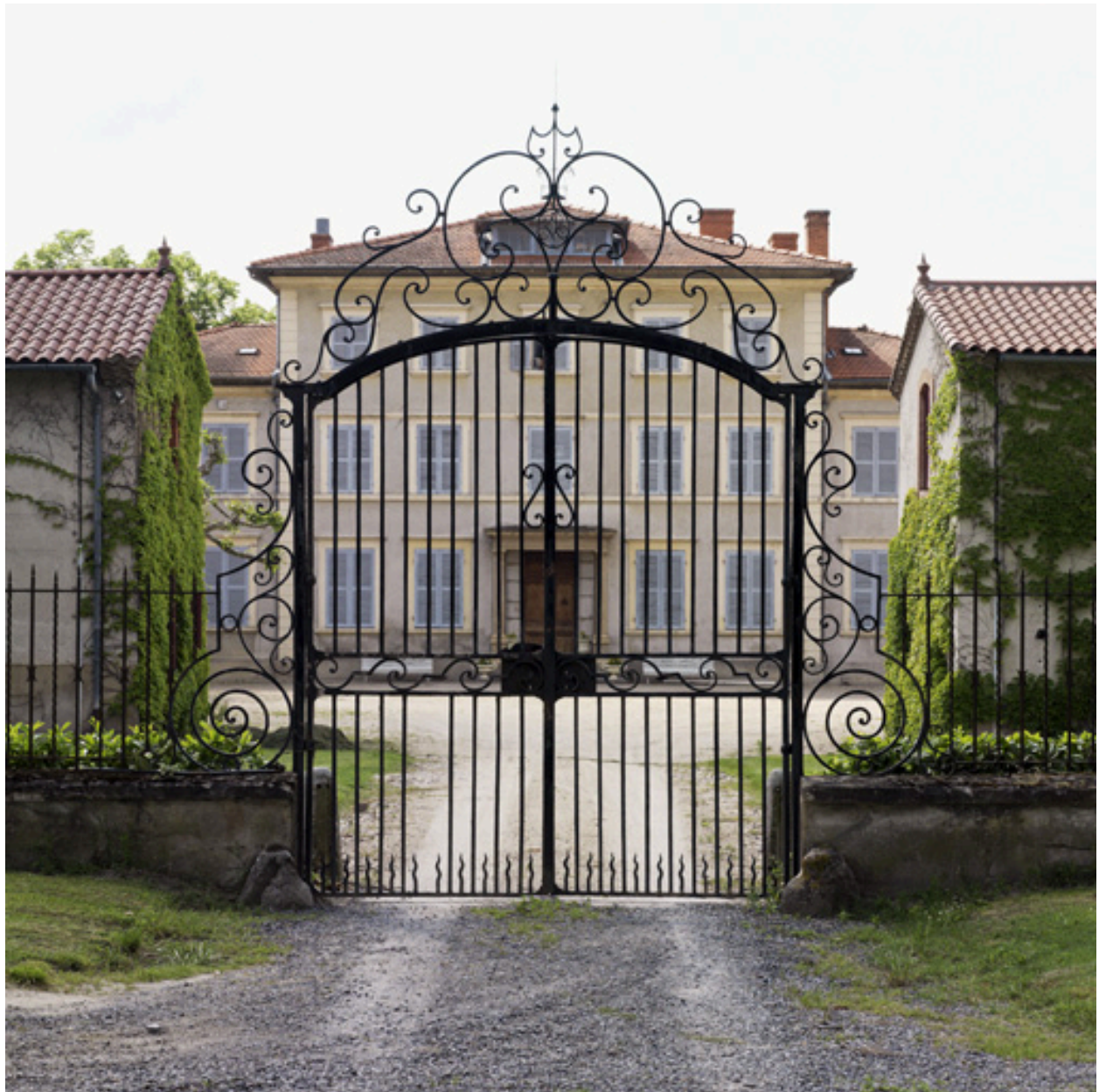
Vue du portail de la cour.
