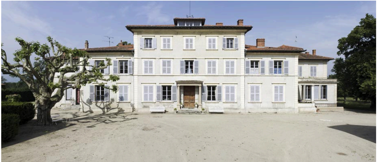
Vue d'ensemble de la façade sur cour, depuis l'est.
