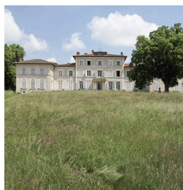
Vue d'ensemble de la façade sur jardin, depuis l'ouest. Phot. Didier Gourbin IVR82_20074201198NUCA
