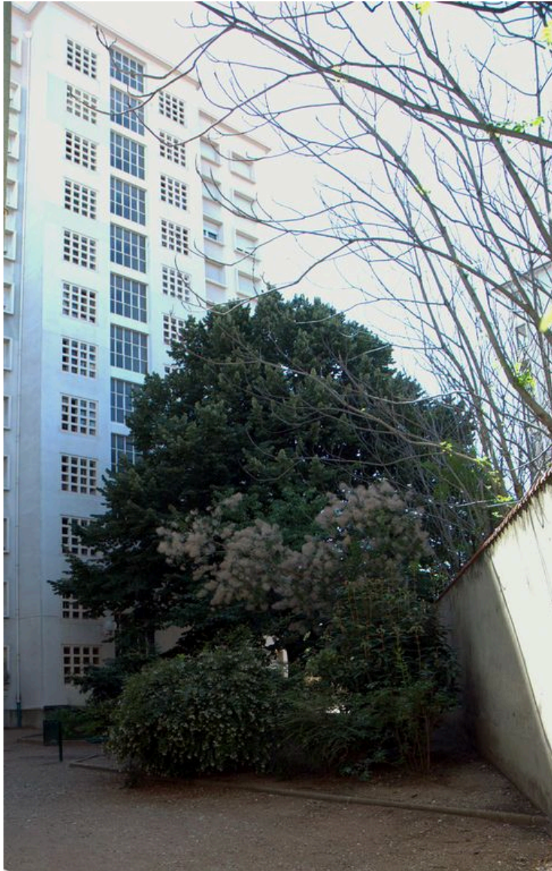
Immeuble n°66, élévation postérieure
