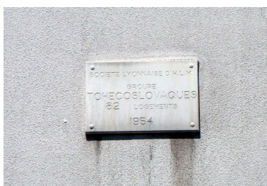
Détail de la plaque sur la façade du n°66 Phot. Maryannick Chalabi IVR82_20106905069NUCA
