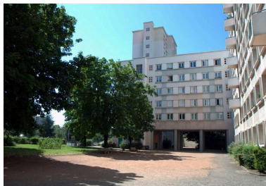
Vue partielle depuis le nord Phot. Maryannick Chalabi IVR82_20106905077NUCA
