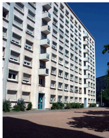
Immeuble n°58-60, vue partielle depuis le sud-est Phot. Maryannick Chalabi IVR82_20106905076NUCA
