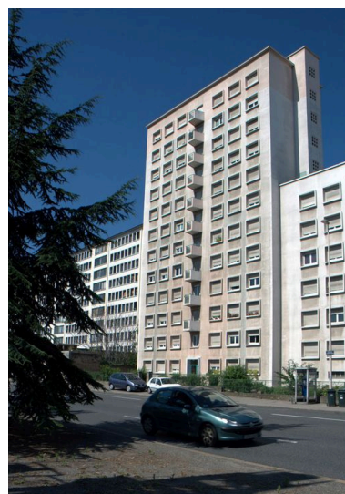
Immeuble n°66, vue d'ensemble depuis le nord-est Phot. Maryannick Chalabi IVR82_20106905068NUCA
