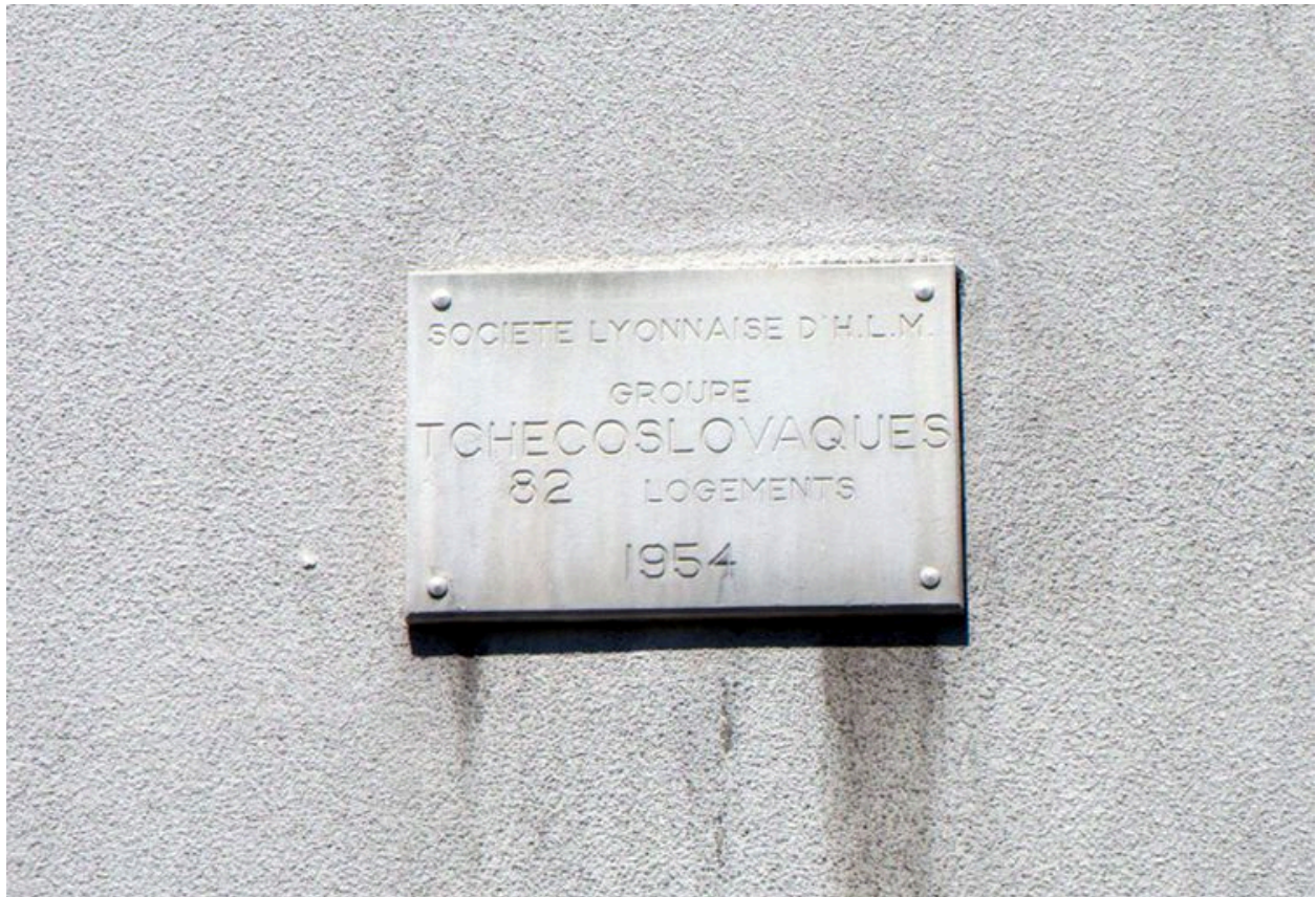
Détail de la plaque sur la façade du n°66
