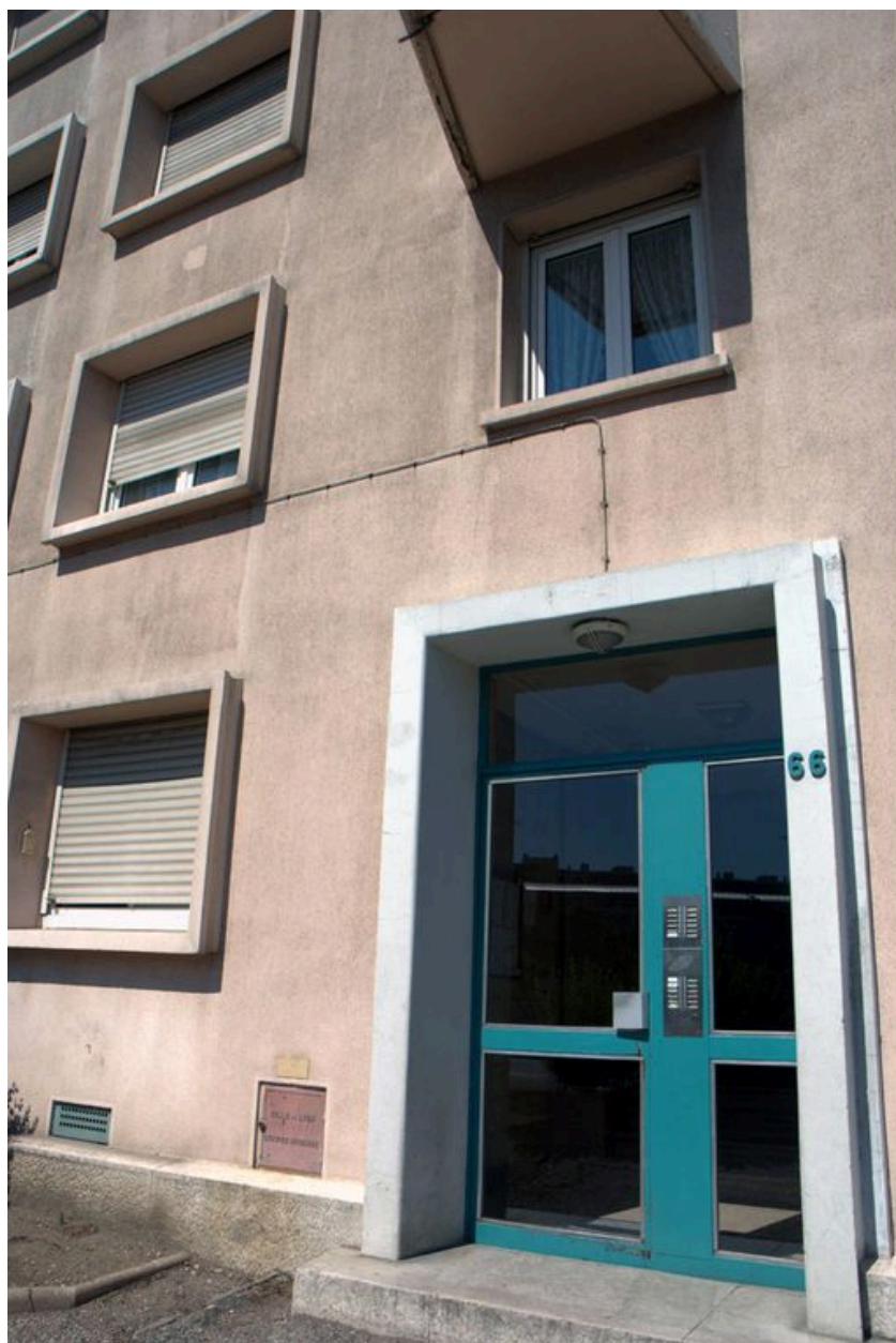
N°66, détail de la porte d'entrée
