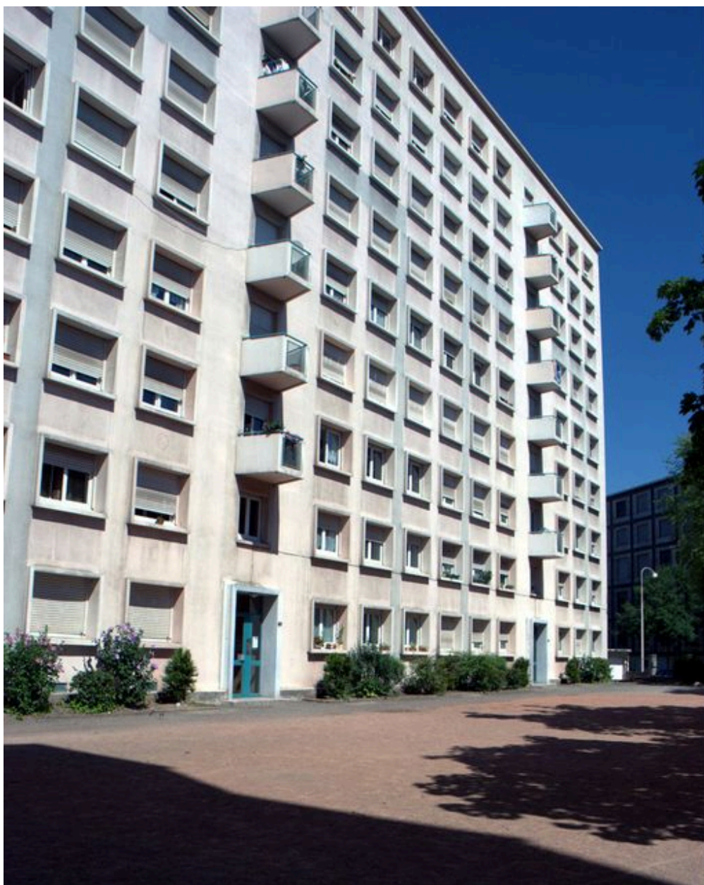
Immeuble n°58-60, vue partielle depuis le sud-est
