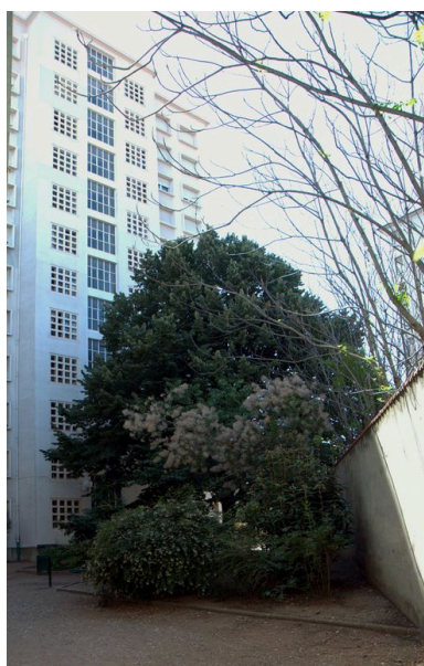
Immeuble n°66, élévation postérieure Phot. Maryannick Chalabi IVR82_20106905078NUCA
