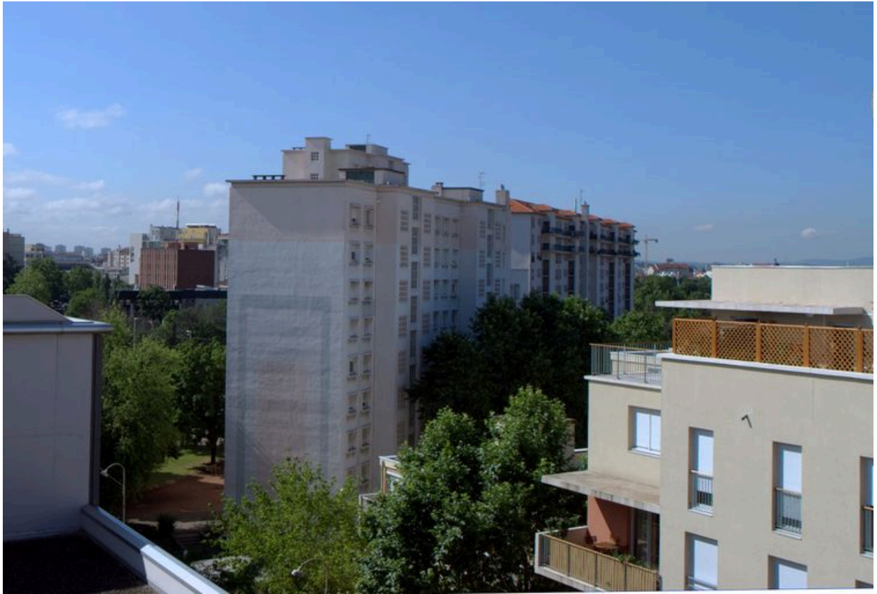
Elévation postérieure, partie supérieure, depuis le nord-ouest
