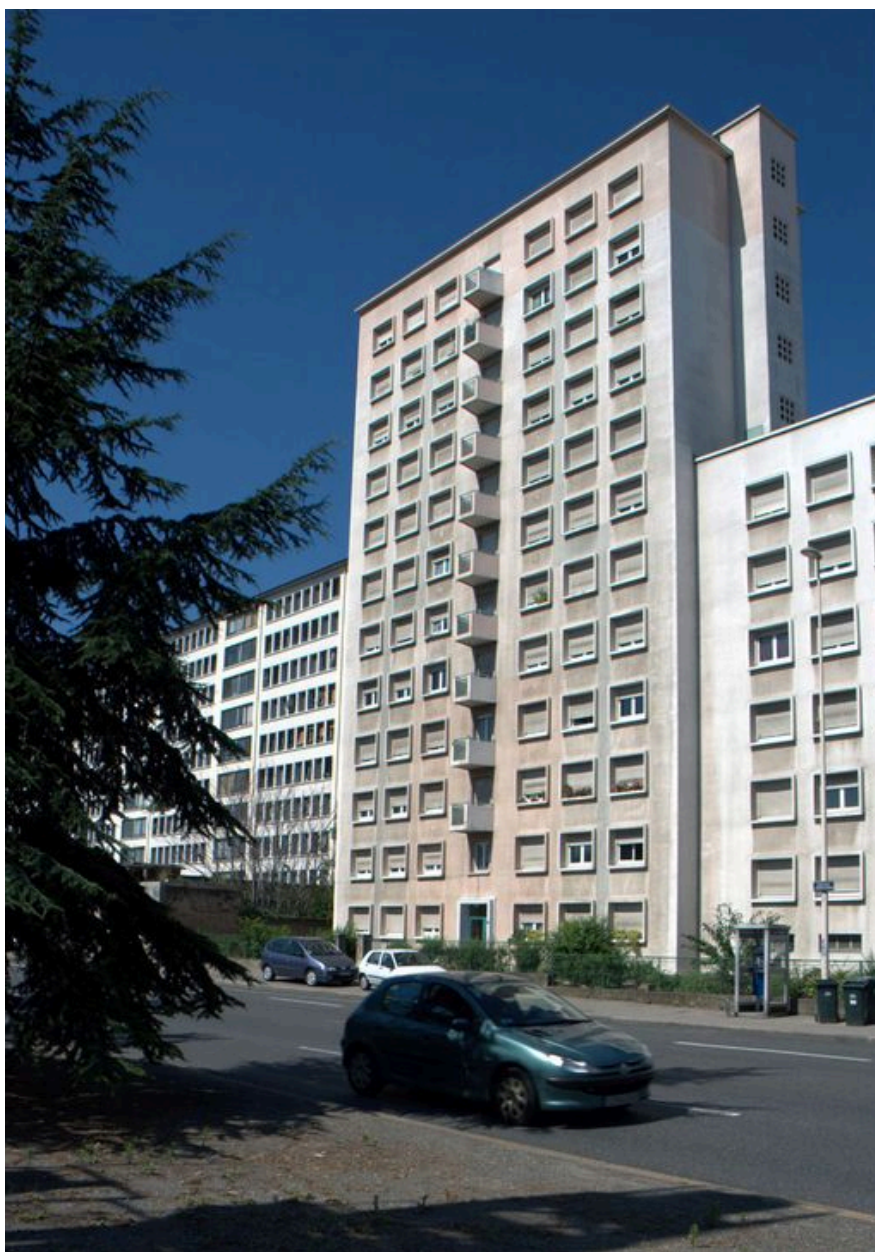
Immeuble n°66, vue d'ensemble depuis le nord-est
