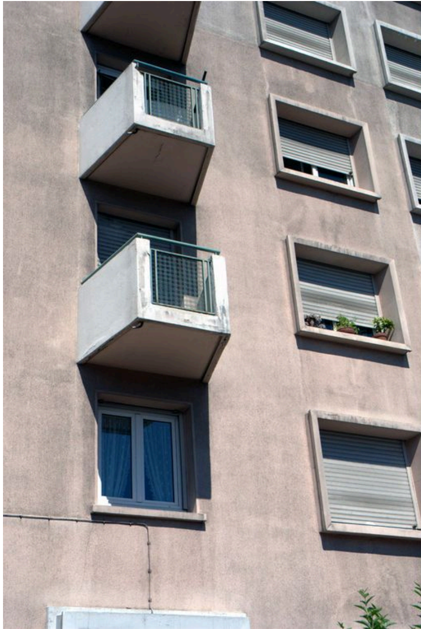
N°66, détail de la travée centrale
