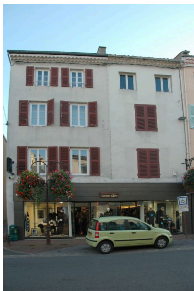
Elévation principale sur la rue Tupinerie (maison de gauche). Phot. Simone Hartmann-Nussbaum IVR82_20114200657NUCA
