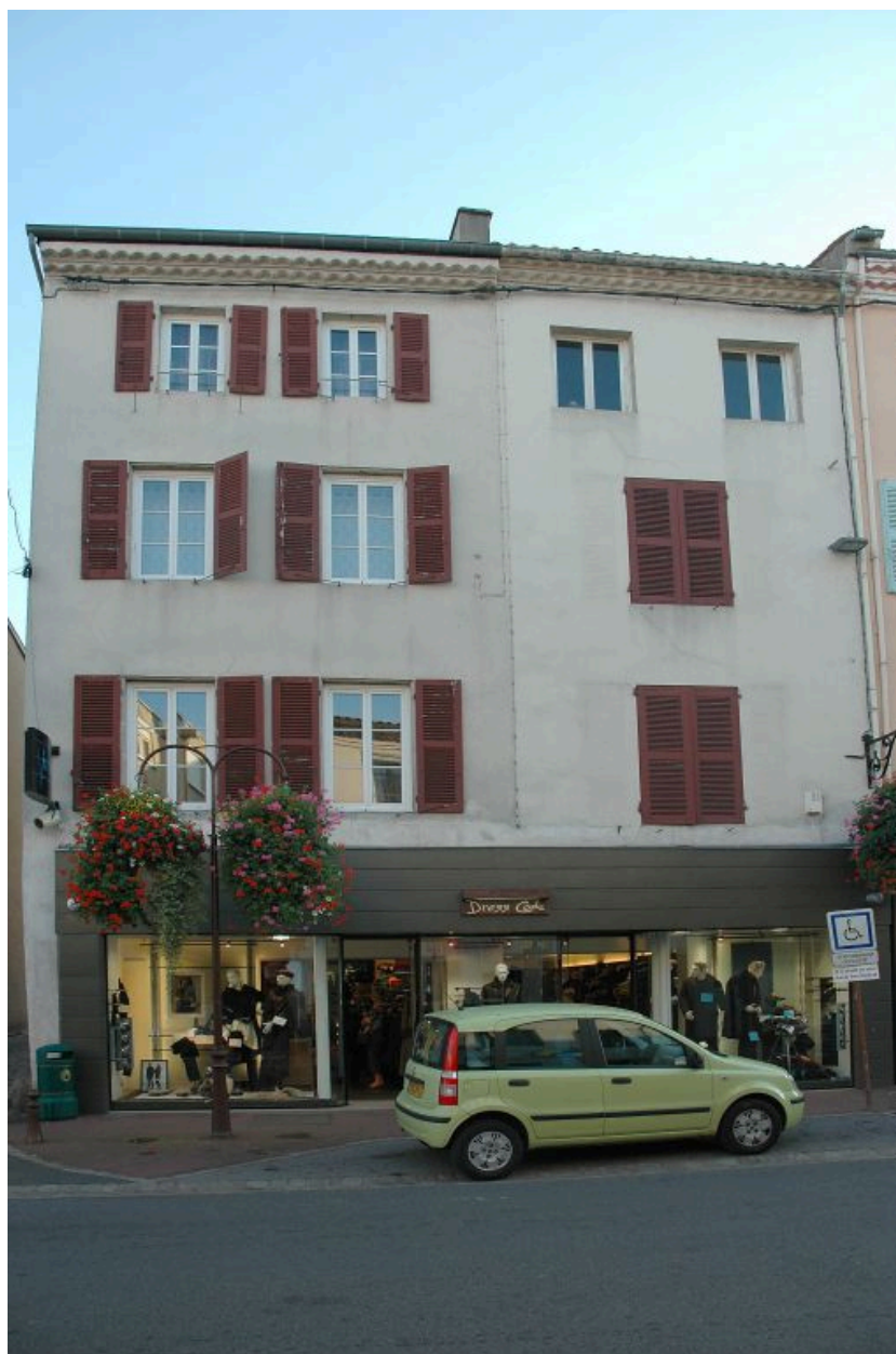
Elévation principale sur la rue Tupinerie (maison de gauche).
