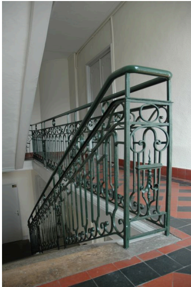
Palier de l'escalier.
