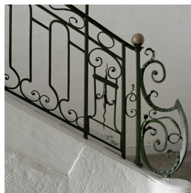
Départ de l'escalier, rampe en fer forgé avec départ à motif de courbe en S (rampe rehaussée). Phot. Eric Dessert IVR82_20064200582NUCA
