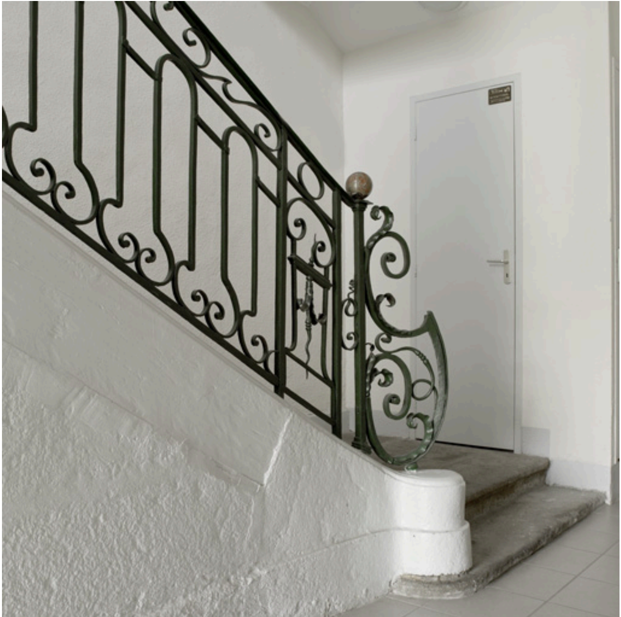
Première volée de l'escalier.
