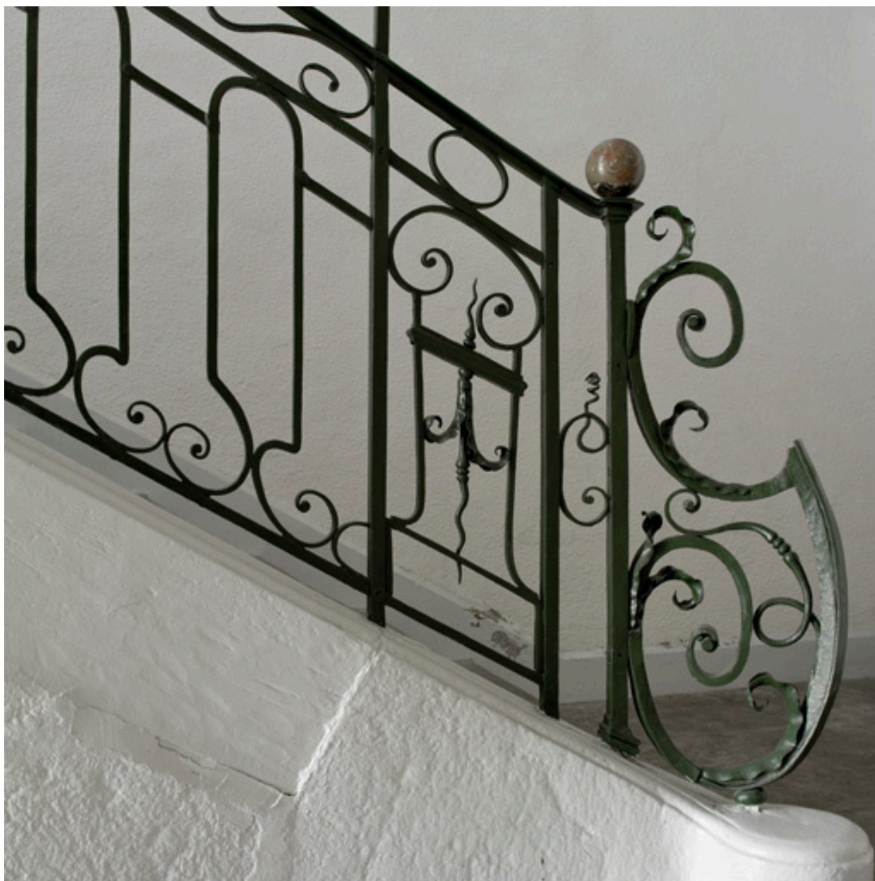
Départ de l'escalier, rampe en fer forgé avec départ à motif de courbe en S (rampe rehaussée).
