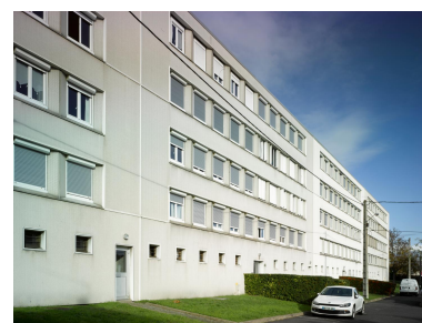
Détail du grand immeuble collectif nord-ouest : les accès depuis l'étage de soubassement. Phot. Christian Parisey IVR84_20206301086NUCA
