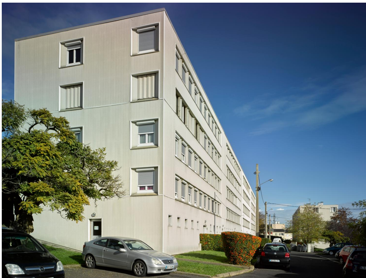
L'immeuble collectif nord-ouest de la cité (fin des années 1960 - début des années 1970).
