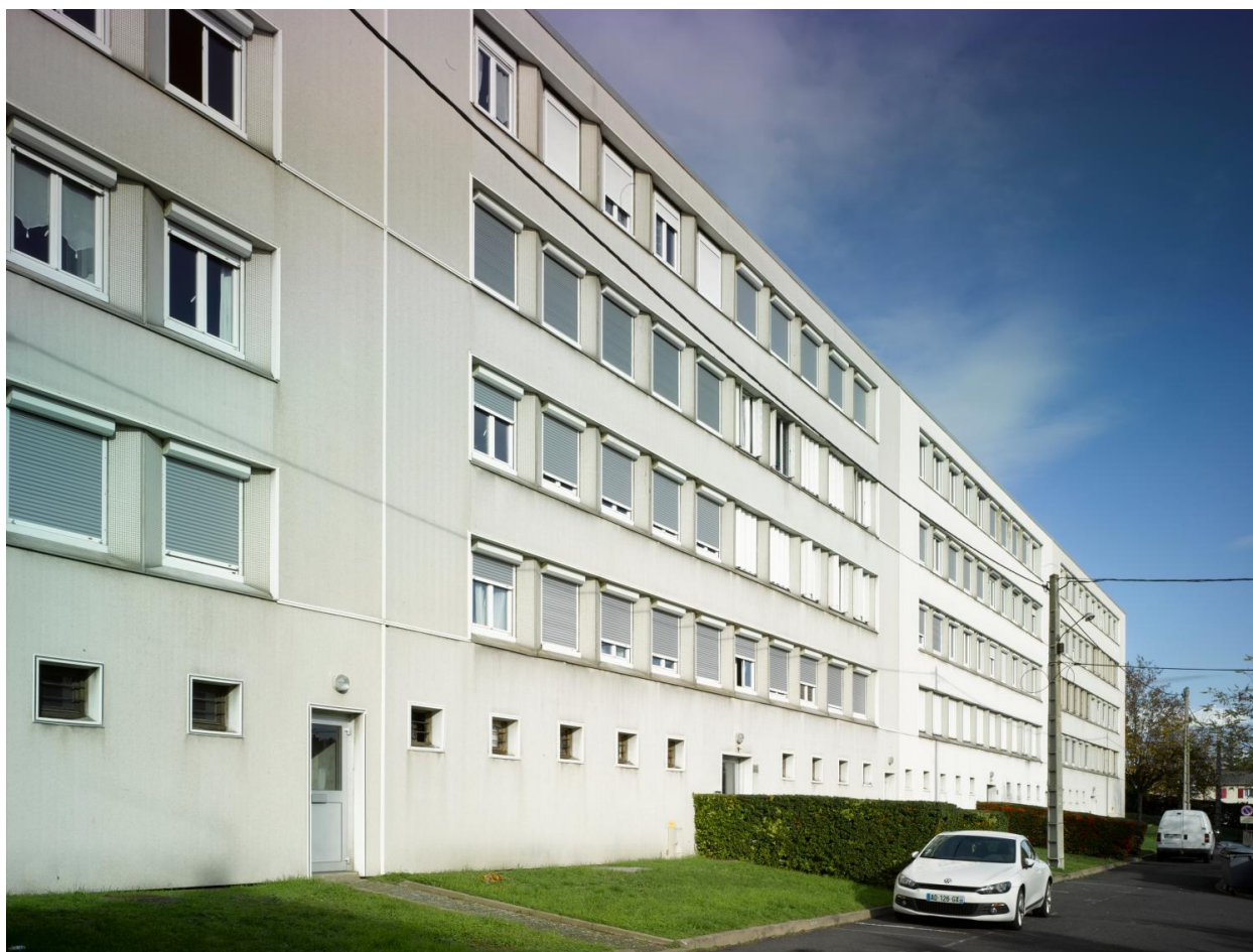
Détail du grand immeuble collectif nord-ouest : les accès depuis l'étage de soubassement.
