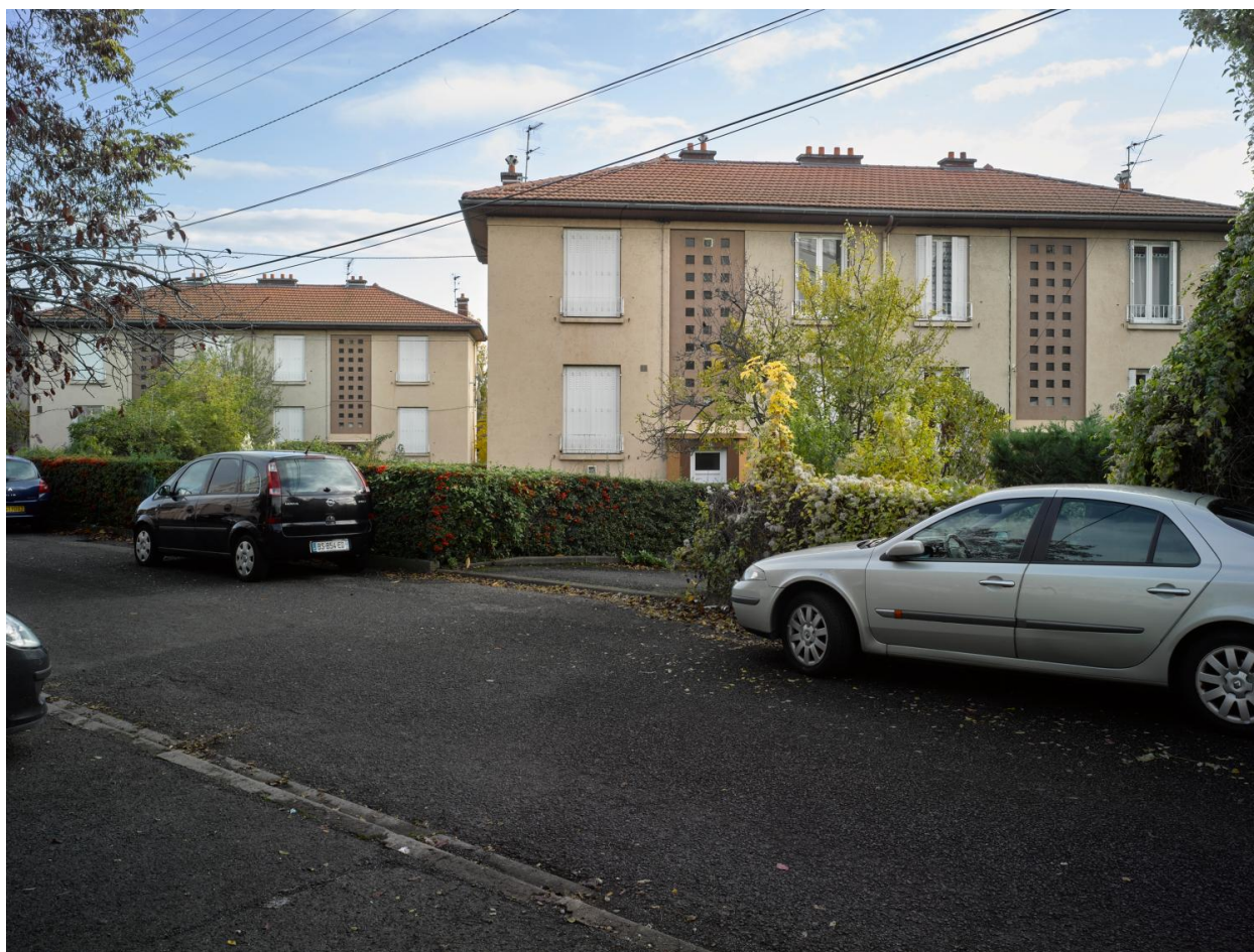
Les deux maisons quadruples reconstruites au tournant des années 1940-1950, selon un type O "modernisé", allée des Abricotiers.
