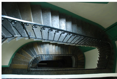
Vue intérieure : l'escalier vu en plongée Phot. Catherine Guillot IVR82_20126901030NUCA
