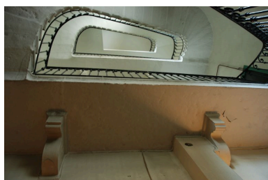
Vue intérieure : consoles soutenant le palier Phot. Catherine Guillot IVR82_20126901027NUCA
