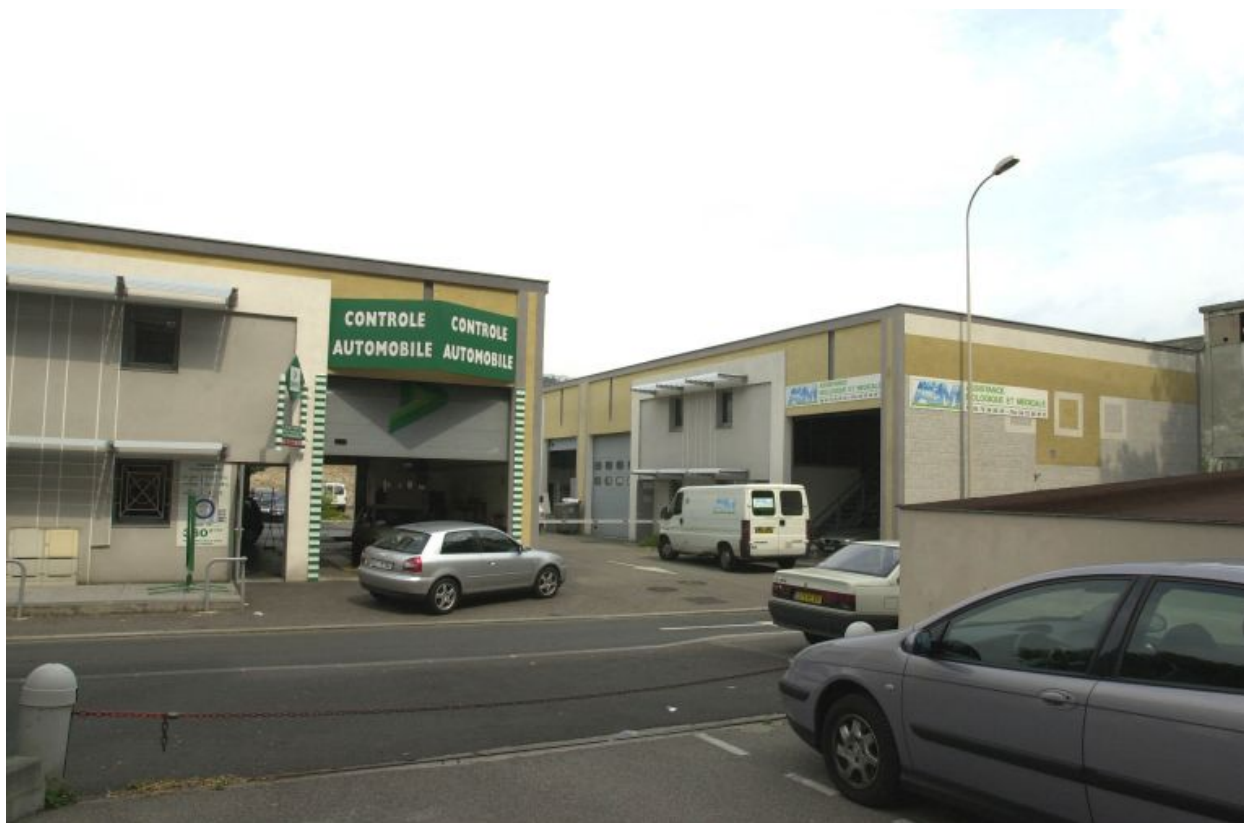
Vue de la partie nord depuis le sud-est
