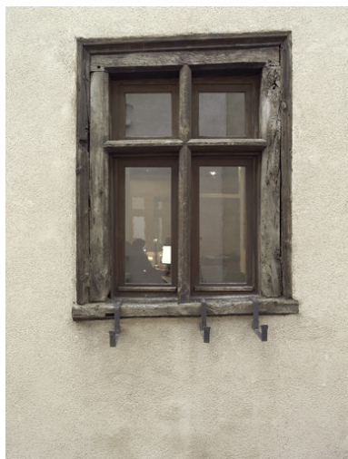
Fenêtres à croisées en bois sur l'élévation latérale. Phot. Didier Gourbin IVR82_20074201276NUCA
