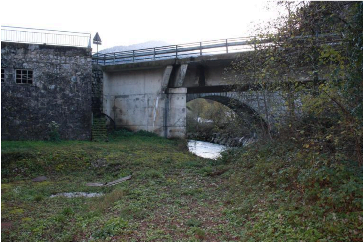
Pont de Gys, détail culée rive droite
