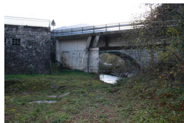
Pont de Gys, détail culée rive droite Phot. Benoît Huraut IVR84_20207401455NUCA
