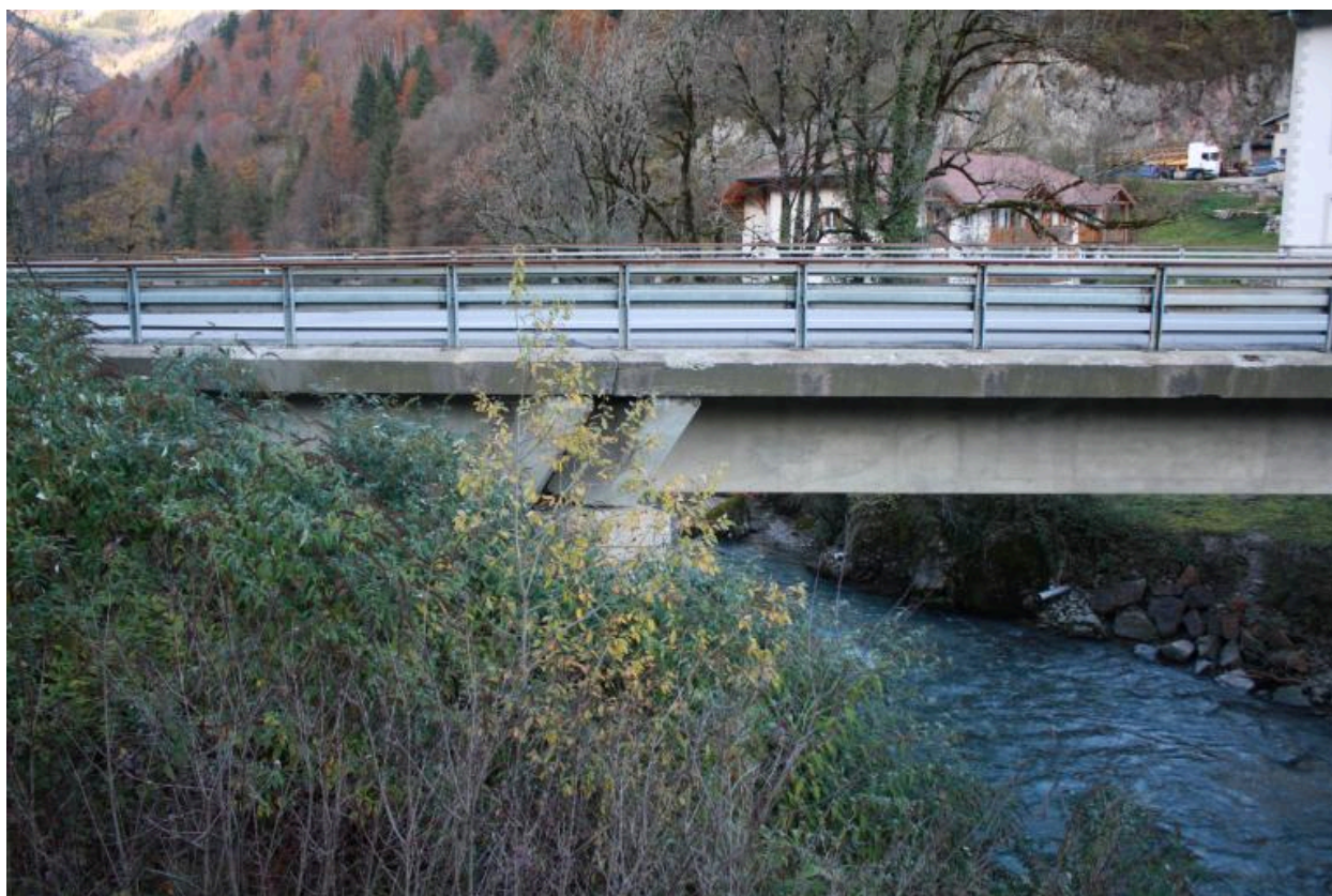
Pont de Gys, face amont gauche
