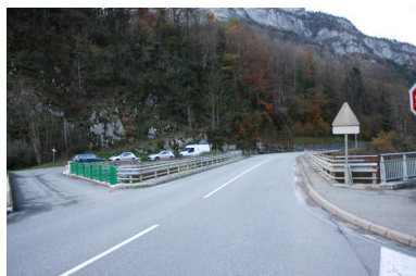
Pont de Gys, cjaussée et gardes corps Phot. Benoît Huraut IVR84_20207401453NUCA
