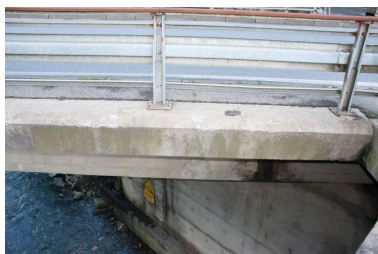
Pont de Gys, détails plinthe et garde corps Phot. Benoît Huraut IVR84_20207401454NUCA
