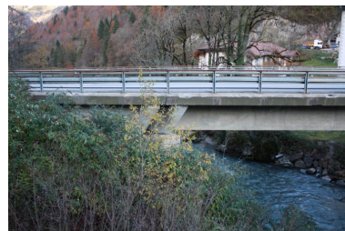
Pont de Gys, face amont gauche Phot. Benoît Huraut IVR84_20207401456NUCA
