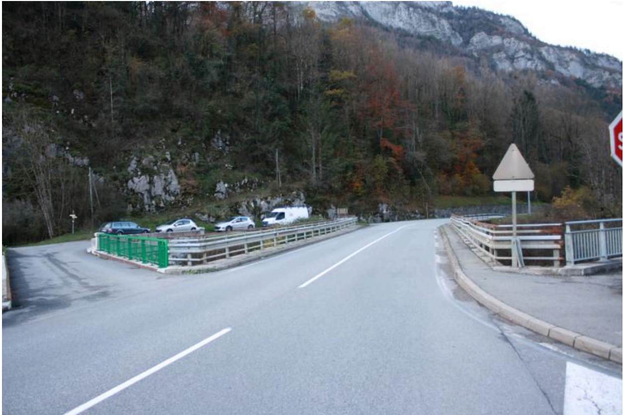
Pont de Gys, cjaussée et gardes corps
