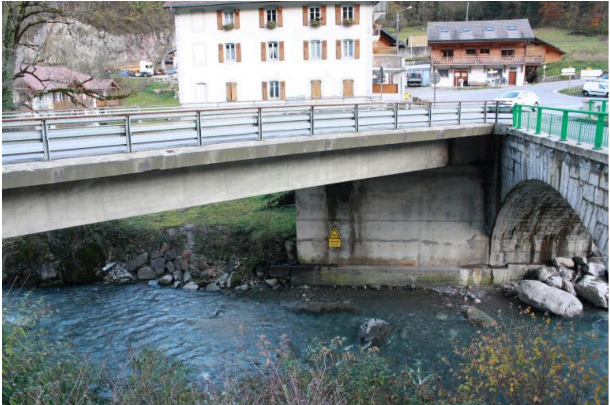
Pont de Gys, face amont droite
