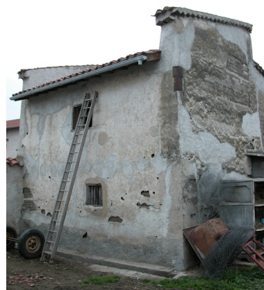
Vue d'ensemble. Phot. Caroline Guibaud IVR82_20134204215NUCA
