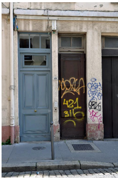
Elévation sur rue, portes jumelées Phot. Catherine Guégan IVR84_20176901351NUCA
