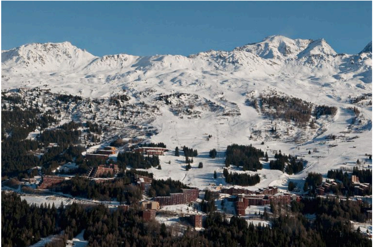
Vue aérienne depuis l'ouest. Charvet dans le site
