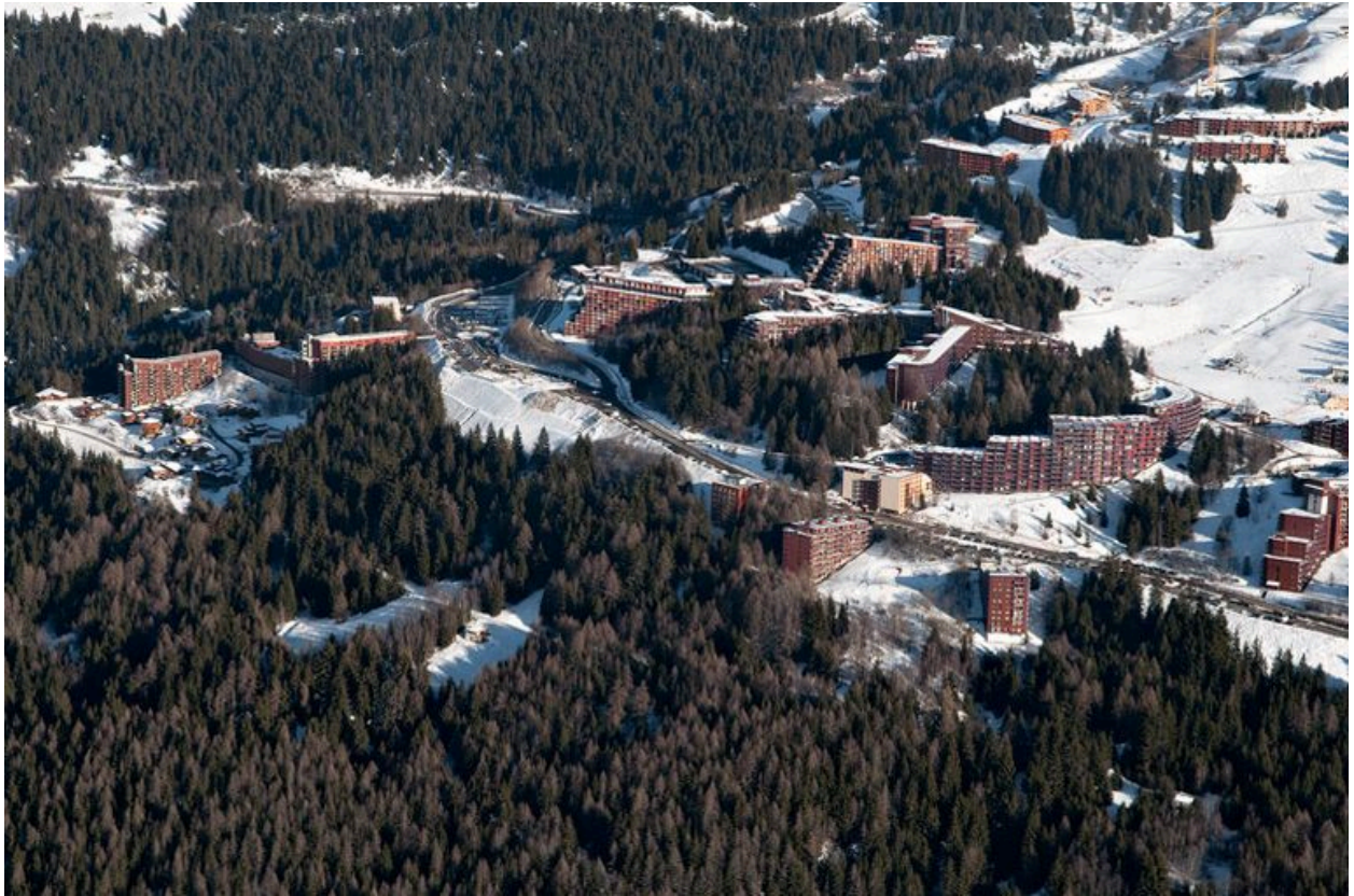
Vue aérienne depuis l'ouest. Charvet
