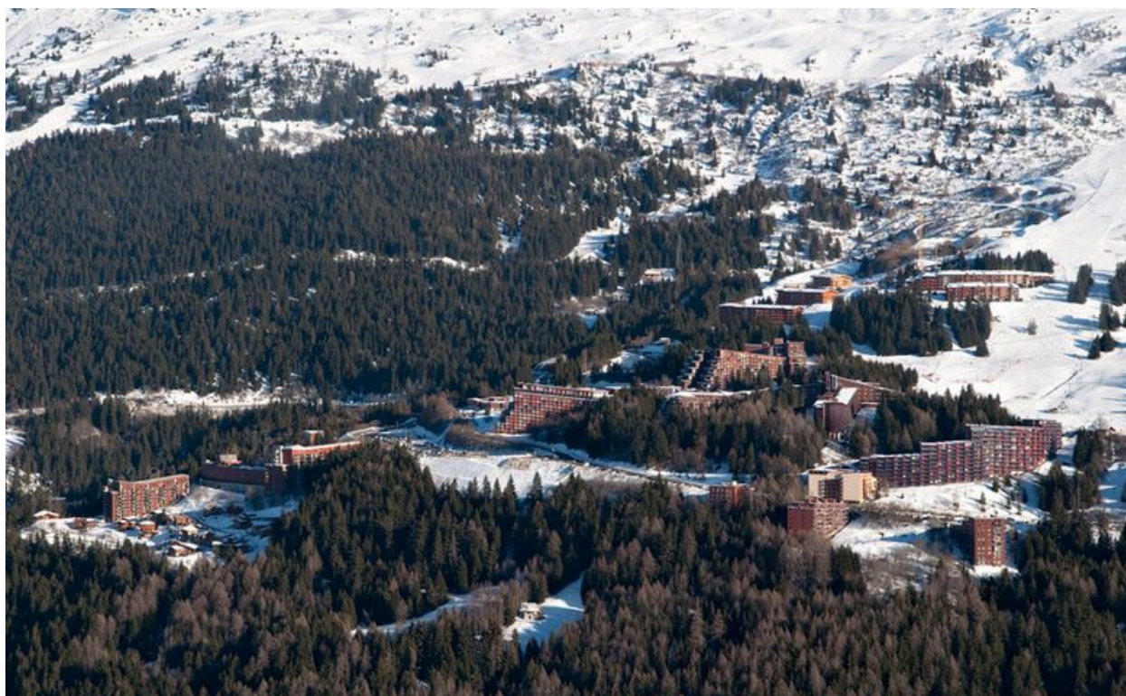
Vue aérienne depuis l'ouest. Charvet
