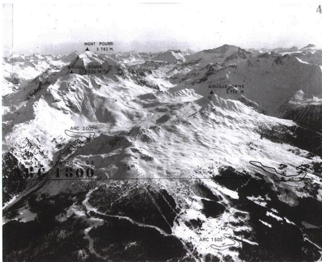
Vue aérienne du site. 1970 (A. privées Atelier d'Architecture en Montagne)
