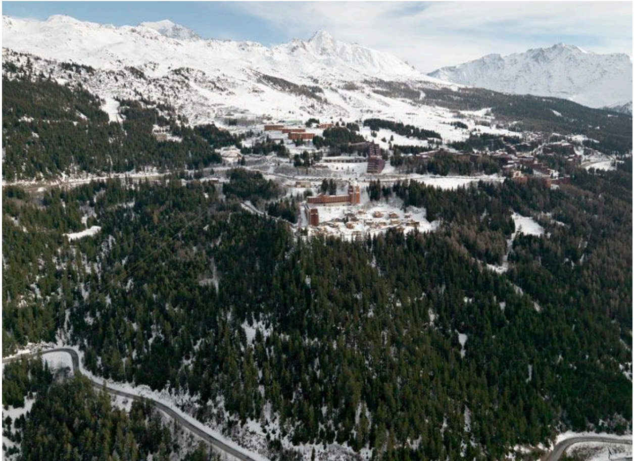
Vue aérienne depuis l'ouest. Charvet
