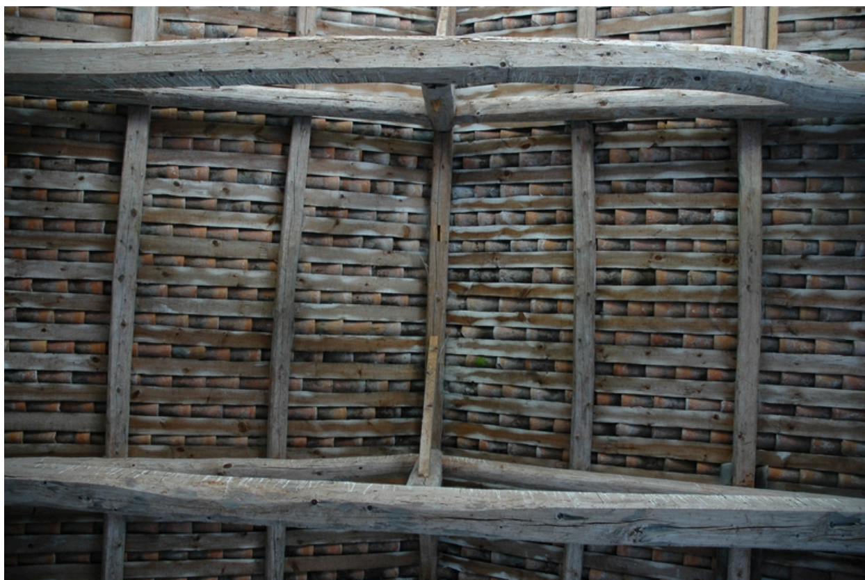
Vue intérieure du bâtiment partiellement en ruine au nord-est de la première cour : charpente.
