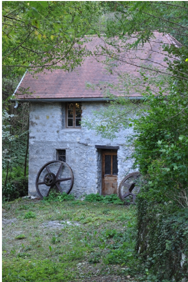
Vue générale du moulin, façade nord Phot. Yannick Milleret IVR82_20117302016NUCA
