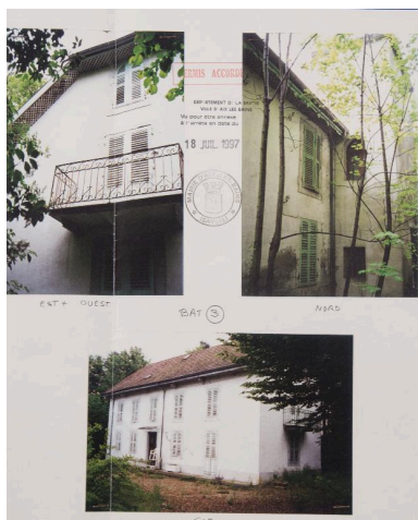
Montage fotogr., état avant démolition, 1997 Repro. Denys Harreau IVR82_20157300775NUCB
