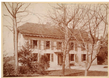
Vue générale prise depuis le sud, vers 1898 Repro. Denys Harreau IVR82_20137301173NUCB
