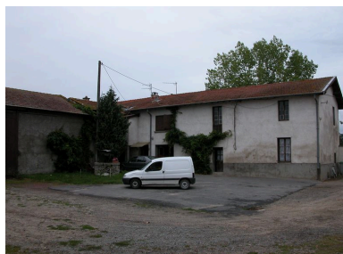
Vue d'ensemble du logis. Phot. Thierry Monnet IVR82_20124203091NUCA
