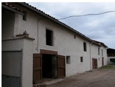
Vue de la grange-étable nord. Phot. Thierry Monnet IVR82_20124203089NUCA
