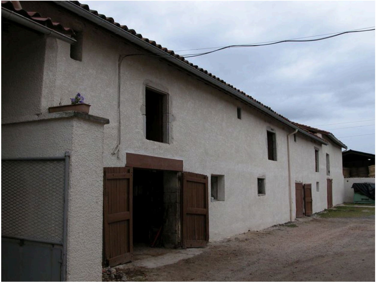
Vue de la grange-étable nord.
