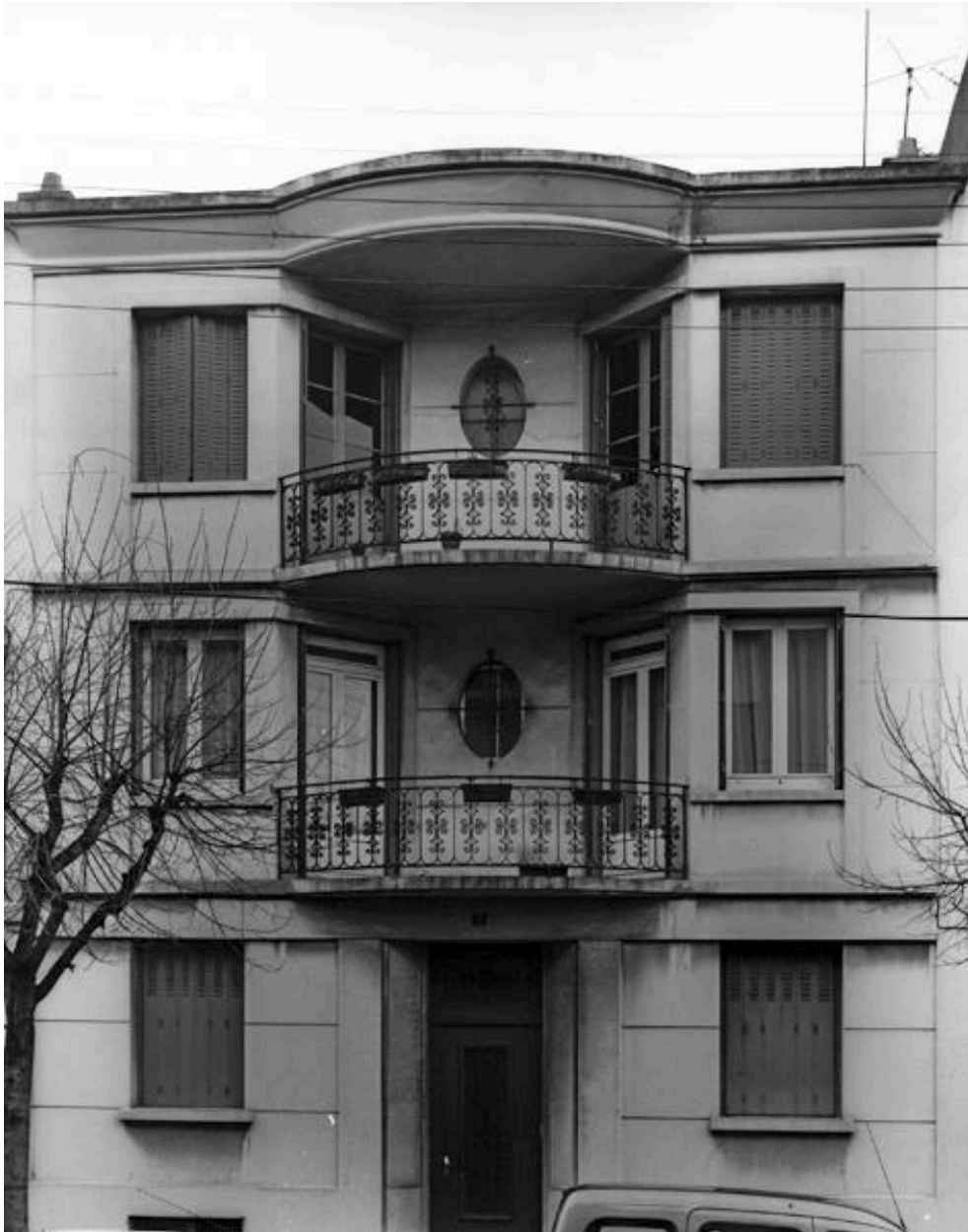
Travée centrale de la façade
