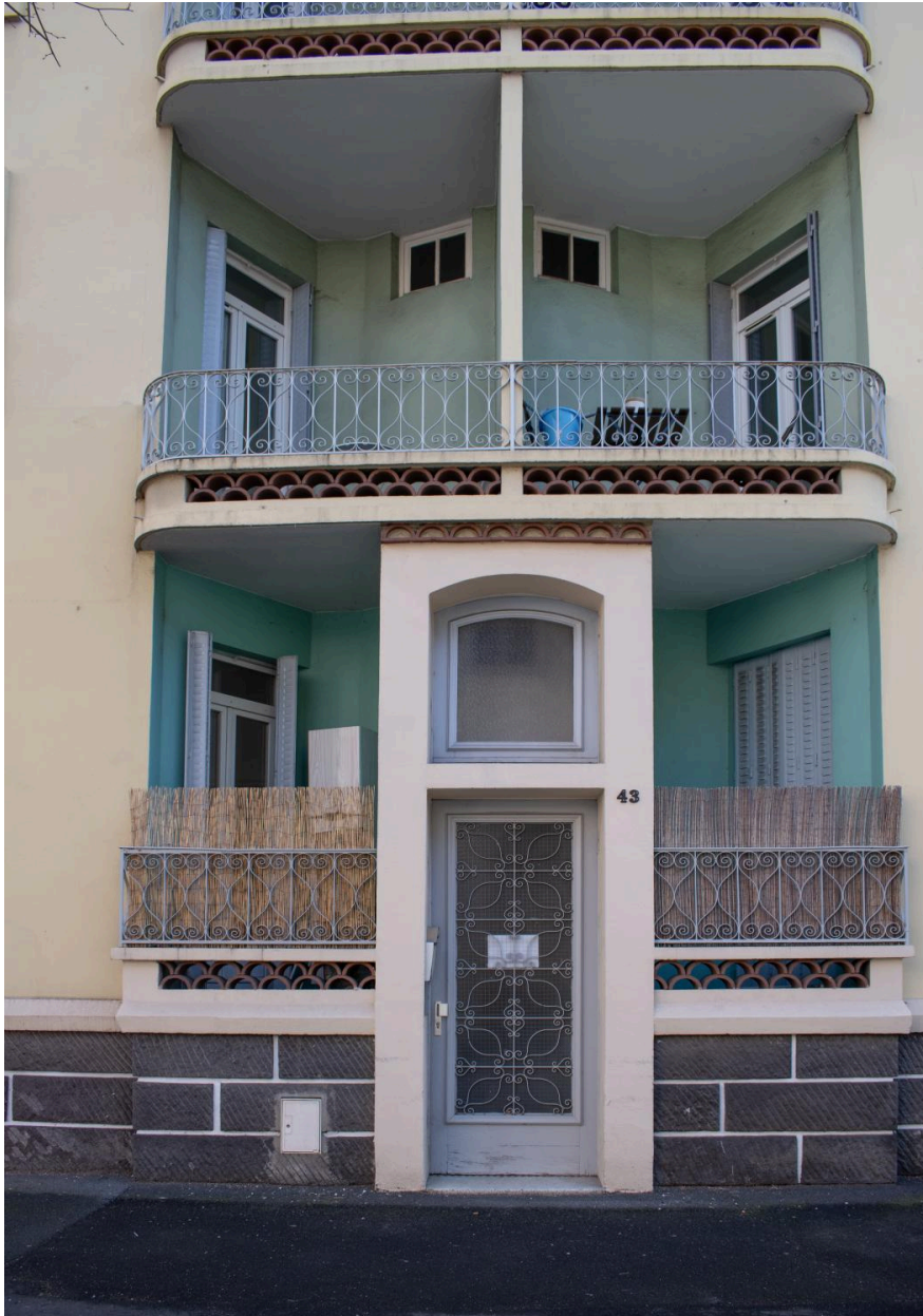
Edifice de comparaison, n°43 boulevard Aristide-Briand. Travée centrale
