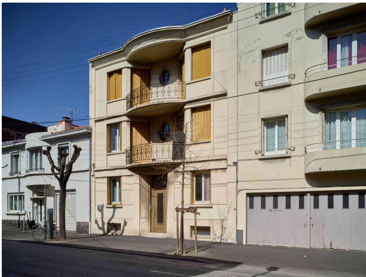
Façade sur le boulevard Jean-Jaurès
