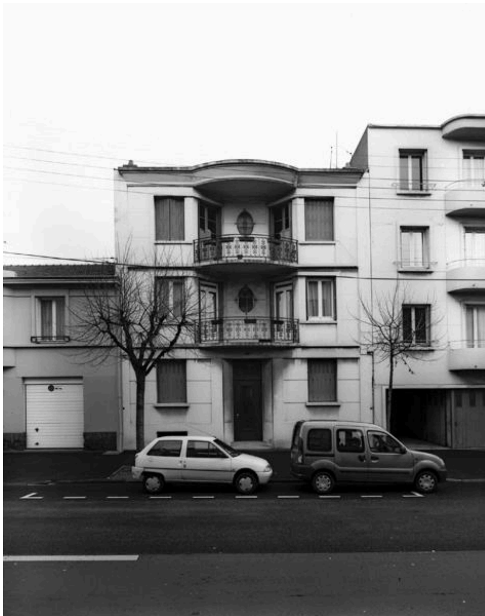
Vue de la façade de l'immeuble sur le boulevard
