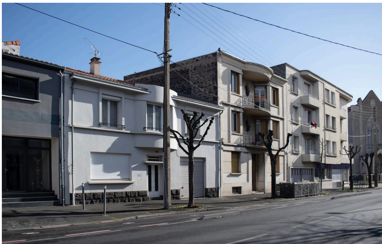
Façades sur le boulevard Jean-Jaurès
