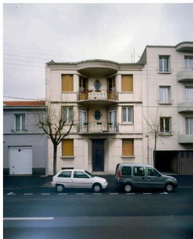
Vue de la façade sur le boulevard Phot. Roger Choplain, Phot. Roland Maston IVR83_20006300422VA
