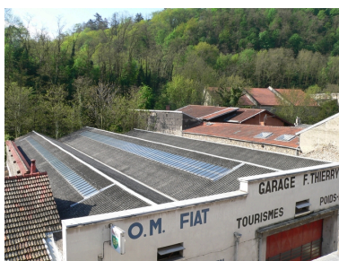
Toits Phot. Isabelle Dupuis IVR82_20093800405NUCA
