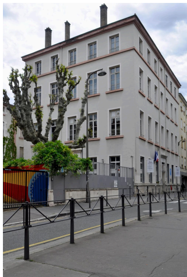
Bâtiment sur rue, vue générale nord Phot. Magali Delavenne IVR84_20216901096NUCA
