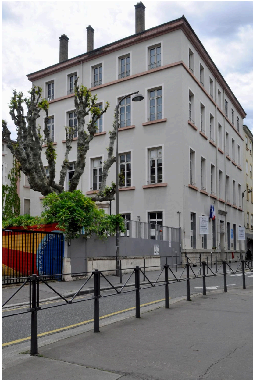
Bâtiment sur rue, vue générale nord
