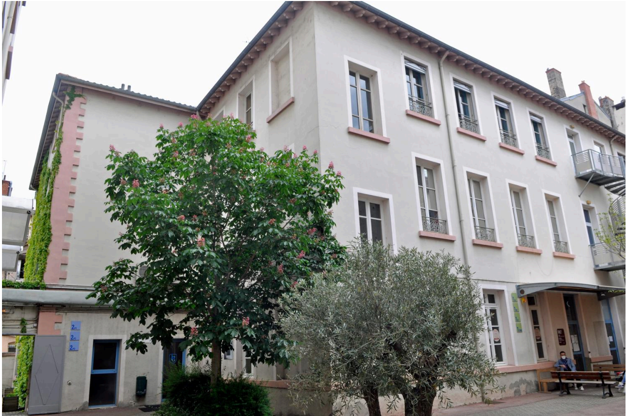
Bâtiment en retour, vue d'ensemble sud-ouest
