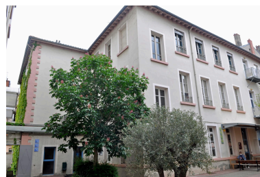
Bâtiment en retour, vue d'ensemble sud-ouest Phot. Magali Delavenne IVR84_20216901106NUCA
