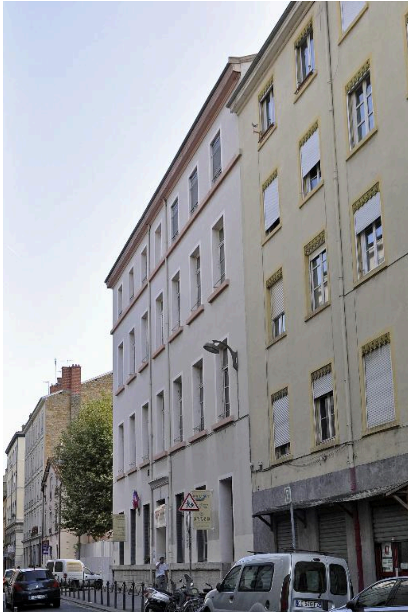
Bâtiment sur rue, élévation antérieure
