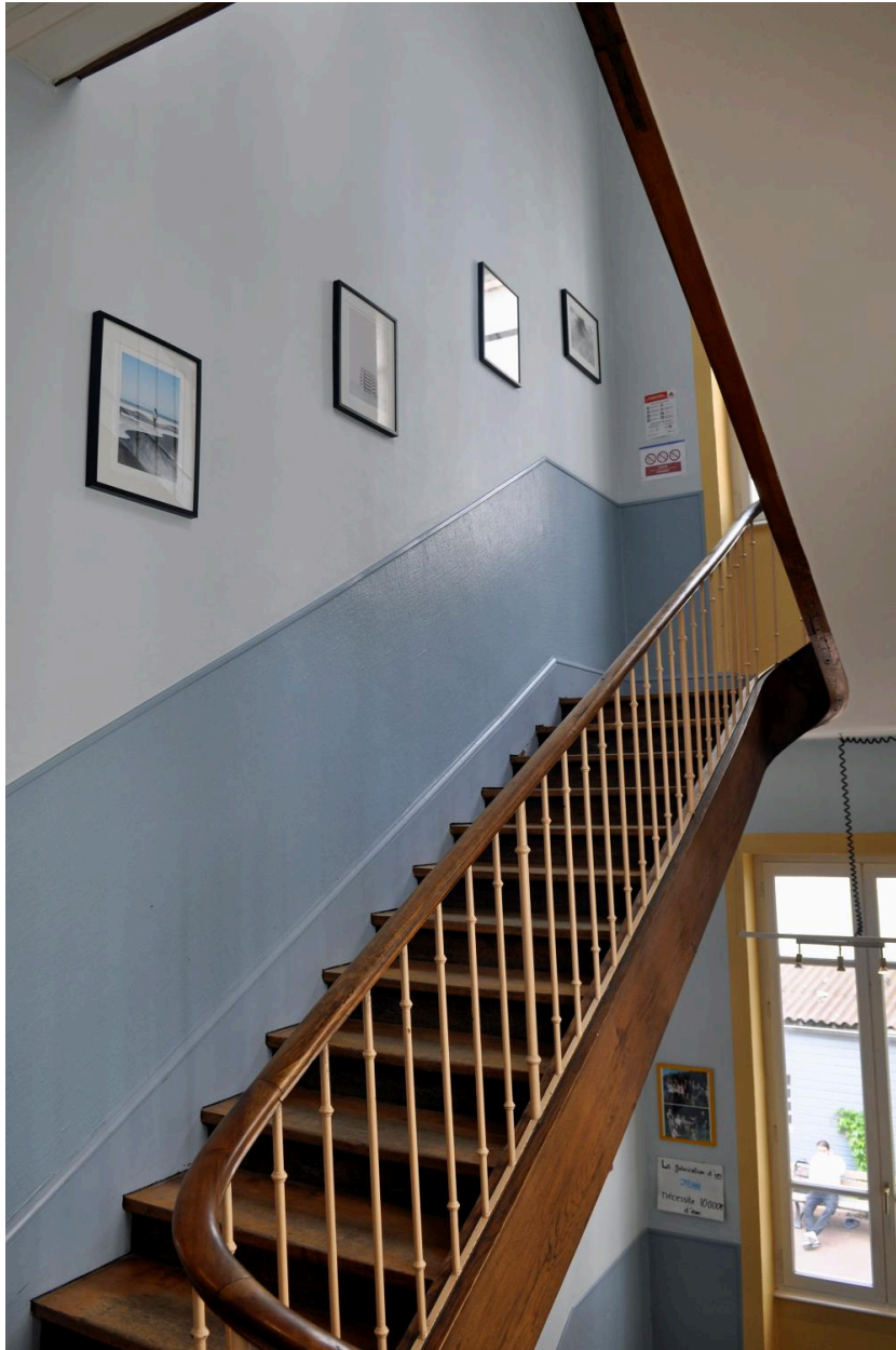
Bâtiment en retour, escalier latéral en bois
