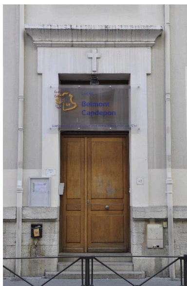
Bâtiment sur rue, porte ouvrant sur rue (43 rue Pasteur) Phot. Catherine Guégan IVR82_20156902526NUCA
