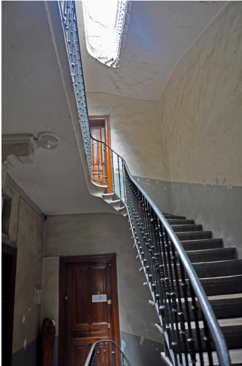
Bâtiment sur cour, escalier en milieu de bâtiment, à éclairage zénithal
