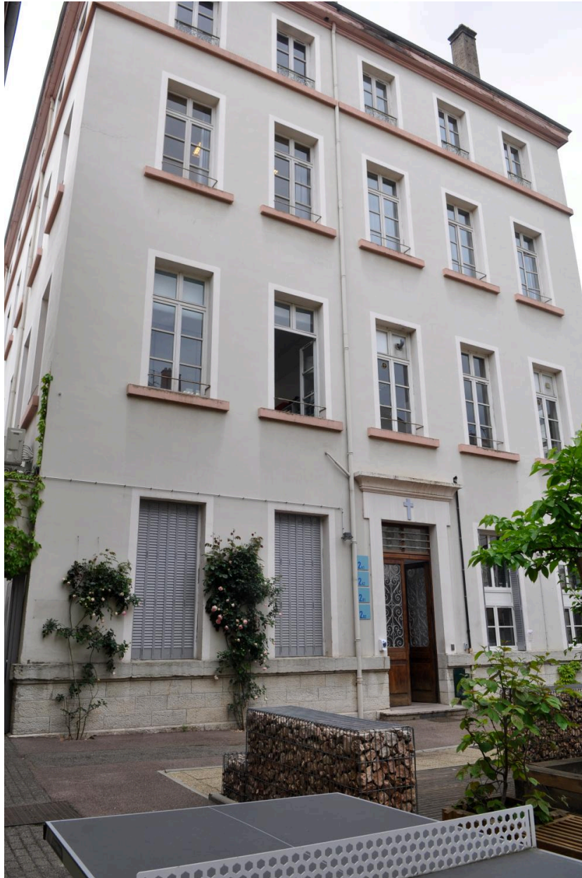
Bâtiment sur rue, élévation latérale
