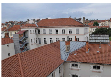
Bâtiment sur rue, vue d'ensemble est (en arrière-plan) Phot. Catherine Guégan IVR82_20156902528NUCA
