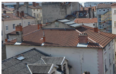
Bâtiment sur cour, vue de toiture, depuis le nord Phot. Catherine Guégan IVR82_20156902531NUCA
