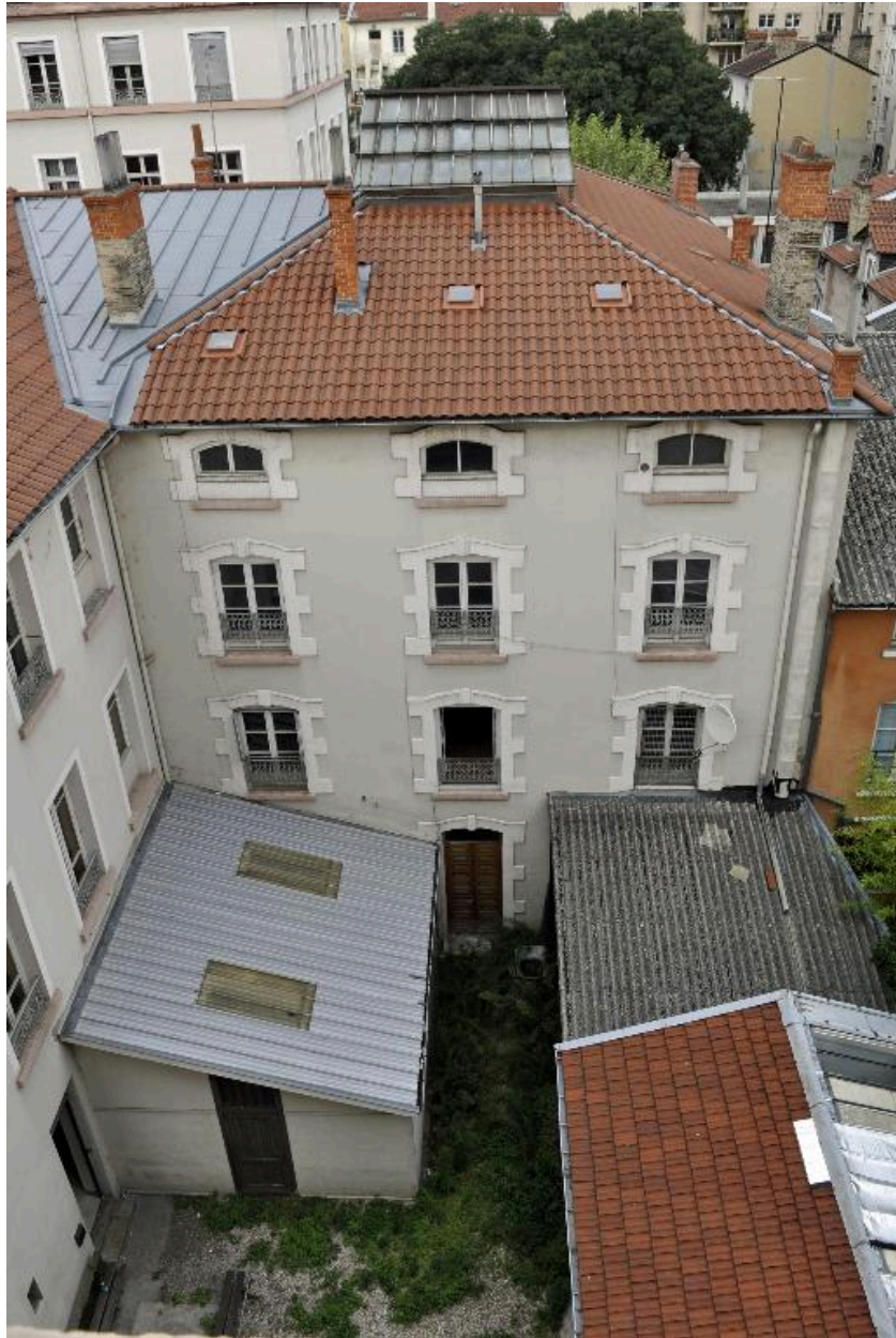
Bâtiment sur cour, élévation postérieure
