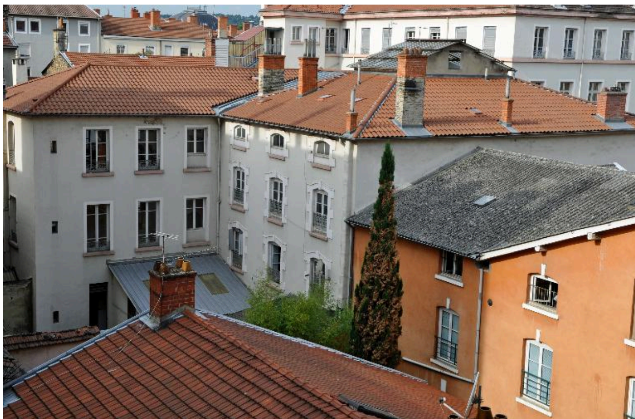
Vue générale des bâtiments en coeur de parcelle, depuis le nord-ouest
