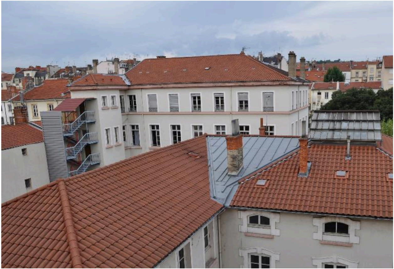
Bâtiment sur rue, vue d'ensemble est (en arrière-plan)
