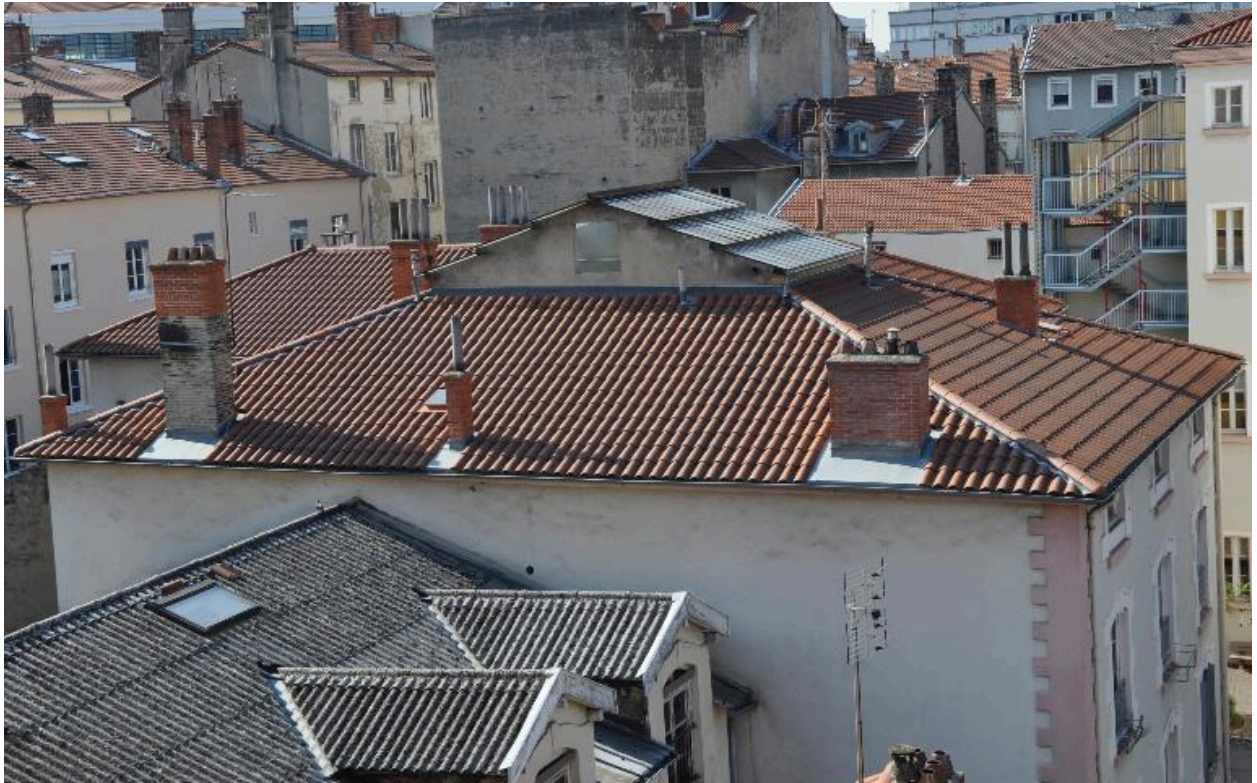
Bâtiment sur cour, vue de toiture, depuis le nord
