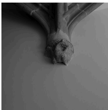
Voûte de l'allée, détail du culot 5 Phot. Eric Dessert IVR82_20046905850NUC
