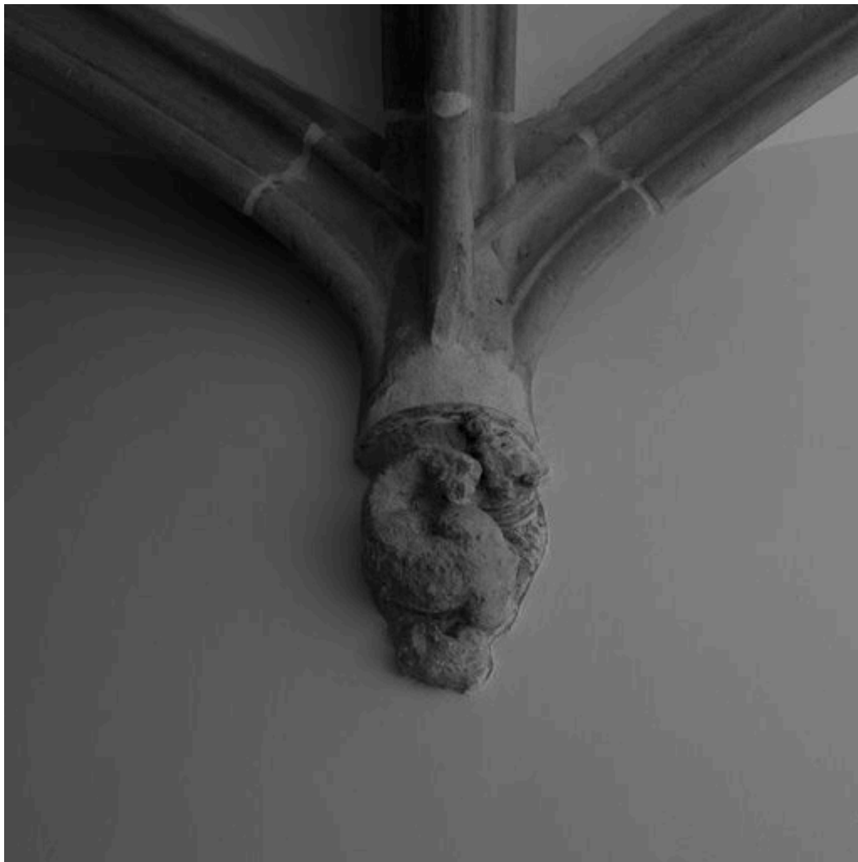
Voûte de l'allée, détail du culot 7
