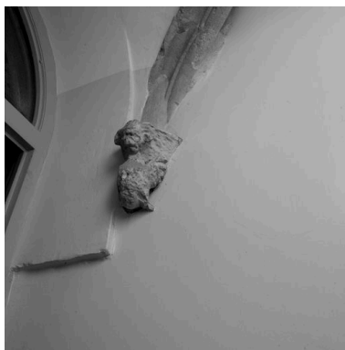
Voûte de l'allée, détail du culot 11 Phot. Eric Dessert IVR82_20046905844NUC
