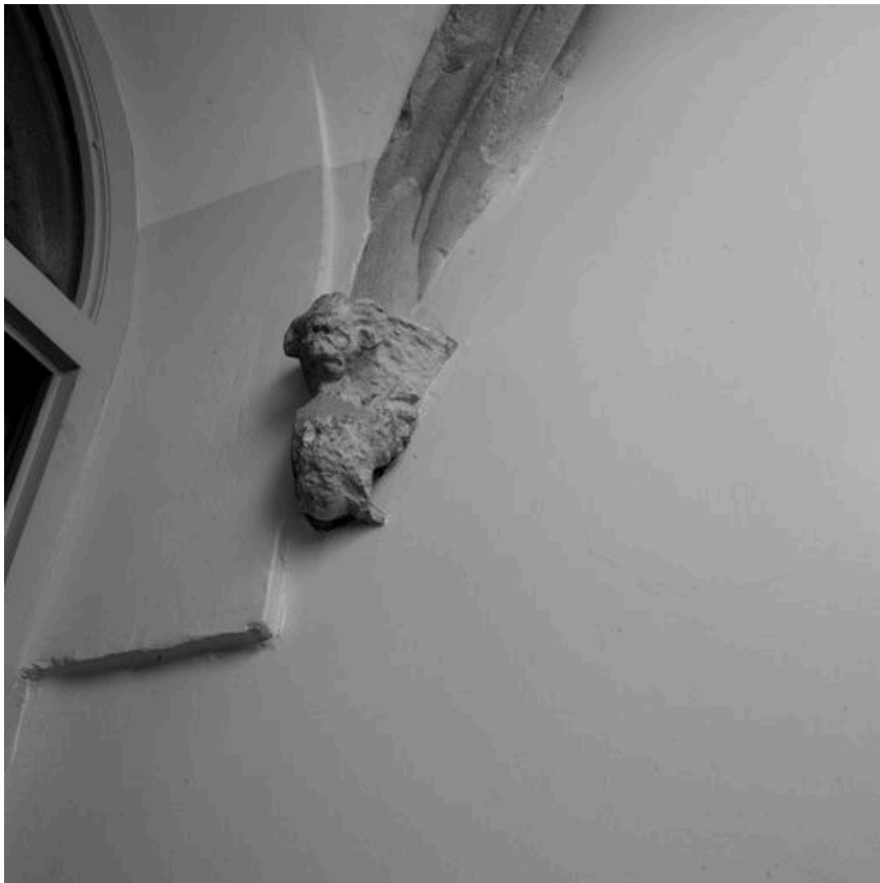
Voûte de l'allée, détail du culot 11
