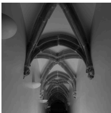
Voûte de l'allée, vue depuis l'entrée Phot. Eric Dessert IVR82_20046905855NUC
