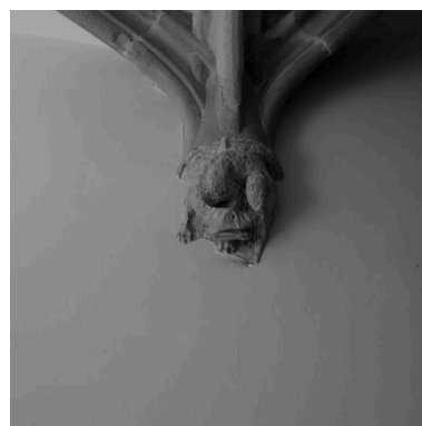
Voûte de l'allée, détail du culot 6 Phot. Eric Dessert IVR82_20046905849NUC
