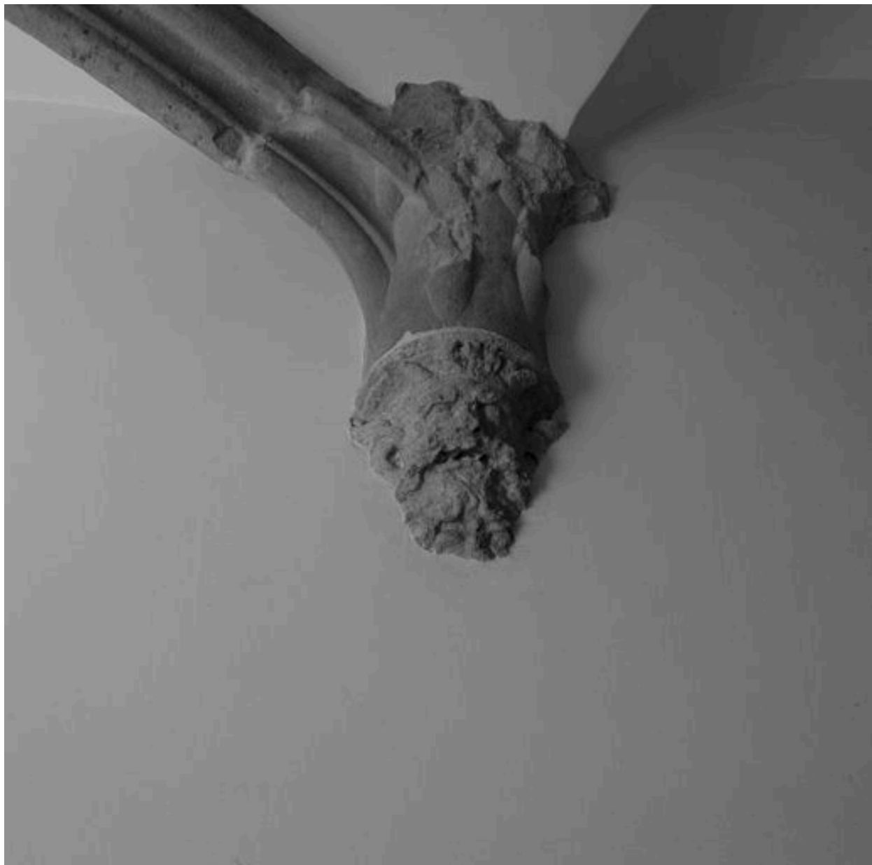
Voûte de l'allée, détail du culot 2
