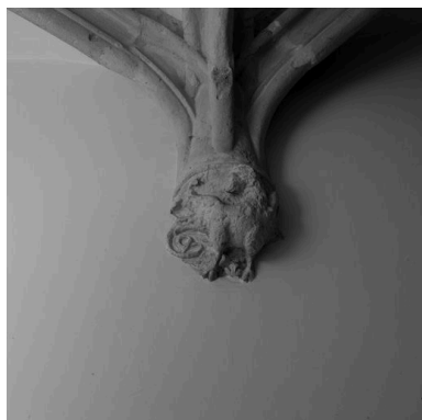
Voûte de l'allée, détail du culot 10 Phot. Eric Dessert IVR82_20046905845NUC
