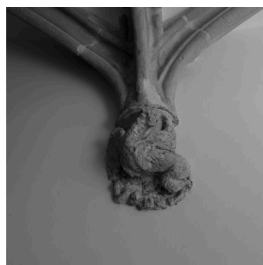
Voûte de l'allée, détail du culot 9 Phot. Eric Dessert IVR82_20046905846NUC
