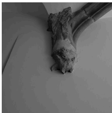
Voûte de l'allée, détail du culot 1 Phot. Eric Dessert IVR82_20046905853NUC
