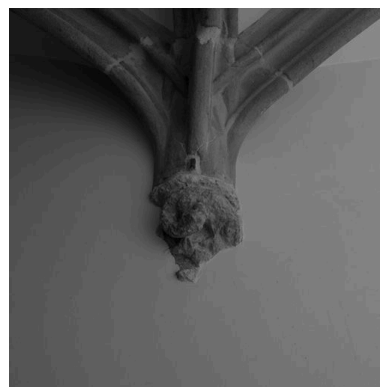
Voûte de l'allée, détail du culot 3 Phot. Eric Dessert IVR82_20046905852NUC
