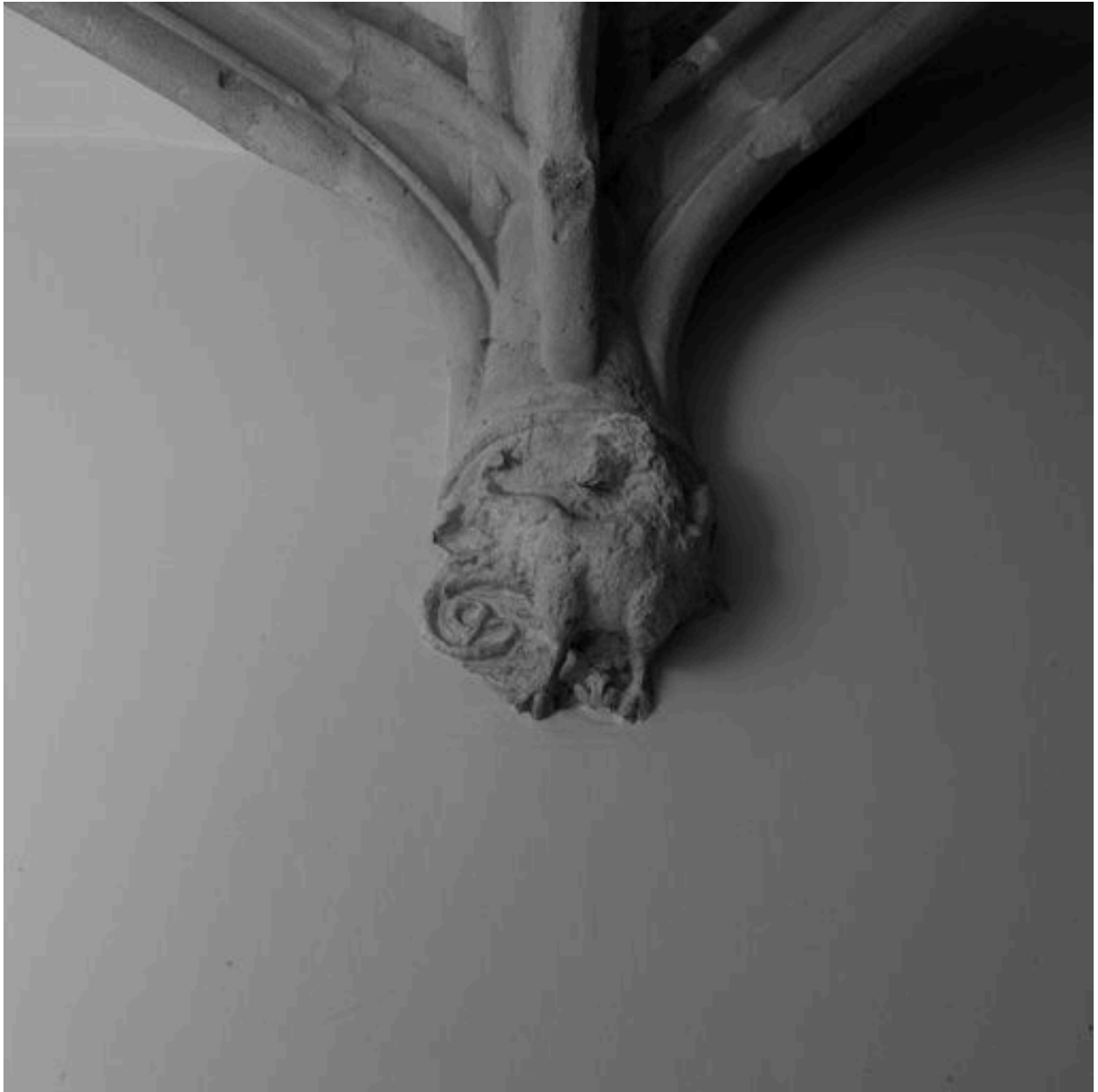
Voûte de l'allée, détail du culot 10
