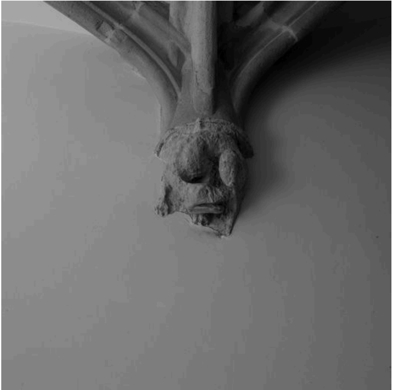
Voûte de l'allée, détail du culot 6
