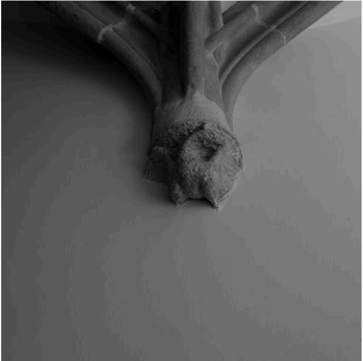
Voûte de l'allée, détail du culot 5
