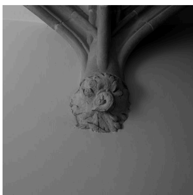
Voûte de l'allée, détail du culot 8 Phot. Eric Dessert IVR82_20046905847NUC
