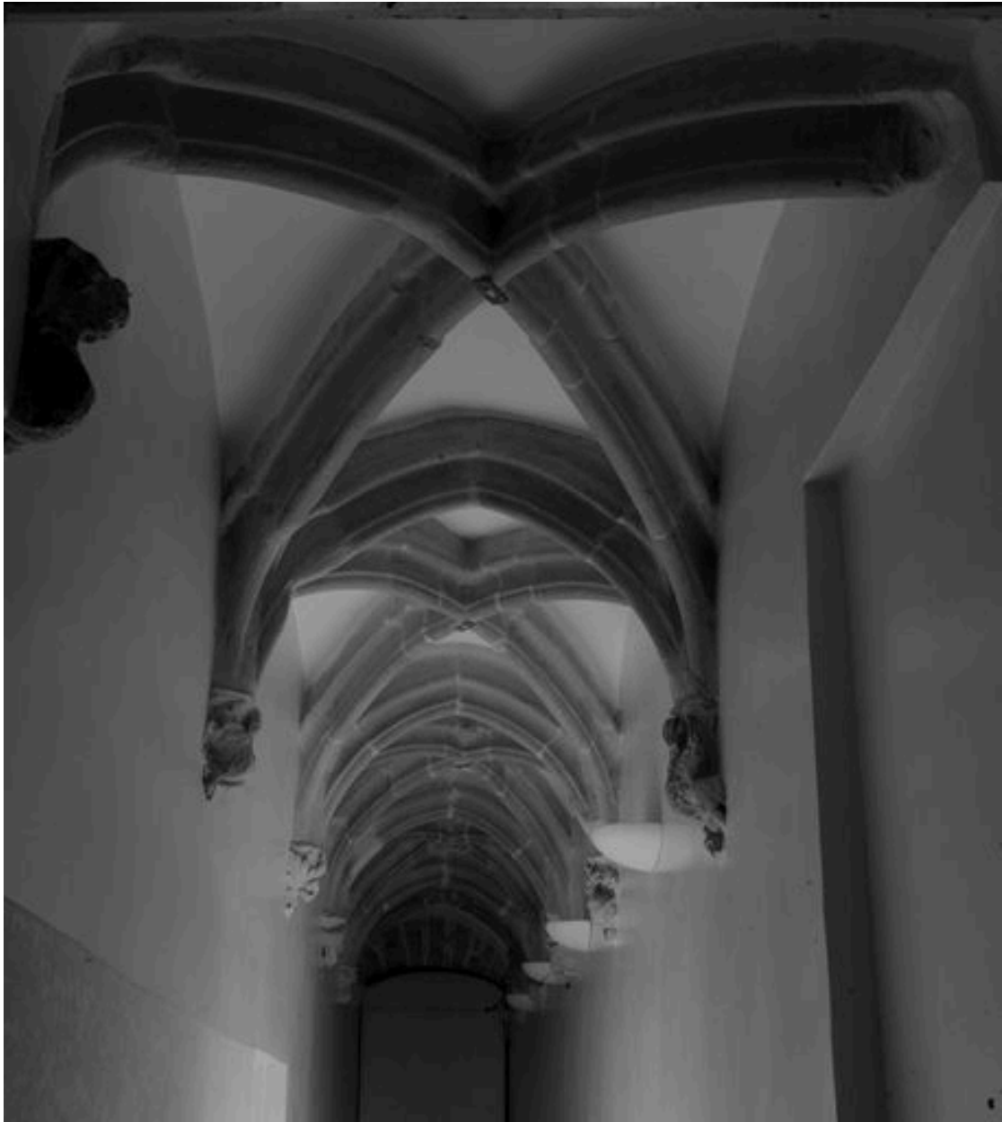
Voûte de l'allée, vue depuis la cour
