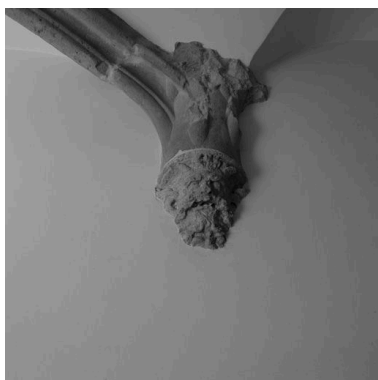
Voûte de l'allée, détail du culot 2 Phot. Eric Dessert IVR82_20046905854NUC
