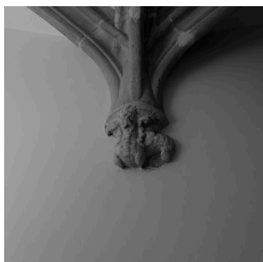
Voûte de l'allée, détail du culot 4 Phot. Eric Dessert IVR82_20046905851NUC
