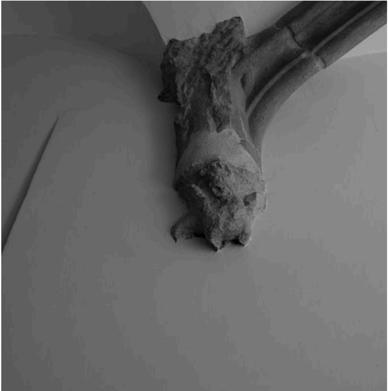
Voûte de l'allée, détail du culot 1
