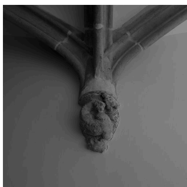
Voûte de l'allée, détail du culot 7 Phot. Eric Dessert IVR82_20046905848NUC
