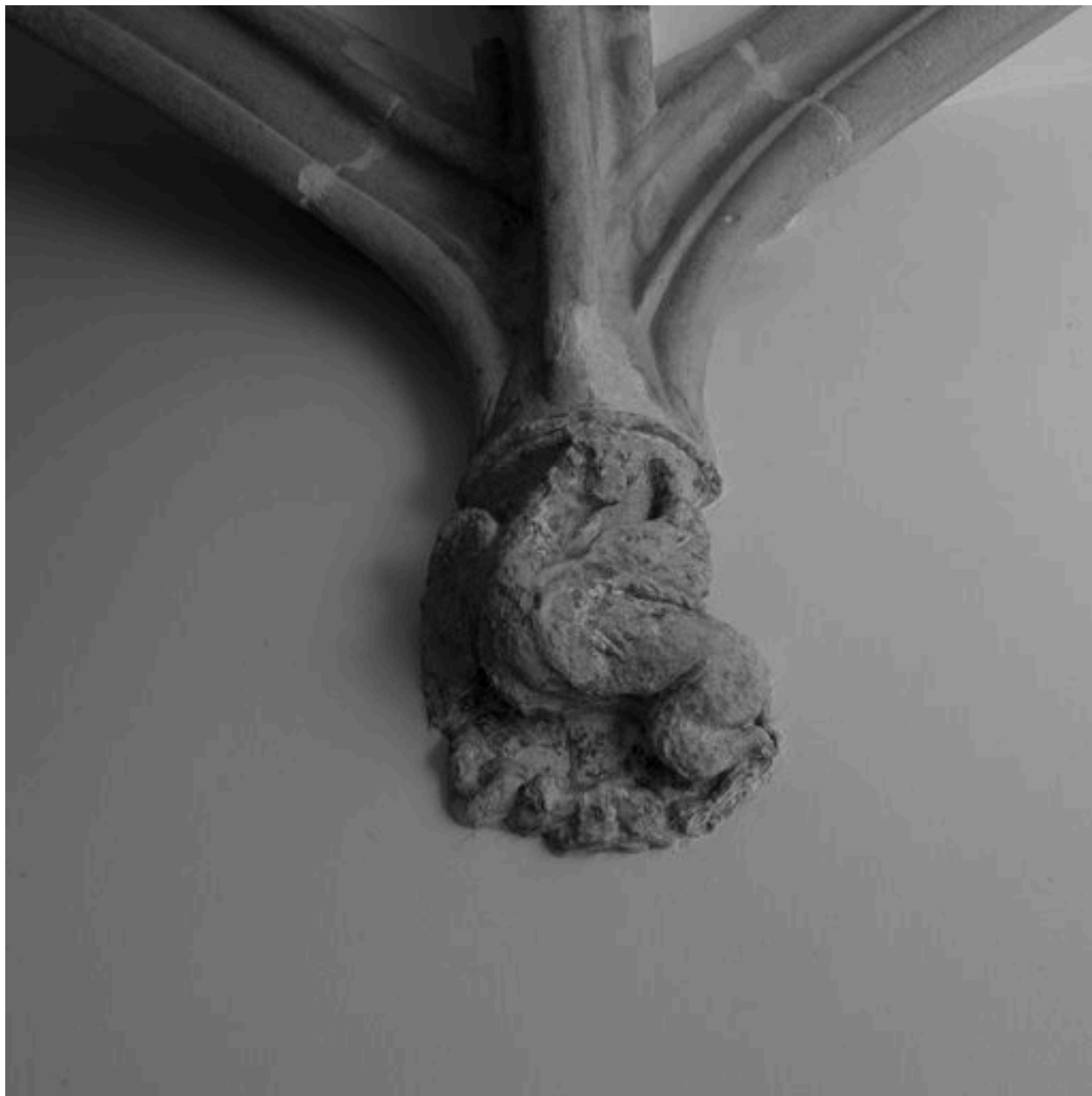
Voûte de l'allée, détail du culot 9
