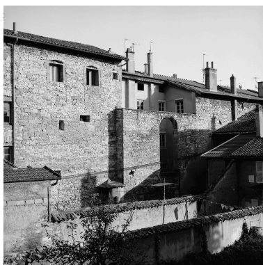
Vestiges des murs réutilisés de l'ancienne chapelle et du couvent. Phot. Jean-Marie Refflé IVR82_19900100313X
