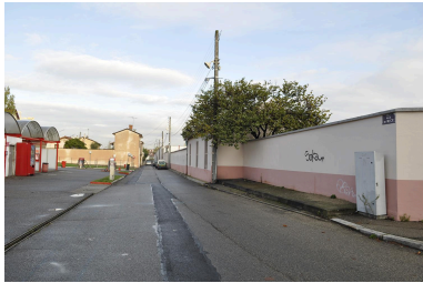
Site au moment de la démolition de la partie Givaudan-France en 2011 Phot. Nadine Halitim-Dubois IVR82_20116900429NUCA
