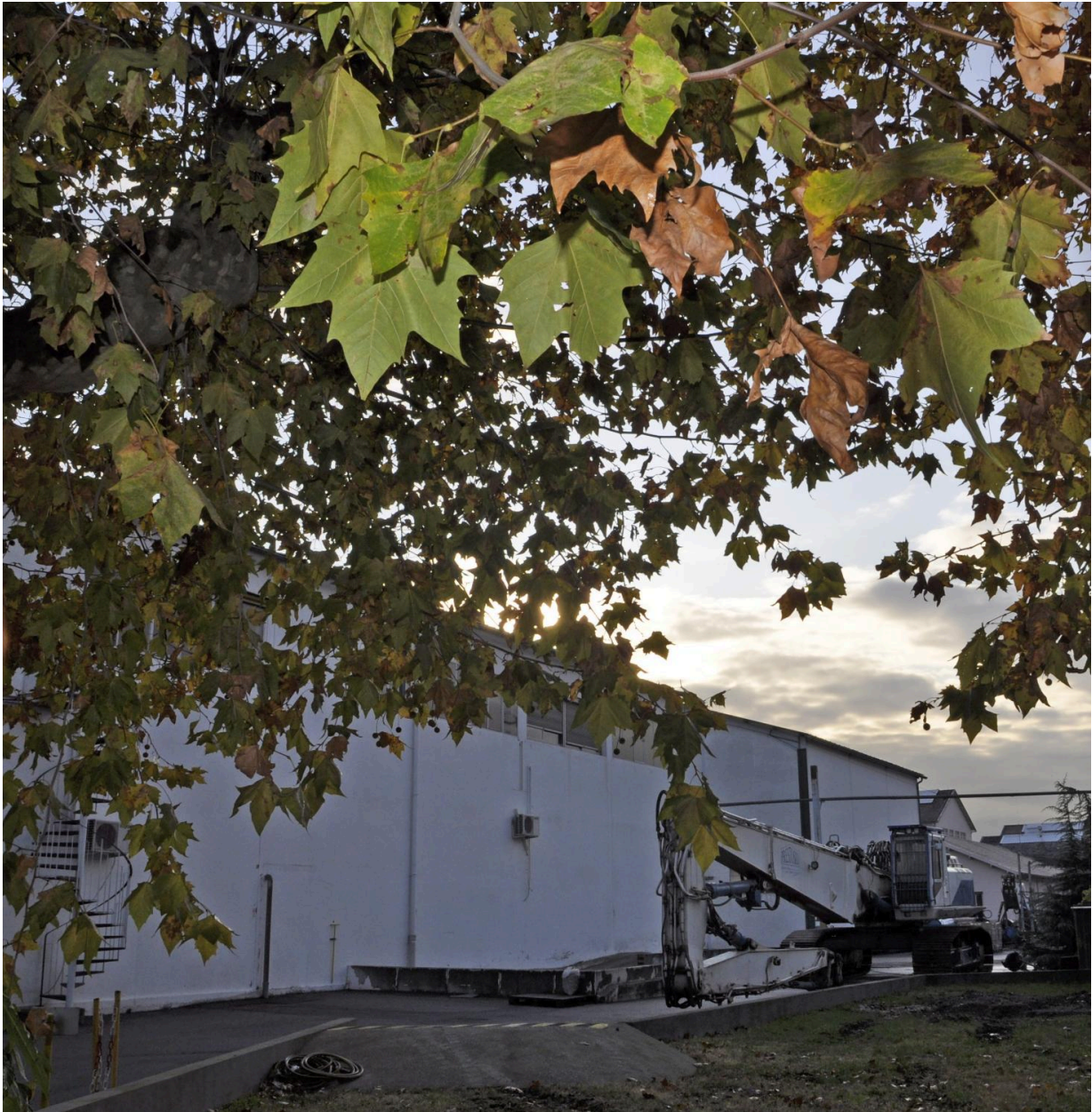
Site au moment de la démolition de la partie Givaudan-France en 2011
