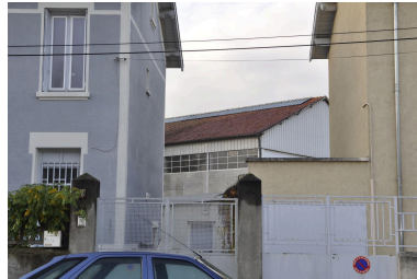
Site au moment de la démolition de la partie Givaudan-France en 2011 Phot. Nadine Halitim-Dubois IVR82_20116900404NUCA
