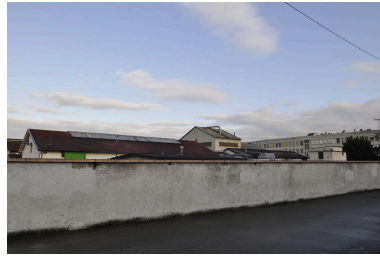
Site au moment de la démolition de la partie Givaudan-France en 2011 Phot. Nadine Halitim-Dubois IVR82_20116900409NUCA
