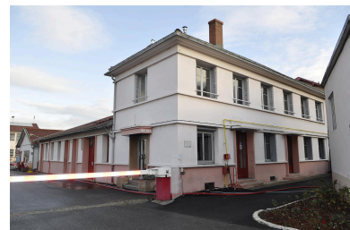
Site au moment de la démolition de la partie Givaudan-France en 2011 Phot. Nadine Halitim-Dubois IVR82_20116900413NUCA
