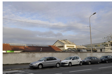
Site au moment de la démolition de la partie Givaudan-France en 2011 Phot. Nadine Halitim-Dubois IVR82_20116900437NUCA
