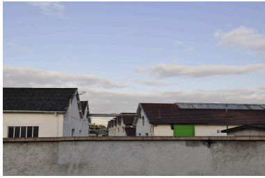
Site au moment de la démolition de la partie Givaudan-France en 2011 Phot. Nadine Halitim-Dubois IVR82_20116900411NUCA
