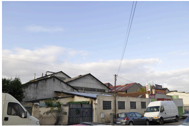
Site au moment de la démolition de la partie Givaudan-France en 2011 Phot. Nadine Halitim-Dubois IVR82_20116900408NUCA
