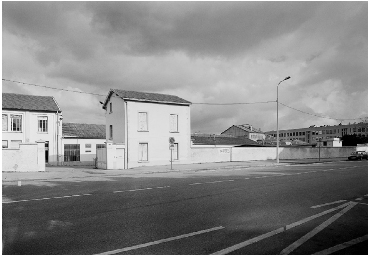
Vue d'ensemble sud-est
