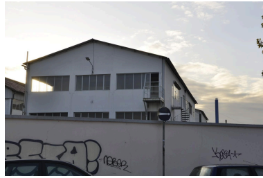
Usine Givaudan-France en 2011, bâtiment Phot. Nadine Halitim-Dubois IVR82_20116900402NUCA
