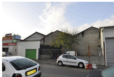
Site au moment de la démolition de la partie Givaudan-France en 2011 Phot. Nadine Halitim-Dubois IVR82_20116900407NUCA
