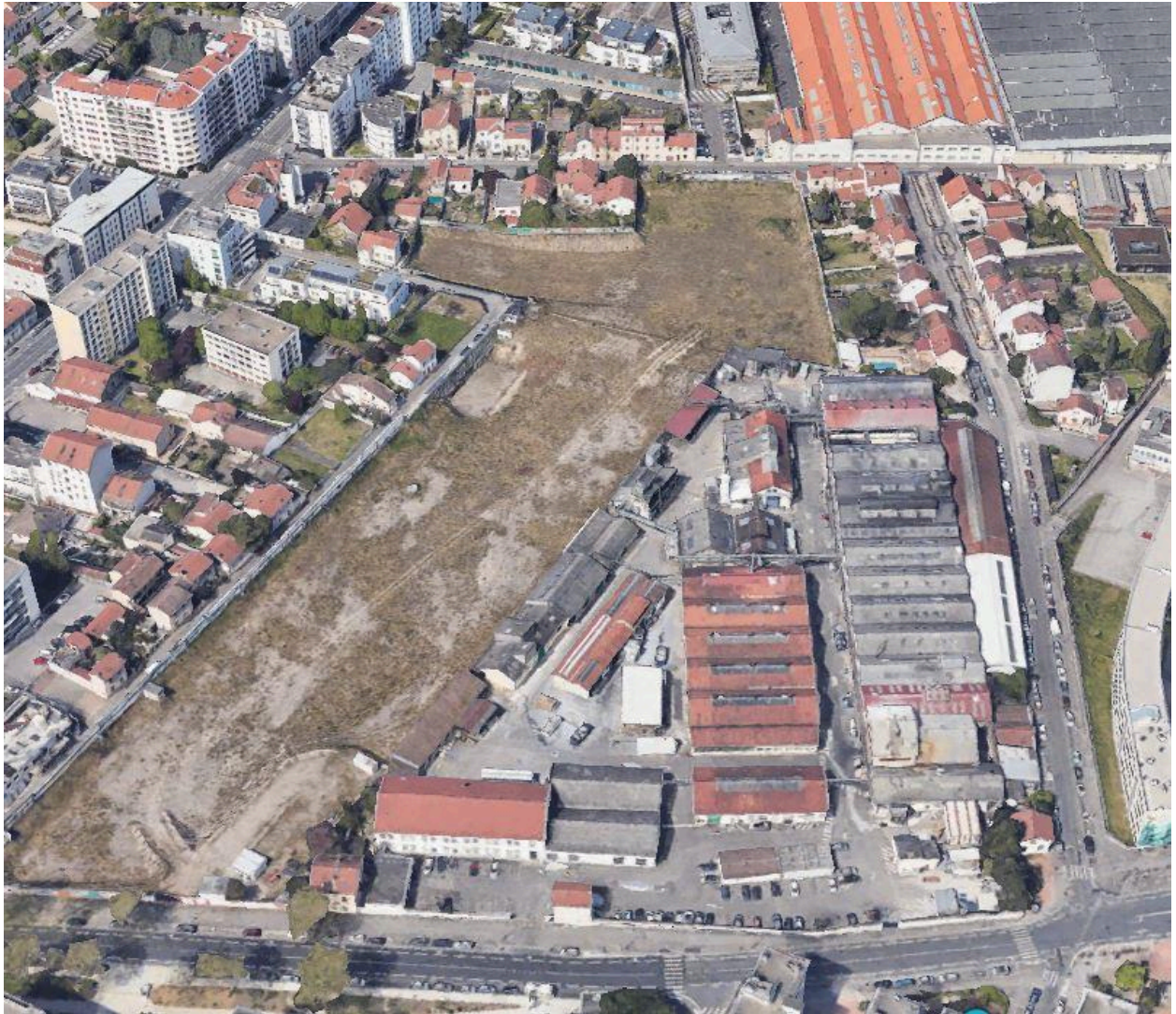
Vue Google du site après démolition
