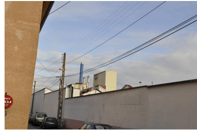
Site au moment de la démolition de la partie Givaudan-France en 2011 Phot. Nadine Halitim-Dubois IVR82_20116900431NUCA
