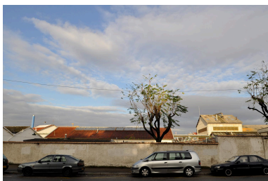
Site au moment de la démolition de la partie Givaudan-France en 2011 Phot. Nadine Halitim-Dubois IVR82_20116900439NUCA
