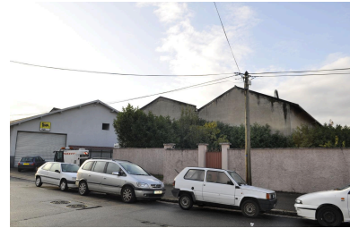
Site au moment de la démolition de la partie Givaudan-France en 2011 Phot. Nadine Halitim-Dubois IVR82_20116900405NUCA
