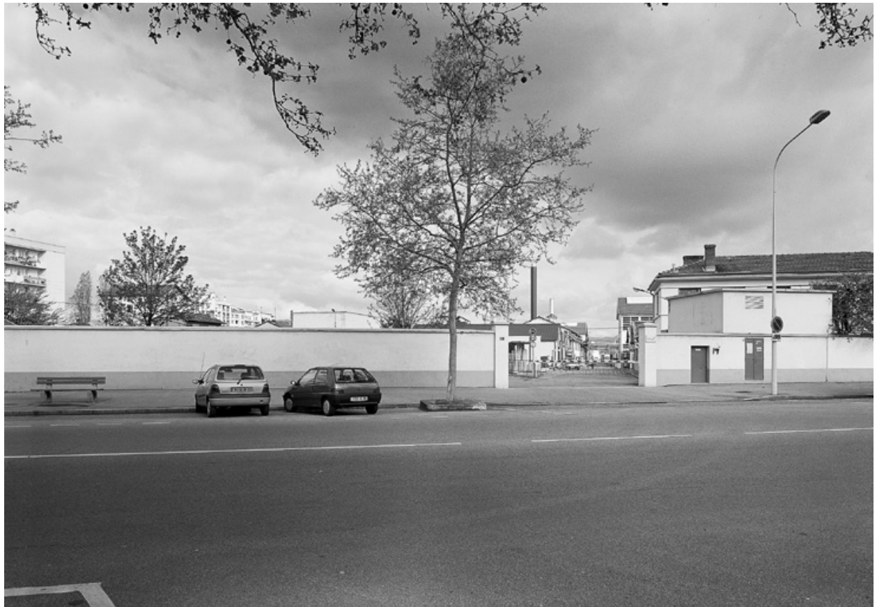
Entrée livraison, vue est
