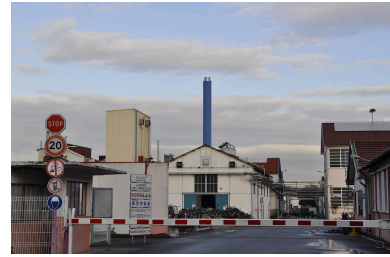
Site au moment de la démolition de la partie Givaudan-France en 2011 Phot. Nadine Halitim-Dubois IVR82_20116900412NUCA
