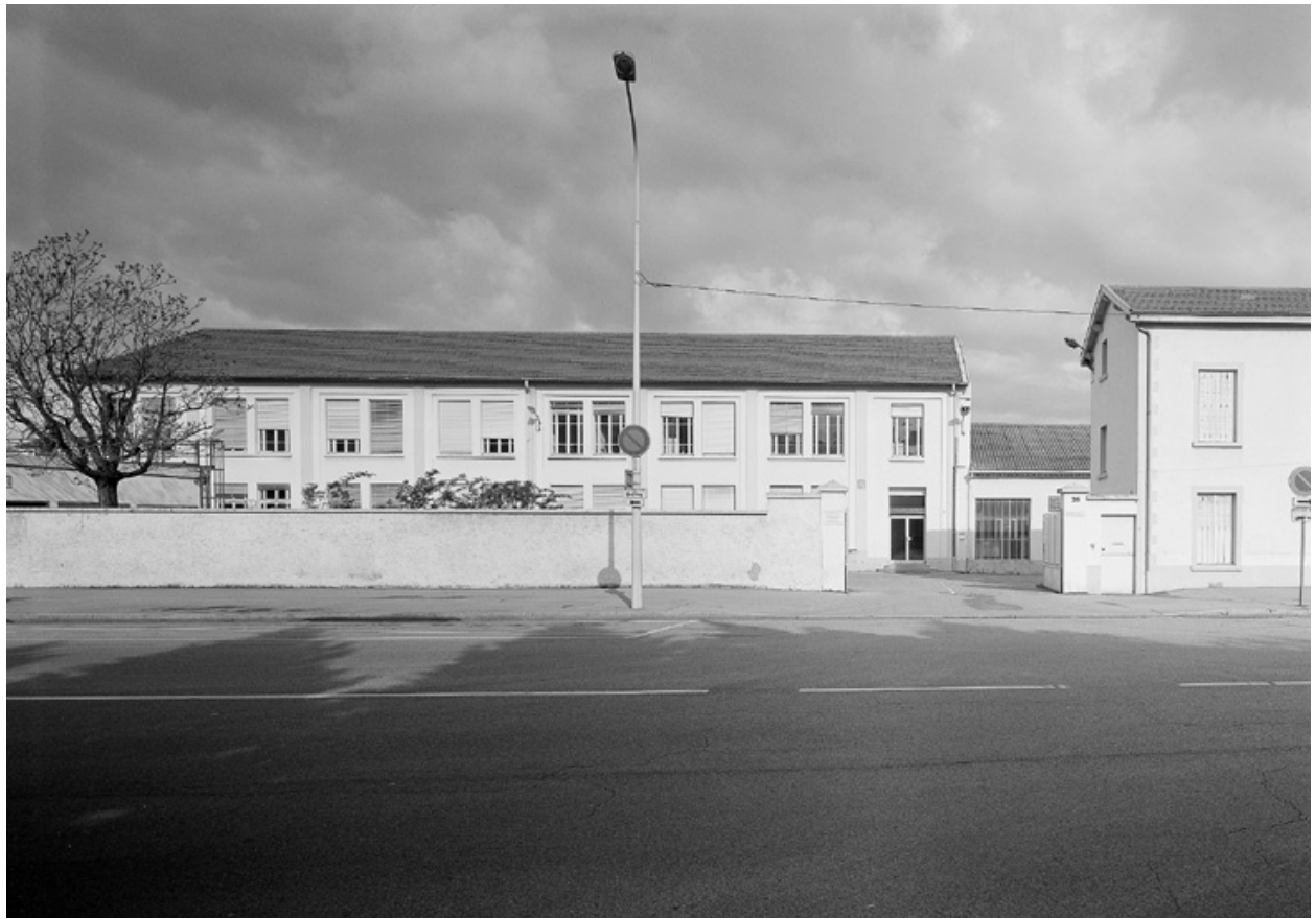
Vue générale, entrée principale vue est
