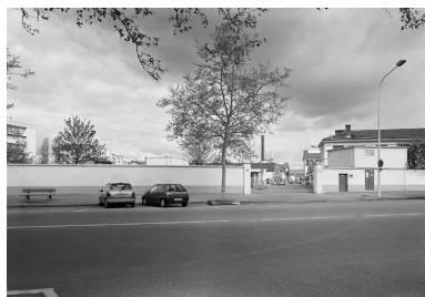
Entrée livraison, vue est Phot. Martial Couderette IVR82_20016903154P
