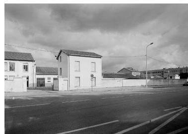
Vue d'ensemble sud-est Phot. Martial Couderette IVR82_20016903153P
