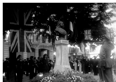
Inauguration du monument Repro. François Fouger IVR82_20057300949NUCB
